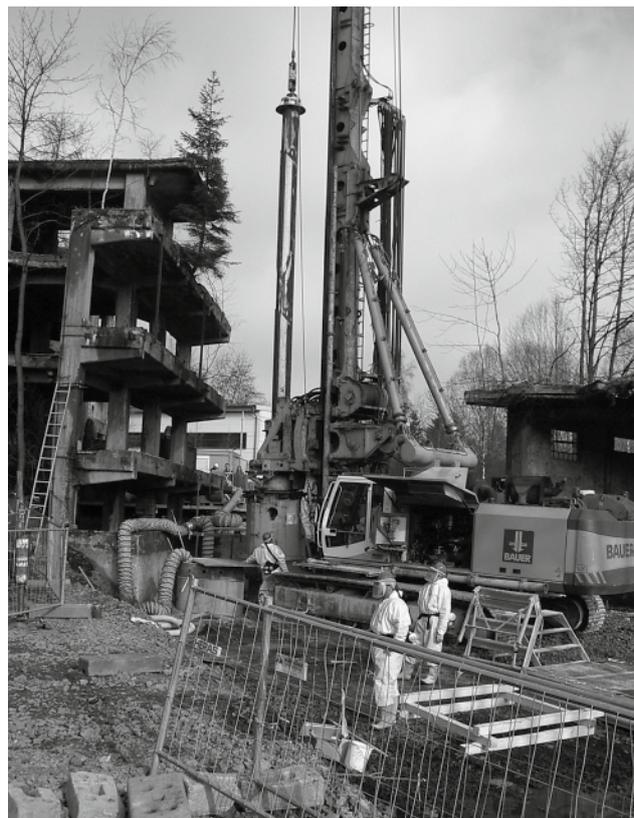
Abbildung 5: Großlochbohrgerät
