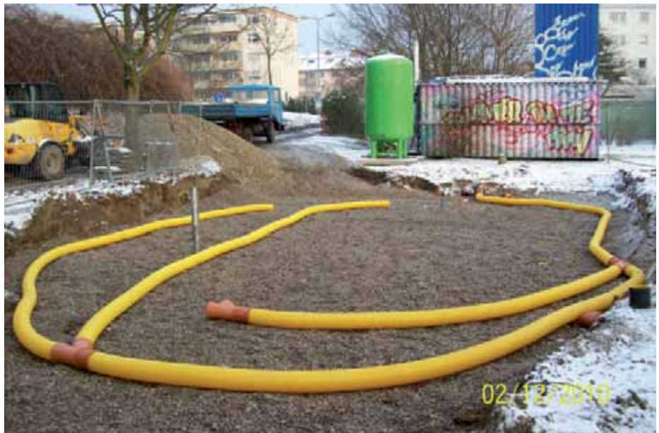
Austausch der Kiesfüllung der Versickerungsrigole
