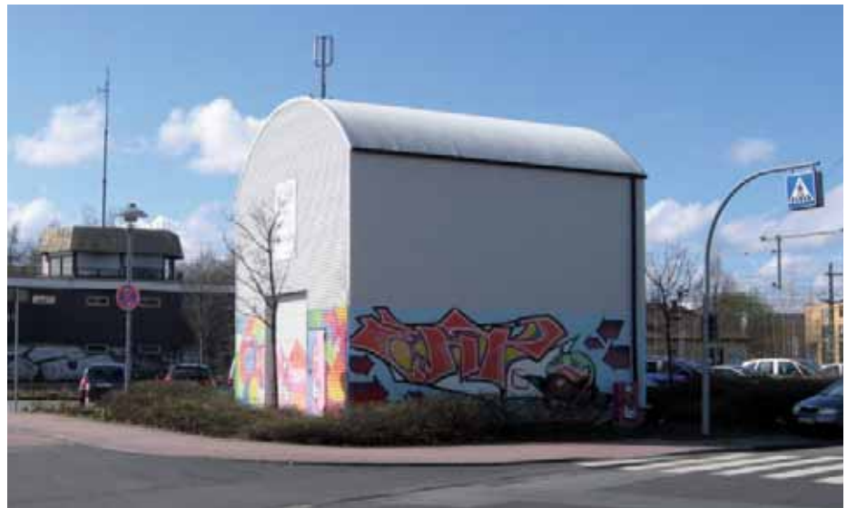
Betriebshalle der Grundwasseraufbereitungsanlage mit gestaltetem Graffiti
