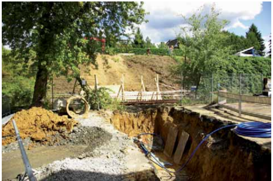
Unterquerung der Gleistrasse im Zuge der Anlagenerweiterung
