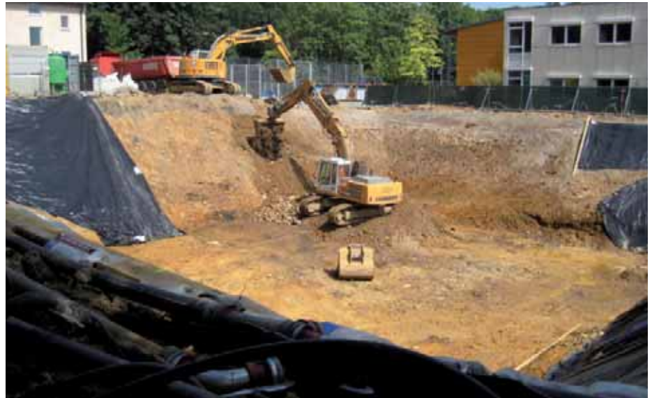
Sanierungsgrube ehem. Kleingaswerk im Endzustand
