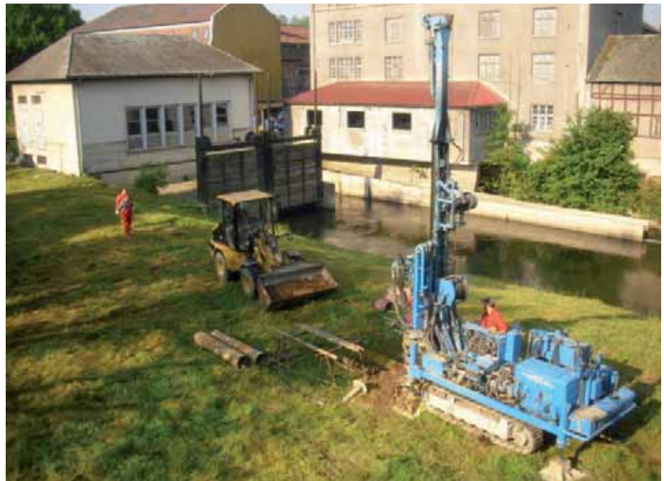
Bohrarbeiten zur Eingrenzung der Schadstofffahne
