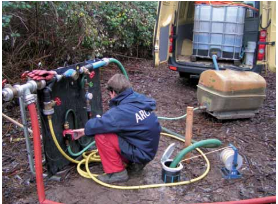
Hanau, Merten-Gelände: Melasseinjektion
