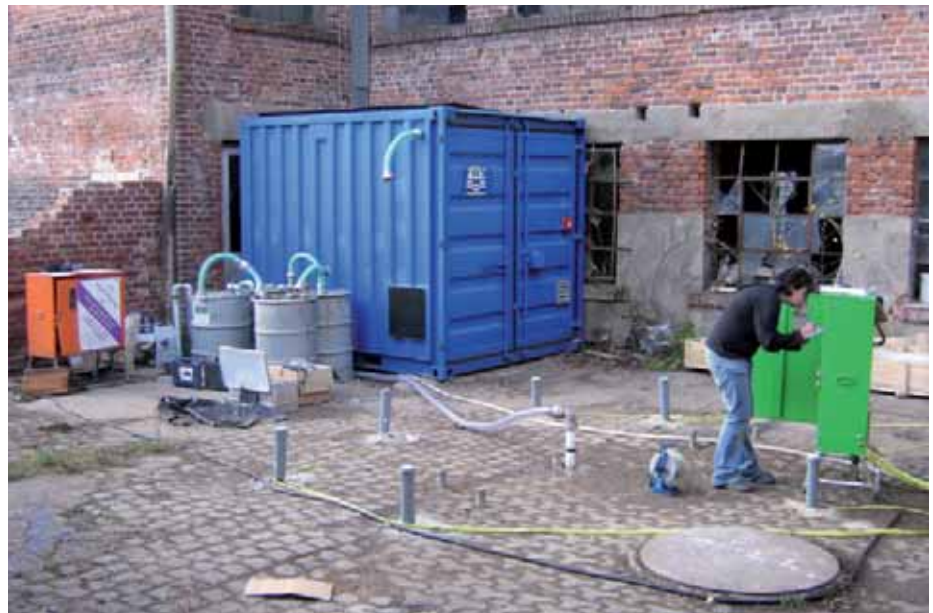
Versuchsfeld des THERIS-Pilotversuchs im Innenhof der Lederfabrik
