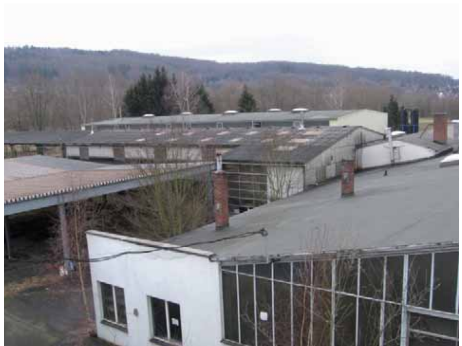
Übersicht Produktionshallen der ehem. Fa. VOGT
