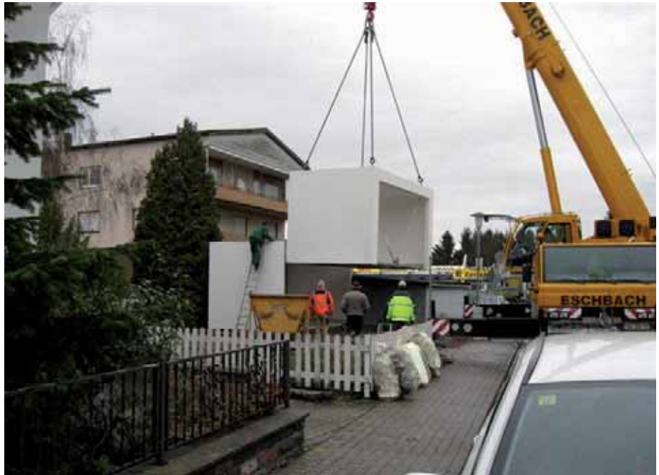
Anlieferung der Fertigteilgarage (Einhausung der kombinierten Grundwasser- und Bodenluftsanierungsanlage)
