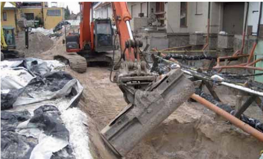
Aushub unter gesicherten Entsorgungs- und Versorgungsleitungen im 5. Sanierungsabschnitt
