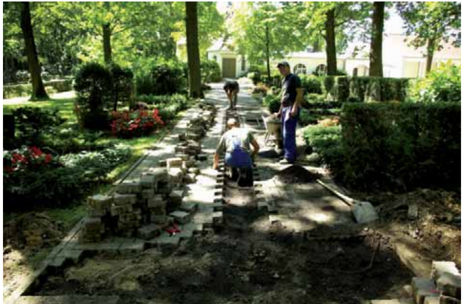
Anschluss der Sanierungsbrunnen zur Umsetzung der EAB-Maßnahme
