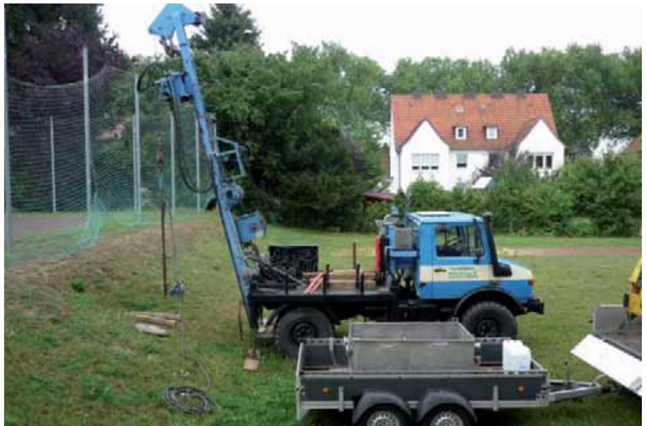
Regenerierung der Filterstrecke eines Sanierungsbrunnens (GWM 20)
