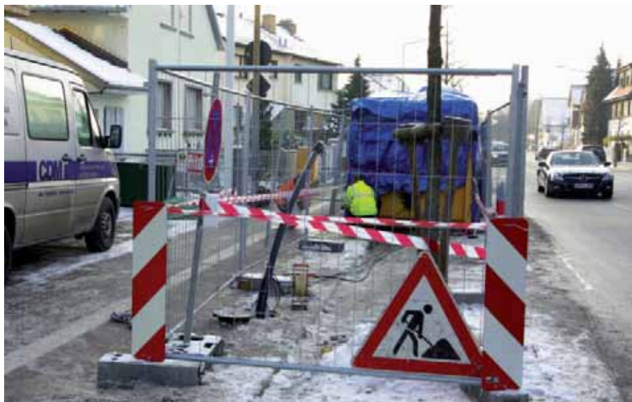
Durchführung eines Pumpversuchs an der Messstelle GWM 17
