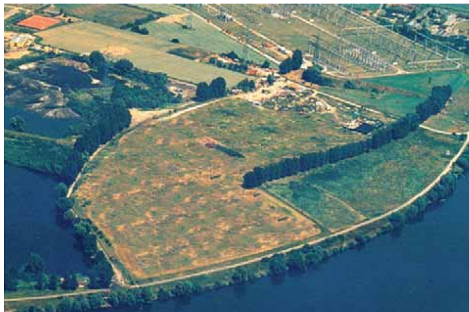
Blick von Südwesten auf die unmittelbar am Main gelegene Altdeponie
