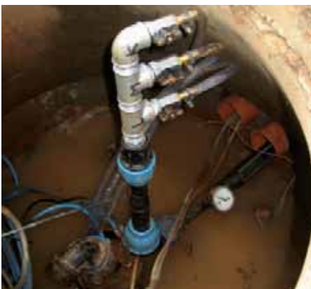
Infiltration von Natriumlaktat in GWM 2
