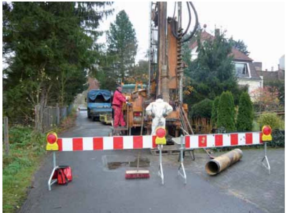
Errichten eines weiteren Sanierungsbrunnens („Auf dem Hasenstock“)
