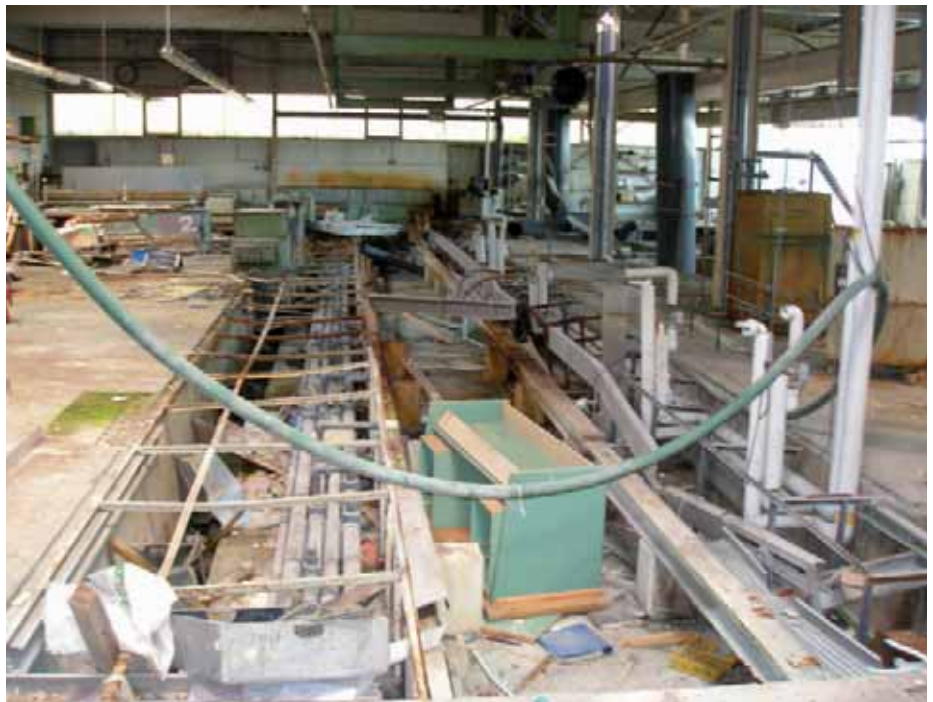
Blick in die Werkshalle
