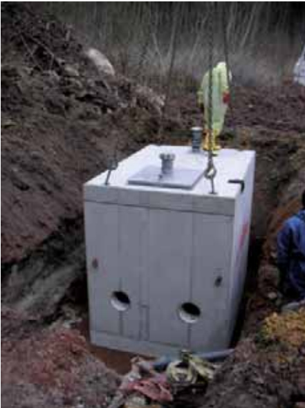
Schachtbauwerk im Zulauf der WAA
