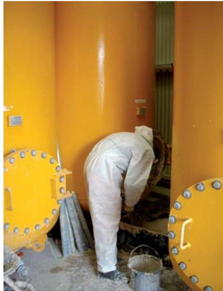
**Wechsel des Adsorbergranulats in der Grundwassersanierungsanlage**
