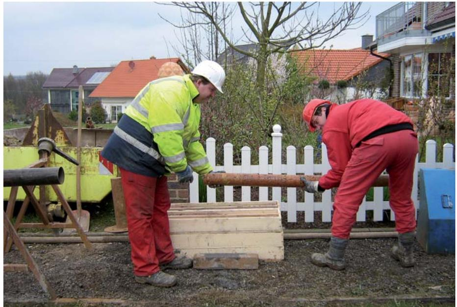
**Sicherung der Bohrkern aus der Tiefenbohrung in dem Kluftgrundwasserleiter**
