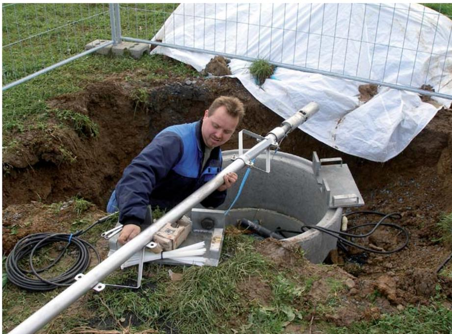
**Einbau der Steigleitung im neuen Sanierungsbrunnen**
