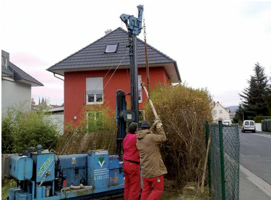
Messstellenrückbau zum Abschluss der Sanierungsmaßnahme, Dezember 2009
