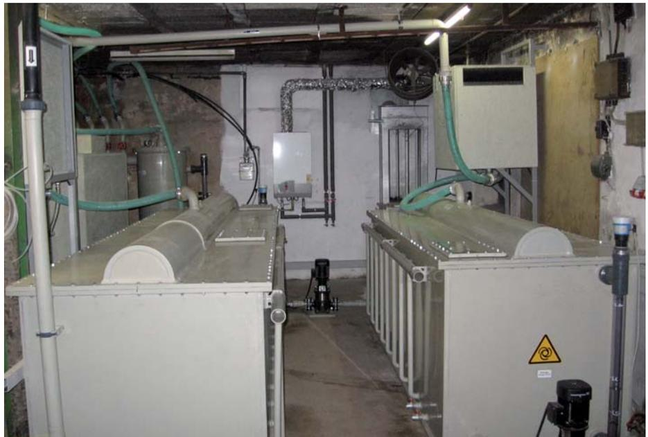
Horizontalstripper der Grundwasserreinigungsanlage
