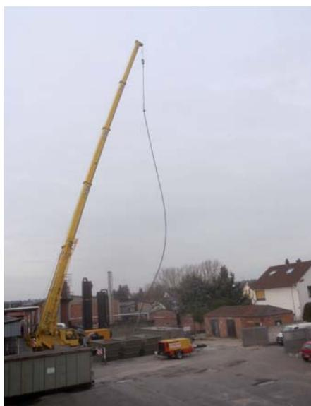
**Einbau der Brunnenpumpe im neuen Sanierungsbrunnen**
