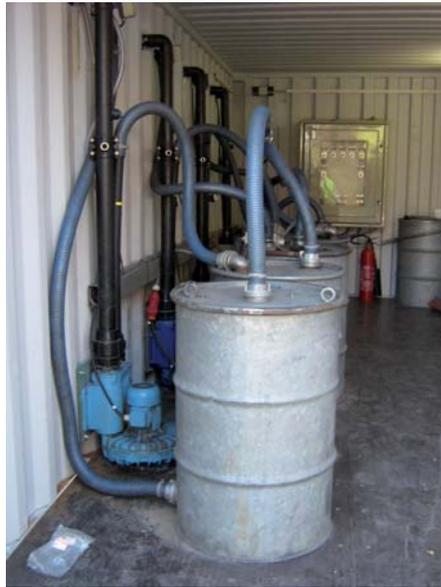
*Verdichter, Abscheider und Aktivkohlebehälter der Grundwasserreinigungsanlage am ehem. Werk I (Sudetenstraße)*
