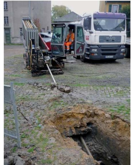
**Horizontalspülbohrung zum Anschluss von Sanierungsbrunnen an die Grundwasserreinigungsanlage**
