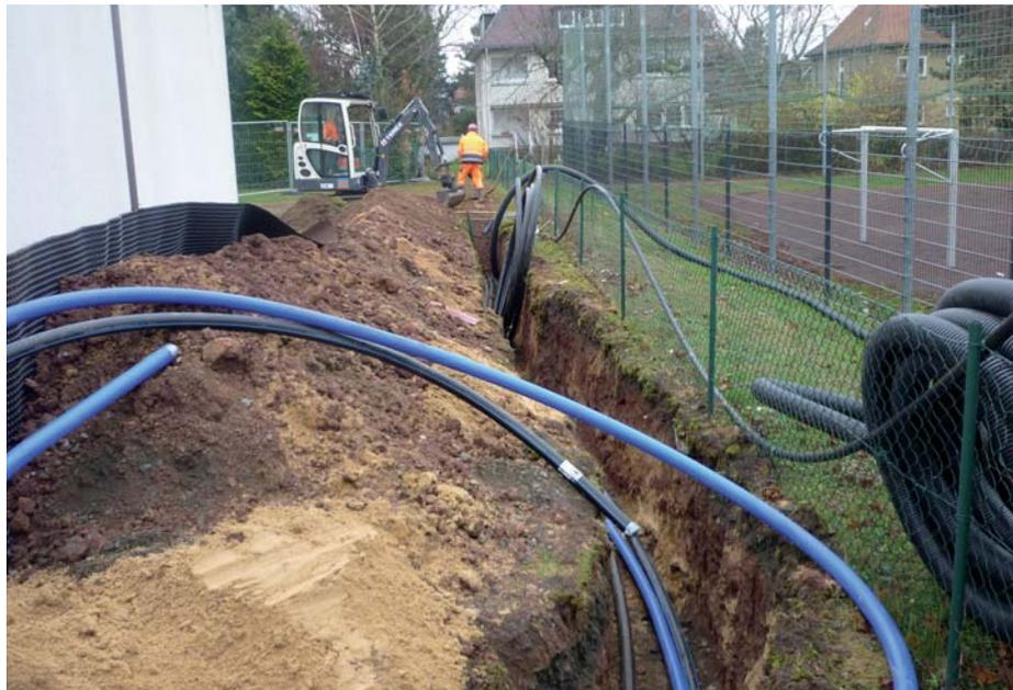
**Leitungsverlegung zum Anschluss von drei neuen Sanierungsbrunnen**
