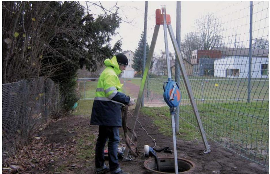
**Einbau der Brunnenpumpe in neuen Sanierungsbrunnen**
