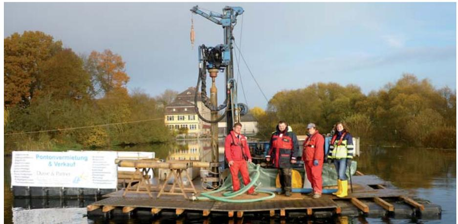
**Aufschlussbohrung in die Edersohle zur Untersuchung des Baugrundes**
