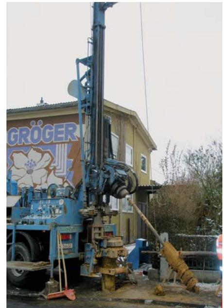
**Bau der neuen Grundwassermessstelle GWM 27**
