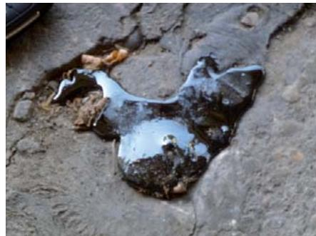
**Austritt von Teeröl aus dem Fußboden im ehemaligen Produktionsbereich**
