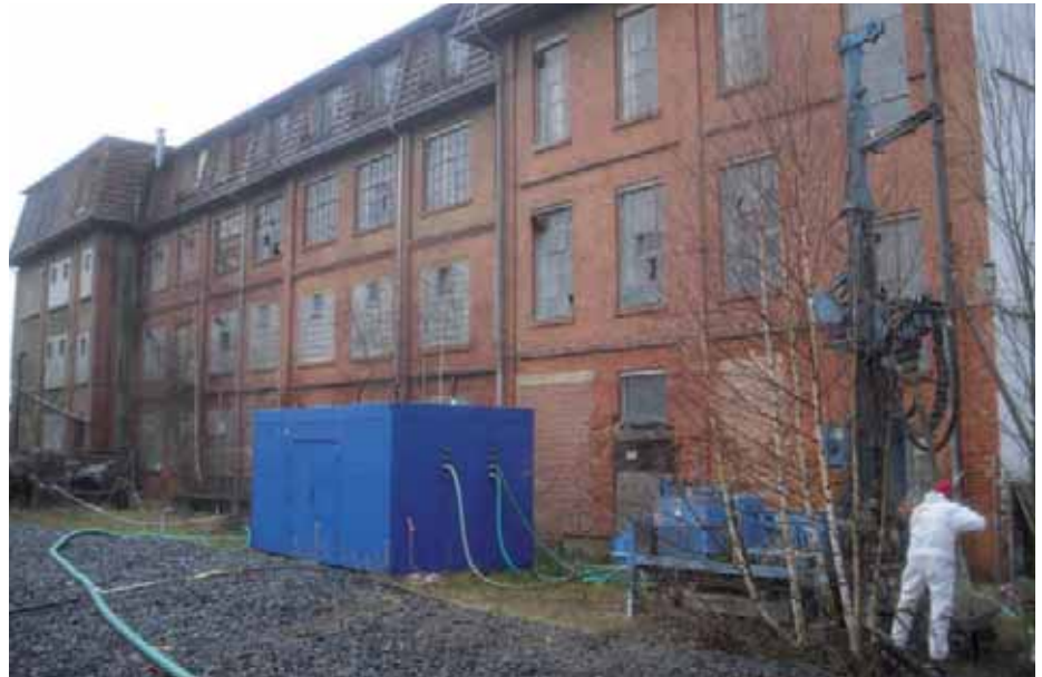
Installation von Injektionslanzen für die Air Sparging-Anlage
