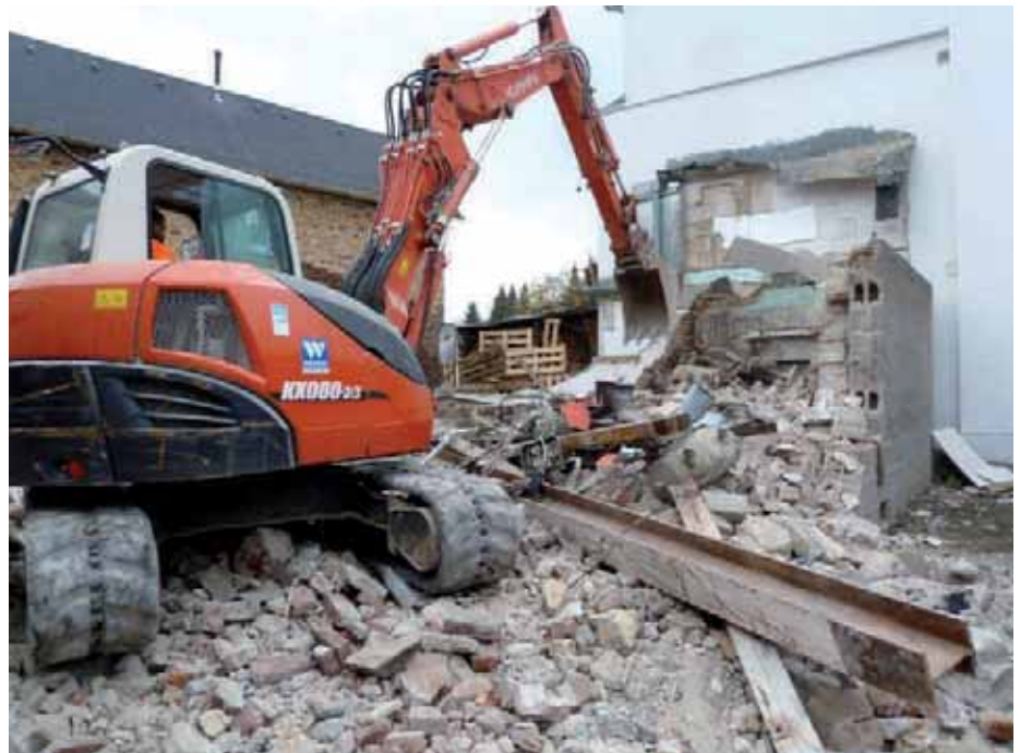
Abriss des Wäschereigebäudes
