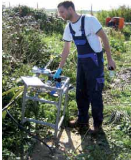
Kontrolle der Melasse-Injektion
