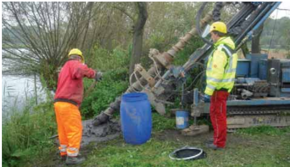
Schrägbohrung in die Edersohle
