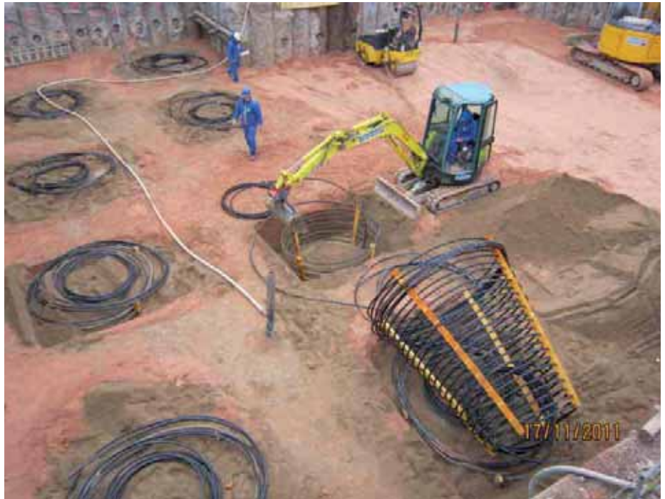
Einbau der Erdwärmekörbe
