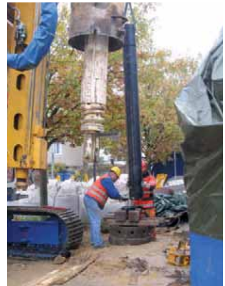
Errichtung Infiltrationsbrunnen IB 2
