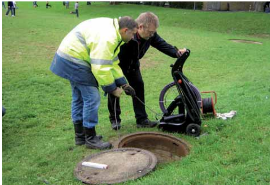
Regenerierung eines Sanierungsbrunnens im Grundwasserabstrom
