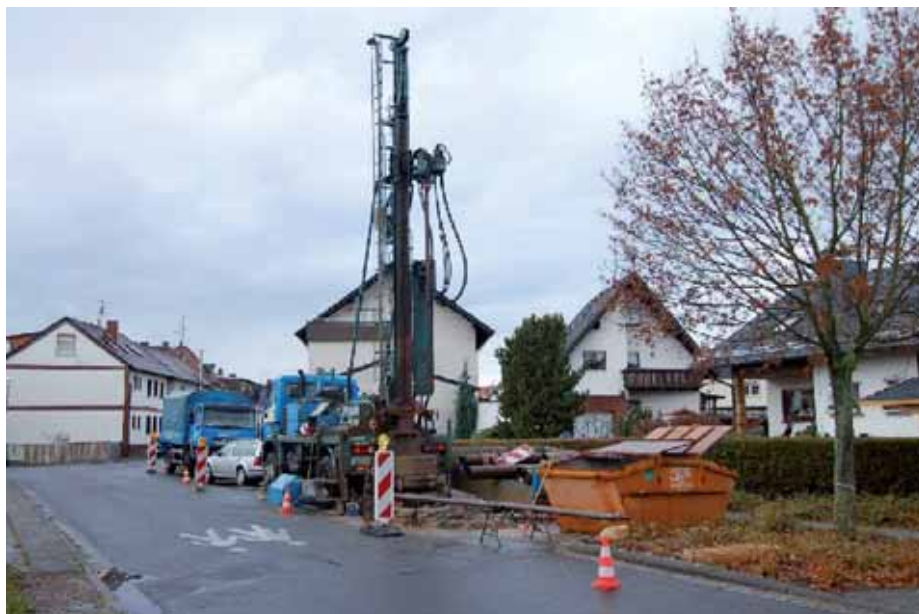
Errichtung einer Grundwassermessstelle im tieferen Grundwasserleiter
