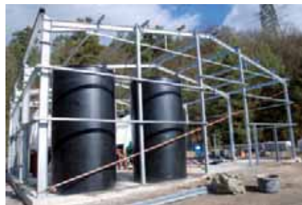
Bau der Wasseraufbereitungsanlage
