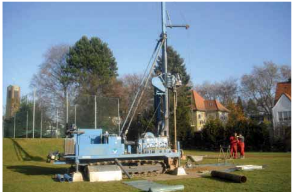
Erichtung eines neues Sanierungsbrunnens (GWM 63)
