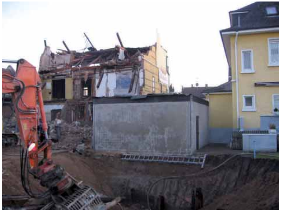
Rückseite des ehemaligen Hotelgebäudes während des Rückbaus
