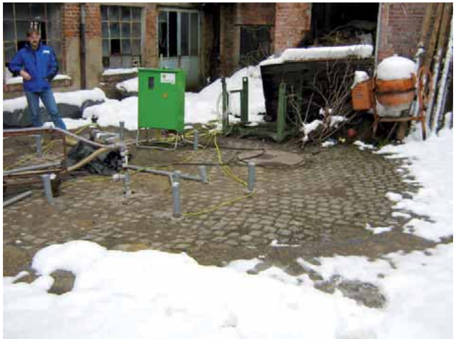
Theris-Pilotfeldversuch in Betrieb - Blick auf den aufgeheizten Bereich
