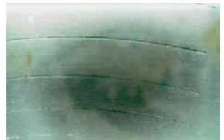
Kamerabefahrung zur Erfolgskontrolle der Brunnenreinigung
