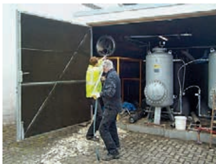
Wartungsarbeiten an der Wasseraufbereitungsanlage
