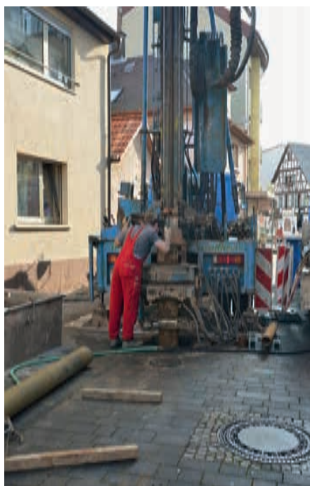
Linerbohrung
