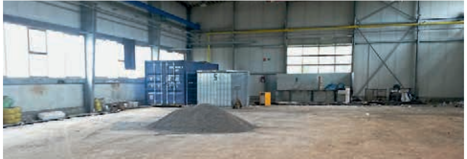
ehemalige Werkshalle, im Hintergrund Container der WAA
