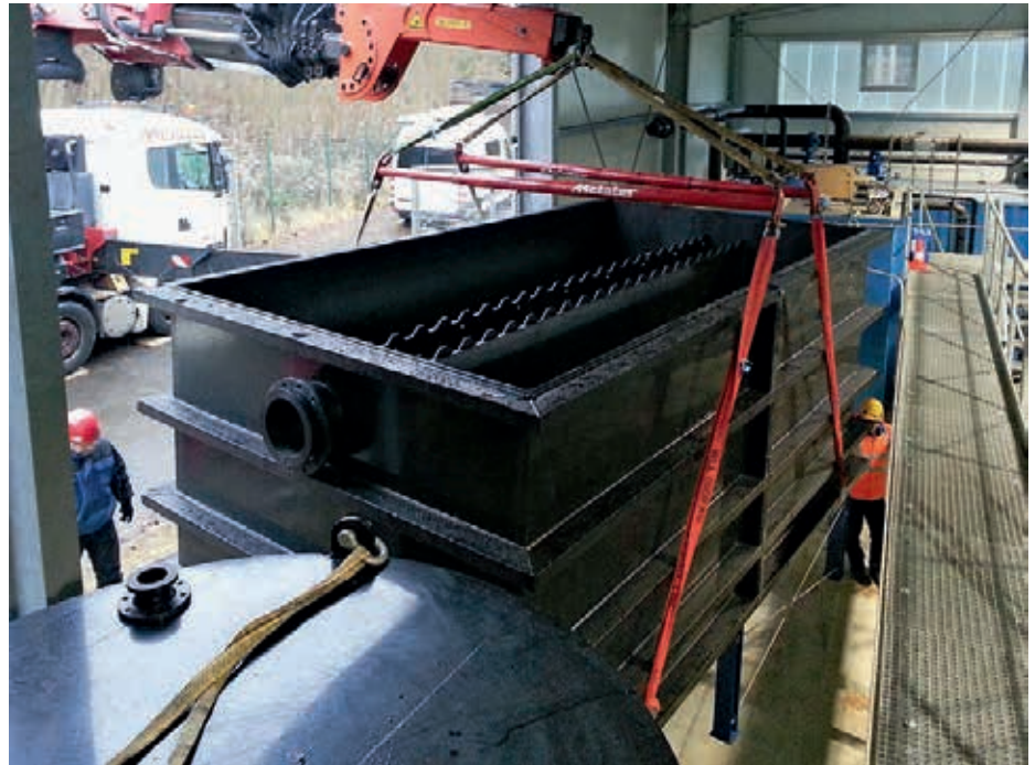
Einbau des neuen Schrägklärers im Dezember 2014
