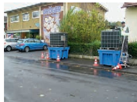
ISCO-Pilotversuch: Infiltrationsphase
