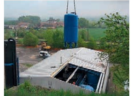
Wechsel des Wasseraktivkohlefilters
