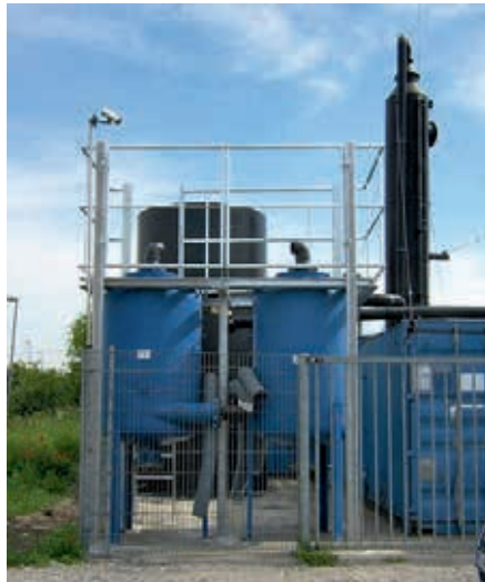
Arbeitsgerüst für die Luftaktivkohleeinheit
