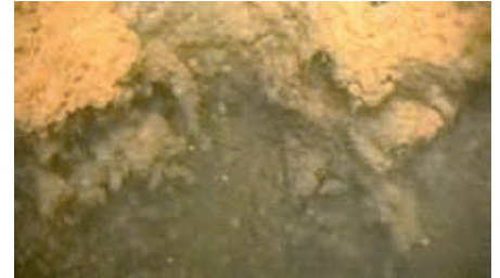
Kamerabefahrung vor Ausführung der Brunnenreinigung
