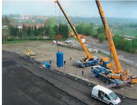
Wechsel des Wasseraktivkohlefilters
