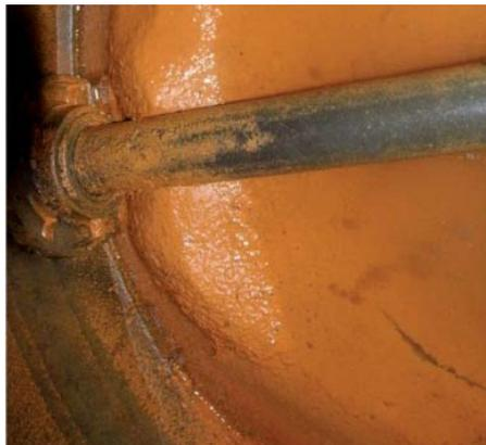
*Eisenschlammebelegung im 1. Wasseraktivkohlefilter (rechts unbelegter 2. Filter)*
