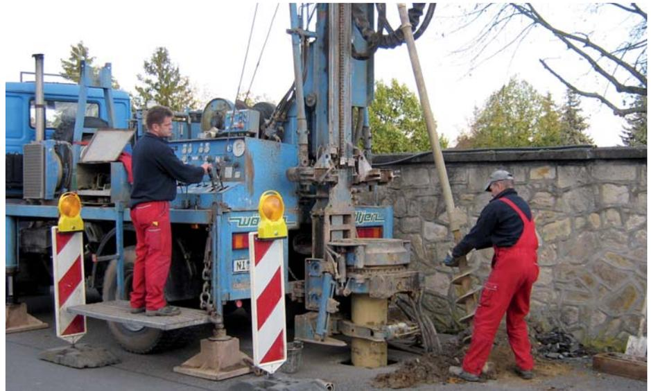
**Bohrarbeiten zur Herstellung einer Grundwassermessstelle**
