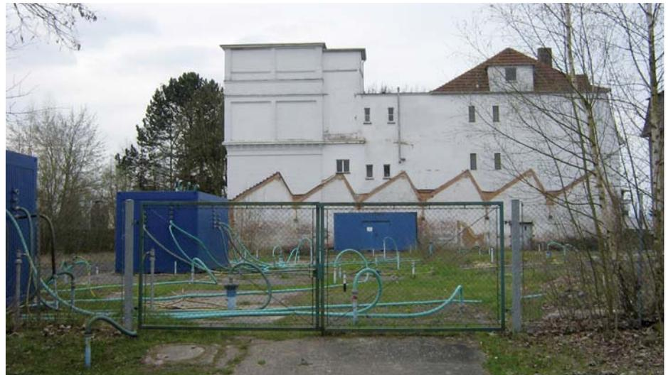
ehem. Betriebsgelände mit Bodenluftabsauganlage
