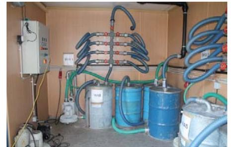
Innenansicht einer Bodenluftabsauganlage
