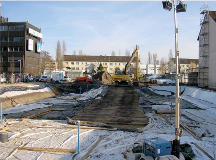
**Baugrube innerhalb der Dichtwand**
