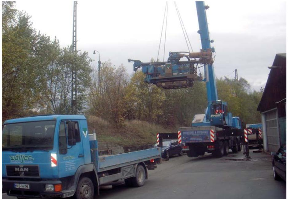
**Kraneinsatz für Messstellenbau im Bereich der Bahngleise**
