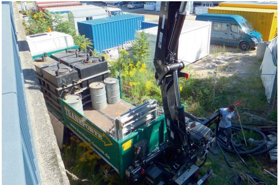
Rückbau der Grundwasserreinigungsanlage auf dem ehem. Betriebsgelände
