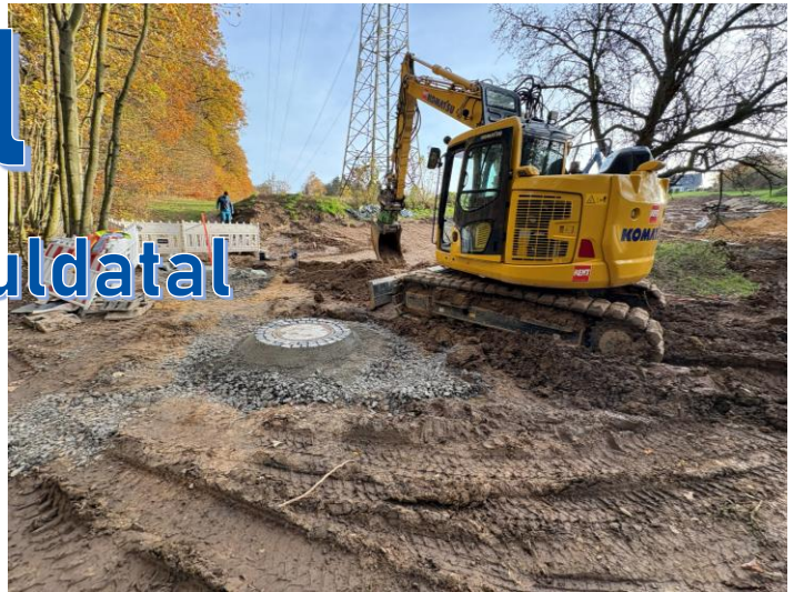
Grundwasserabstromsicherung unterflur nach Fertigstellung
