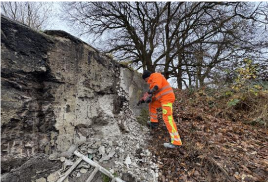
Manuelle Entfernung von Spritzbeton von oberer Stützmauer
