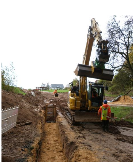
Umbaumaßnahme für die drucklose Abstomsicherung
