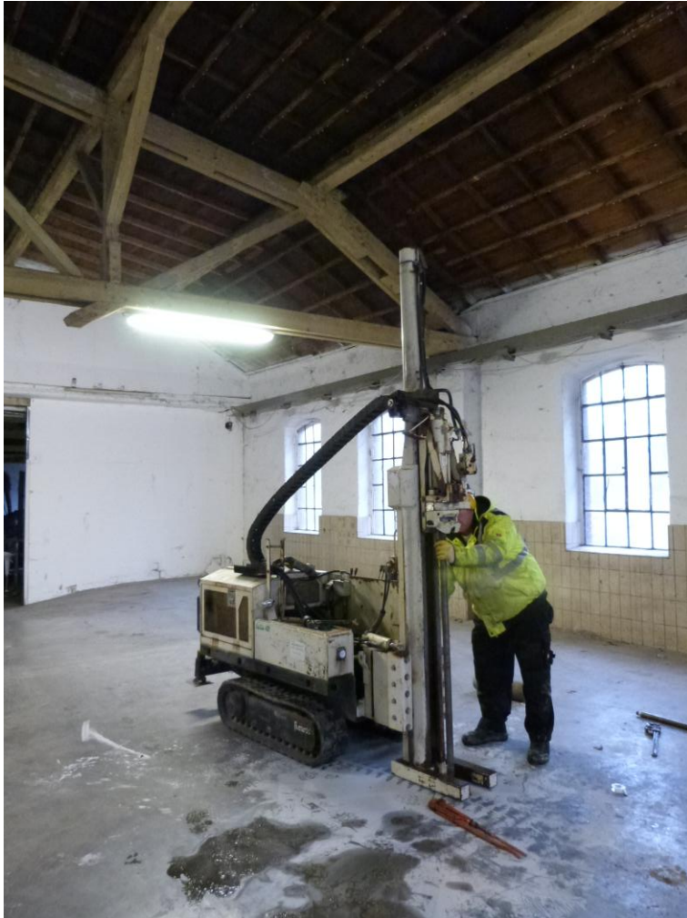
DP-Sondierung zur Wirkstoffinjektion
