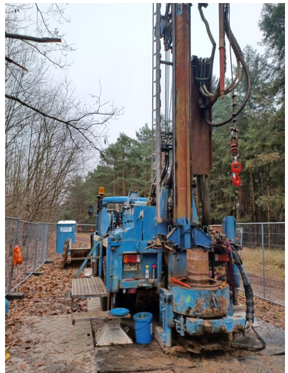
Bohrarbeiten im Rahmen der Grundwassererkundung
