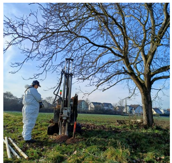
Messstellenbau im Mainvorland
