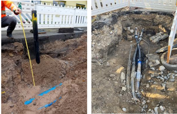
Im Rahmen der Straßenbaumaßnahme freigelegte Sanierungsleitungen
