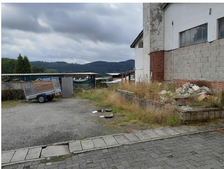
Kanalsystem und Messstellen an der südlichen Grundstücksgrenze
