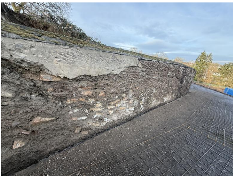
Entfernung von altem Spritzbeton von oberer Stützmauer
