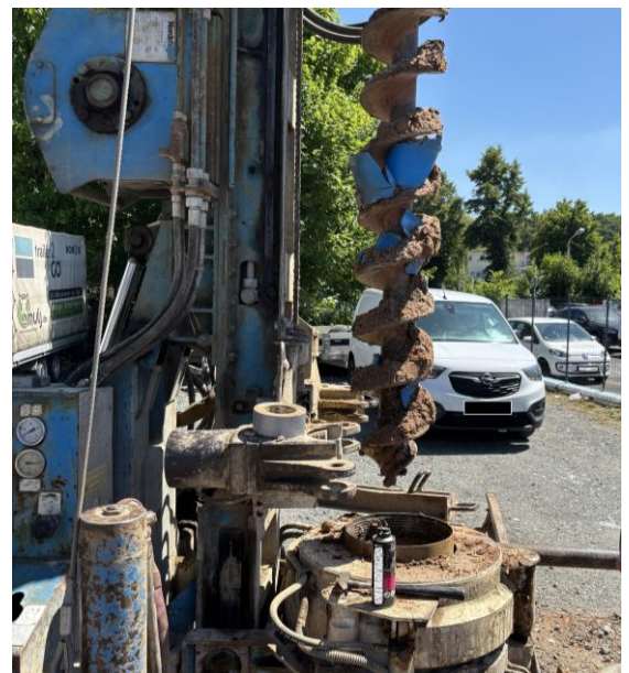
Neuerrichtung der zerstörten GWM
