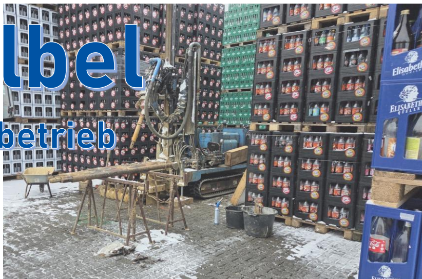
Errichtung einer Grundwassermessstelle
