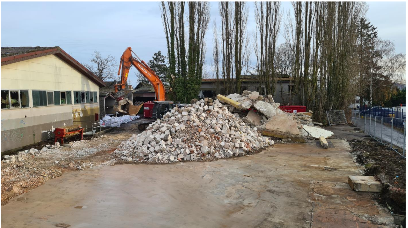
Abgebrochenes Ober- und Erdgeschoss von Halle 4
