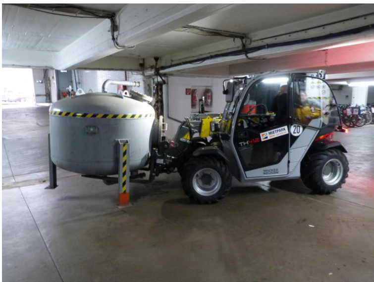
Rückbau der Grundwasserreinigungsanlage
