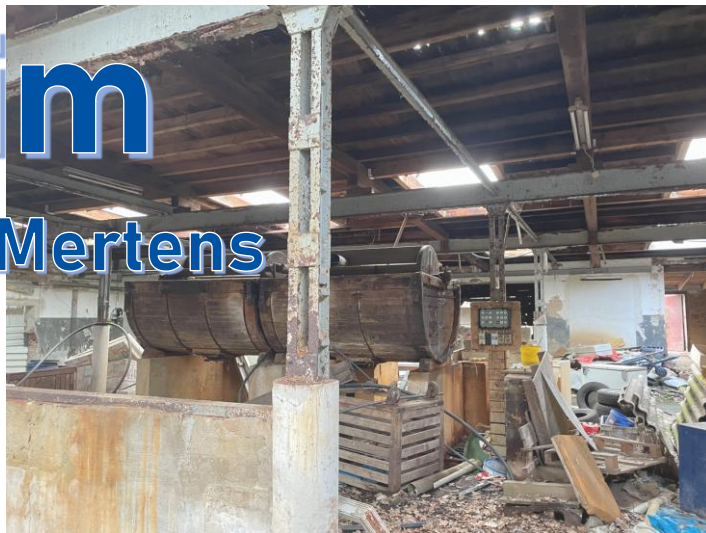
Bauliche Situation in der „Alten Wasserwerkstatt“
