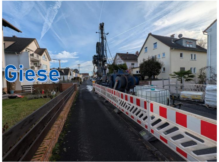
Bohrarbeiten in der Feldbergstraße (12/2025)
