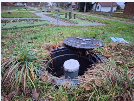
Sanierte Minigolfanlage mit Grundwassermessstelle in der Ortslage Richelsdorf
