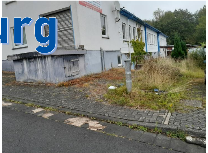
Blick entlang der südlichen Grundstücksgrenze auf Halle 1 (ehem. Standort Trowalanlagen)
