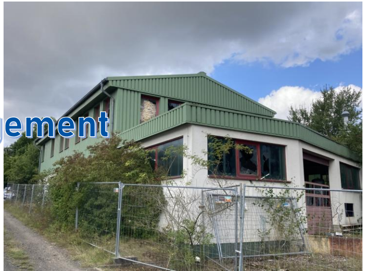
Halle 4 (ehemalige Abwasserbehandlung) vor den Rückbauarbeiten
