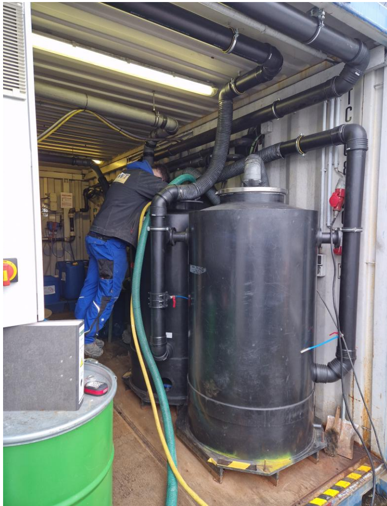
Wechsel der Luft-Aktivkohlefilter
