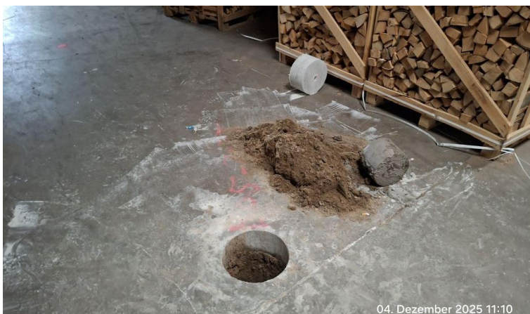
Öffnung des Hallenbodens zur Durchführung einer Sondierung
