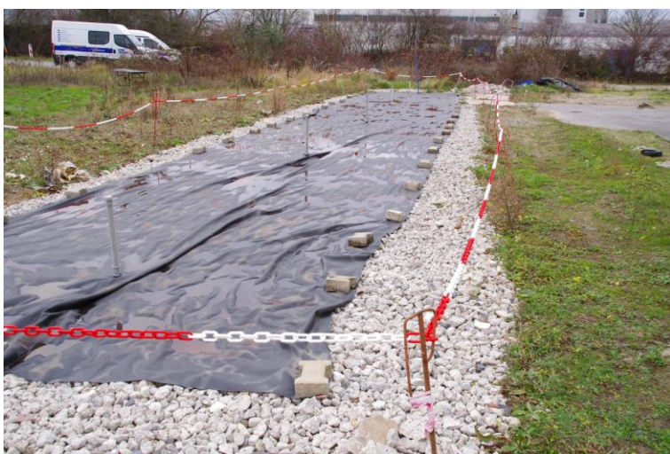
Versickerungsrigole (Ansicht von Süden)
