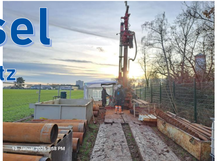
Beginn der Bohrarbeiten zum GWM-Bau
