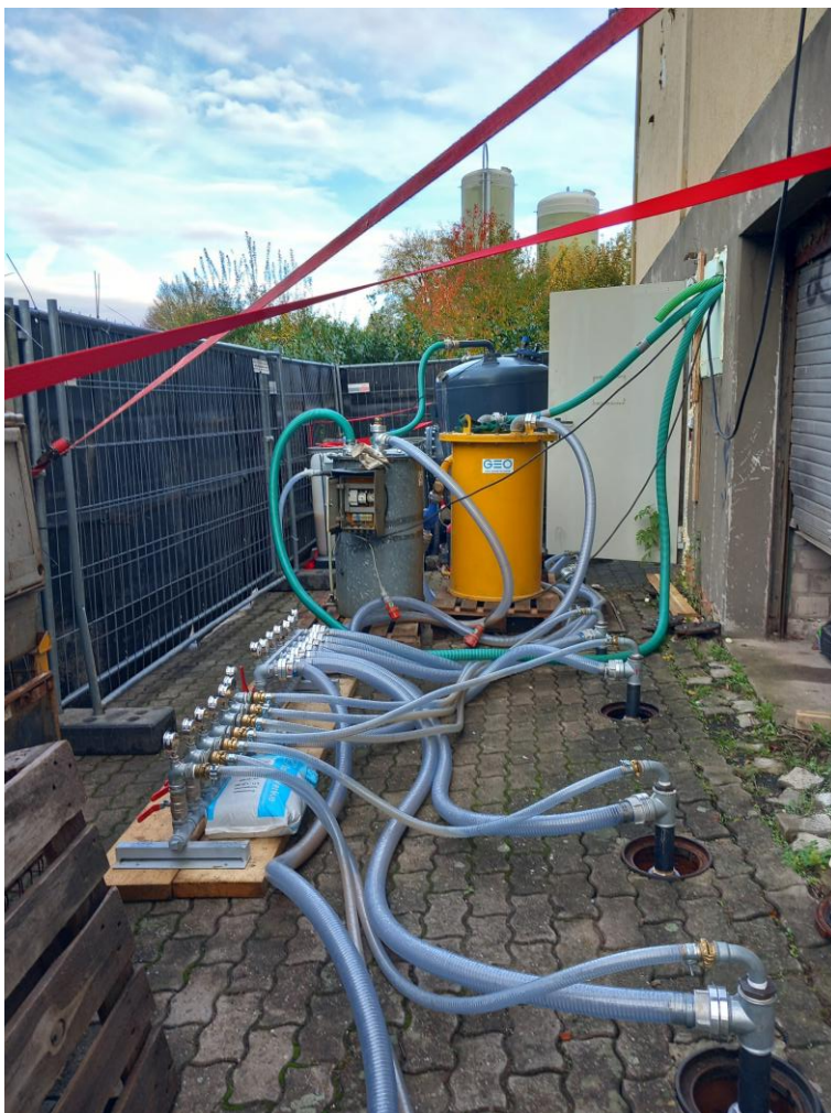
Versuchsaufbau – Vakuum-Bodenluftabsaugung mit paralleler Grundwasserförderung
