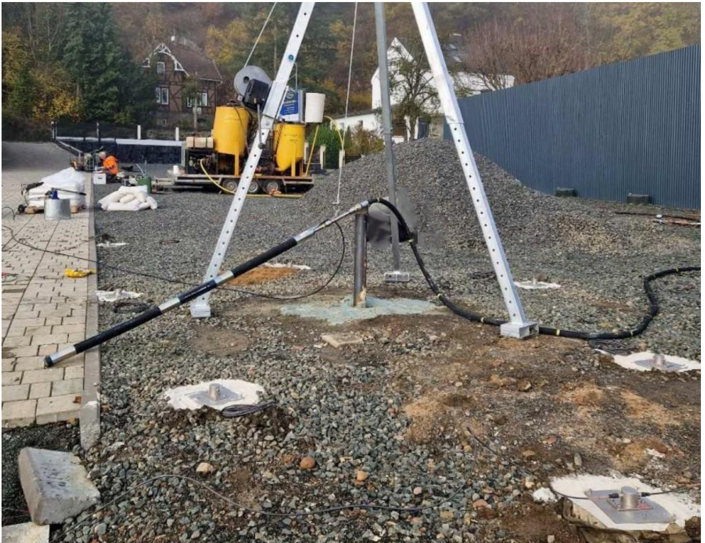
Durchführung der Druckinjektionen
