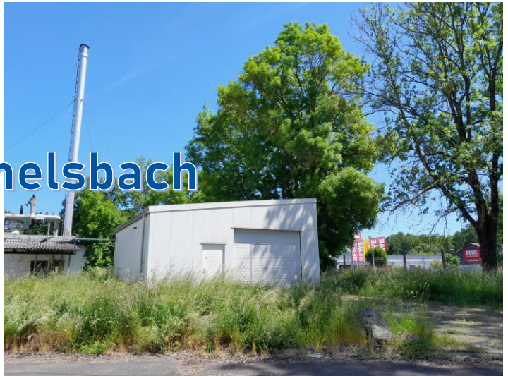
Leichtbauhalle der Grundwasserreinigungsanlage
