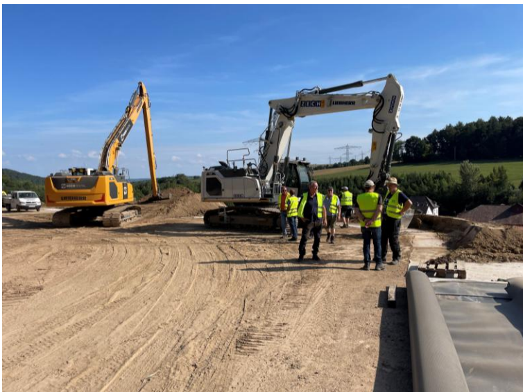
Begehung der Baustelle, der ehem. Kupferhütte Richelsdorf
