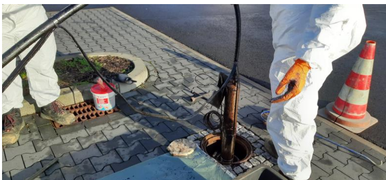
Pumpenausbau bei teerölbelasteten Sanierungsbrunnen
