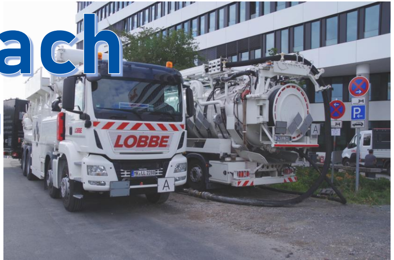
Teerölabsaugung an der Basis des quartären Grundwasserleiters
