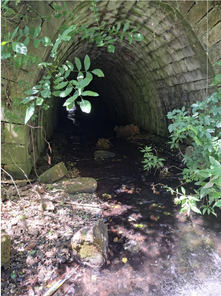
Schwarzbach im Ortsteil Bieber mit Gewölbetunnel unter der Schlackehalde
