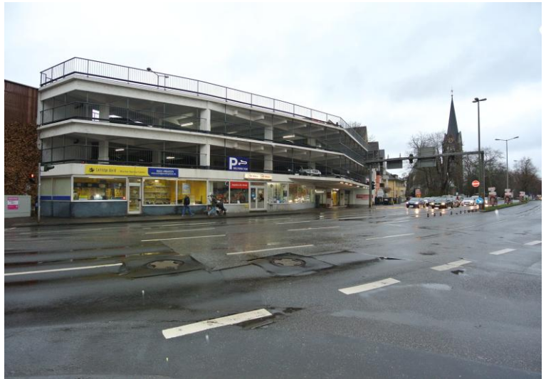
FINA-Parkhaus Südanlage Gießen
