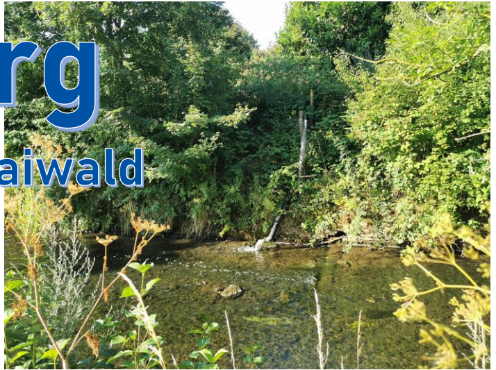
Reinwasserablauf der Anlage in den Vorfluter Usa
