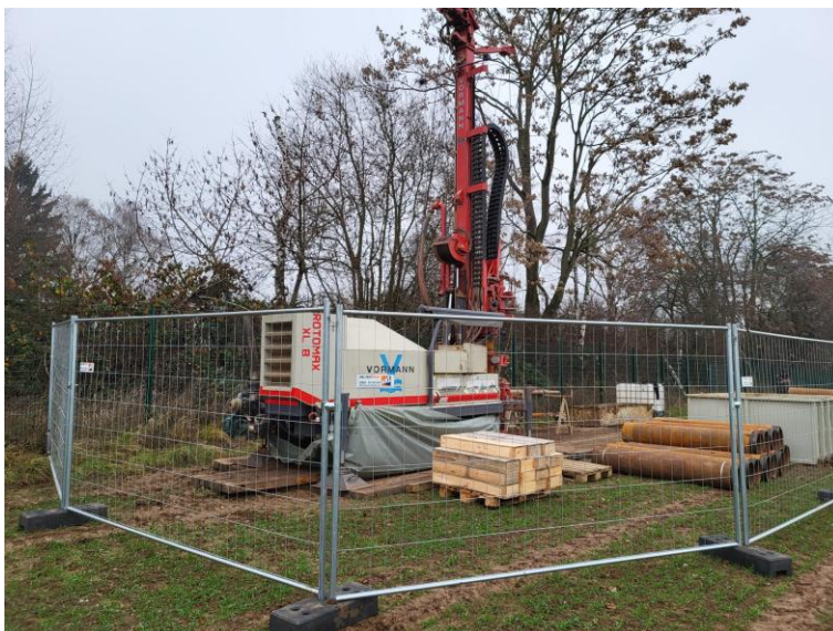
Baustelleneinrichtung für den Grundwassermesstellenbau
