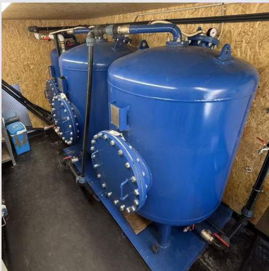
Kiesfilter (vorne) und Aktivkohlefilter (hinten)
