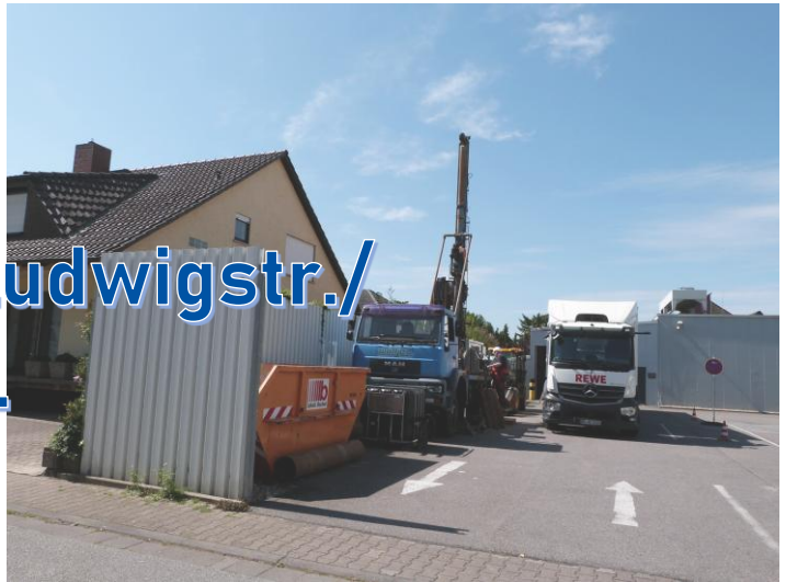
Grundwassermesstellenbau GWM39
