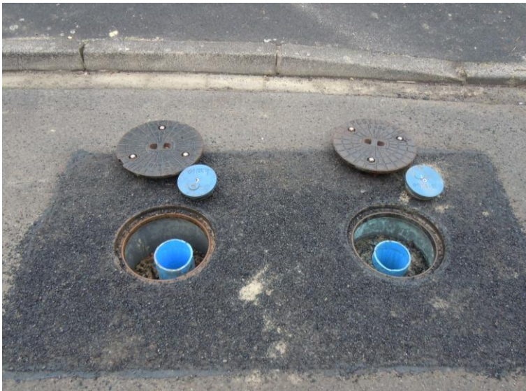
Neu errichtete Doppel-Beobachtungsmessstelle GWM 01/25 (Quartär und Tertiär) im Abstrom des ehem. Betriebsgeländes (Feldbergstraße)
