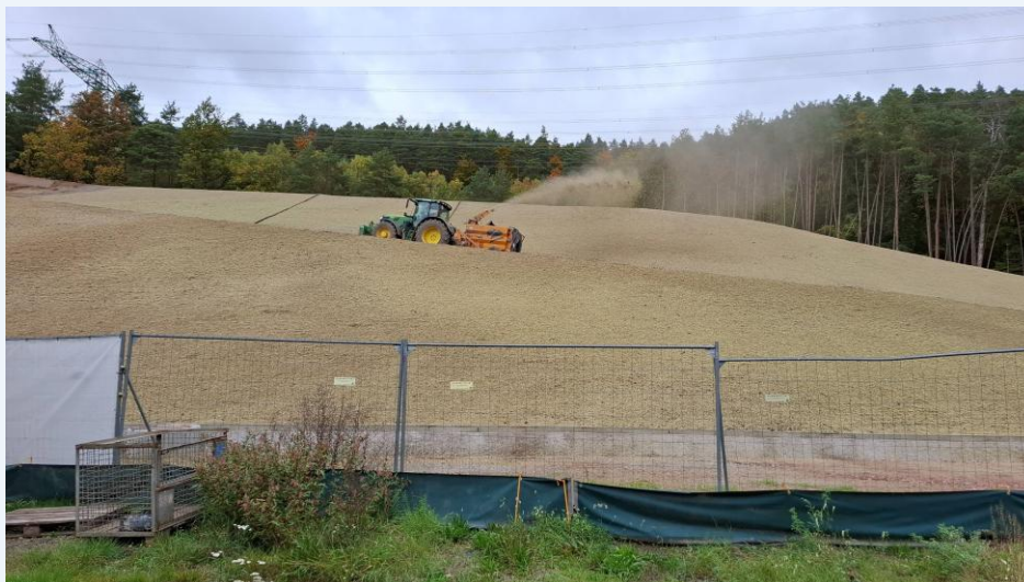
Auftrag von Anspritzbegrünung als Erosionsschutz
