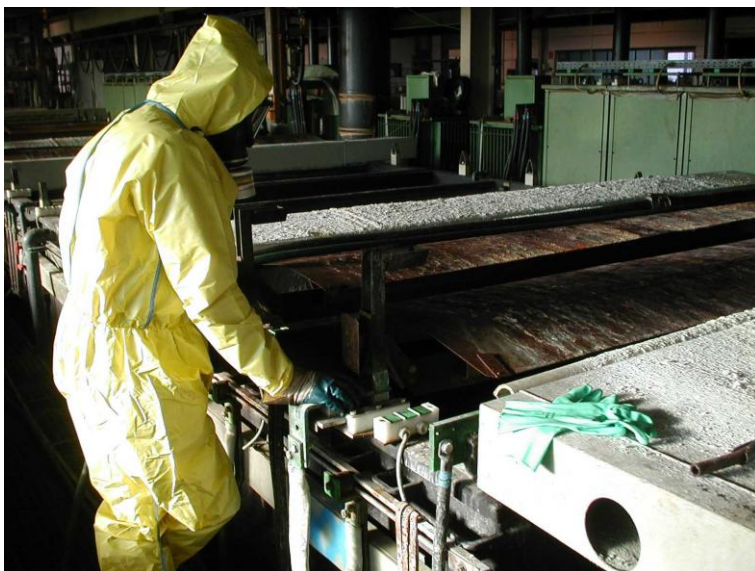
Beräumung der ehem. Galvanik im Jahr 2000 (Schwermetallbäder)
