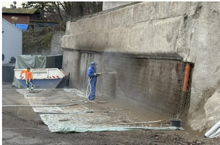
Auftrag von Spritzbeton an armierter Stützmauer
