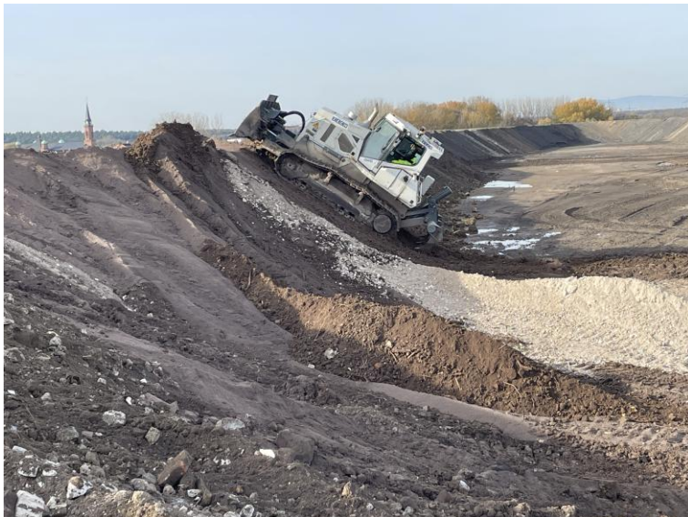
Abb. 2: Profilierung der Innenböschung auf der Deponie
