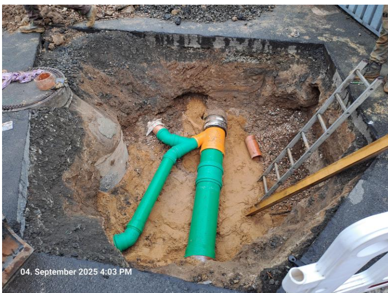
Reparatur des defekten Kanals im Bereich der Drainage
