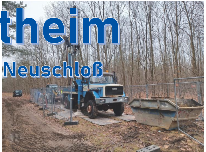
Bohrarbeiten im Rahmen der GW-Erkundung
