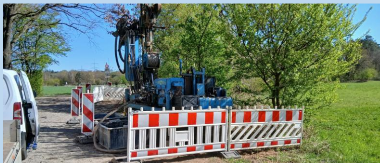
Bohrarbeiten zur Errichtung einer Oberstrom-Messstelle
