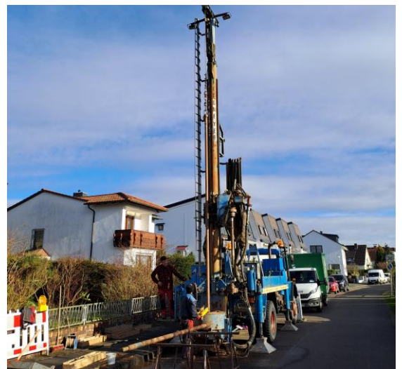
Erkundungsbohrung im Tertiär
