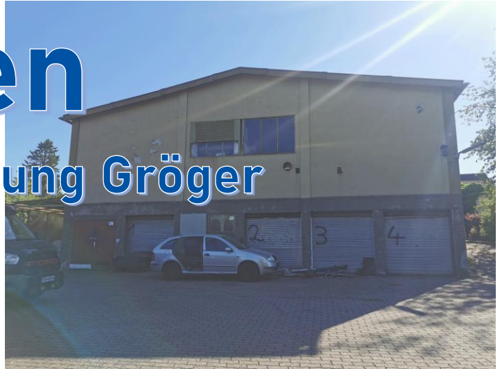
Rückseitige Ansicht auf das Gebäude der Chemischen Reinigung Gröger – Bereich der Vakuumwasserhaltung
