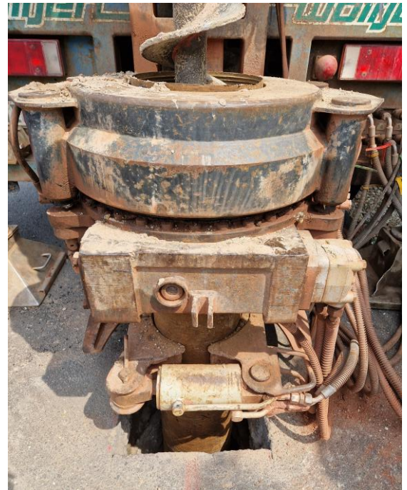
Bohransatzpunkt einer neu errichteten Grundwassermessstelle
