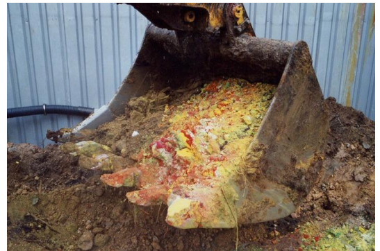
Bodensanierung, Bad Homburg, Farbenfabrik Vossen
