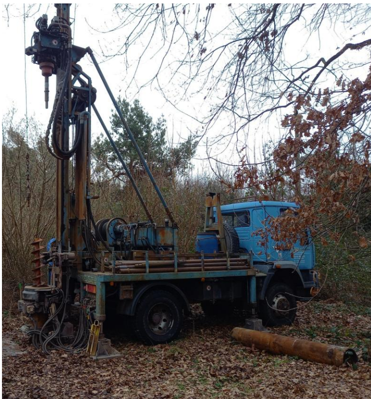
Bohrarbeiten zu Messstellenau GWM 36
