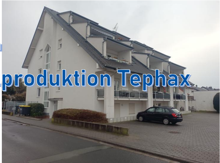
Wohngebäude oberhalb des LHKW-Schadens
