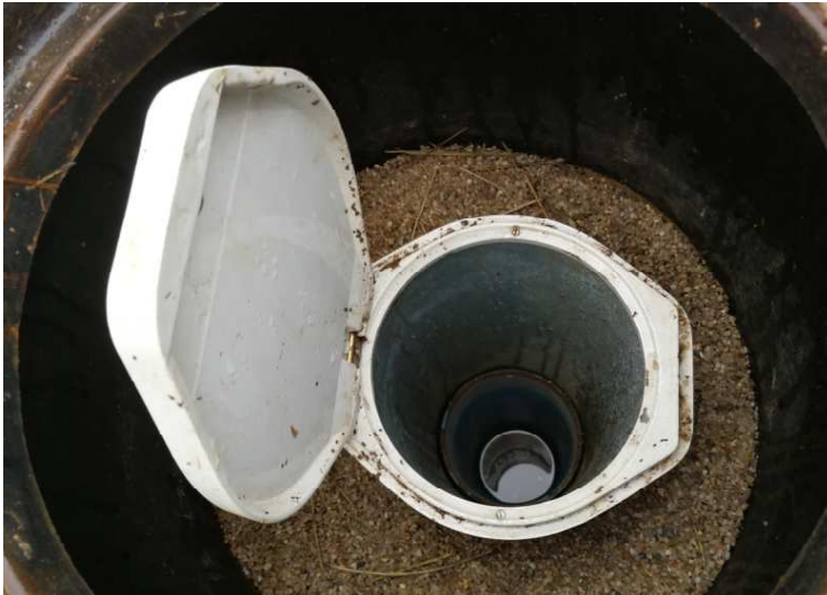
Neu errichtete GWM01_23 im südlichen Grundwasserabstrom des Standorts
