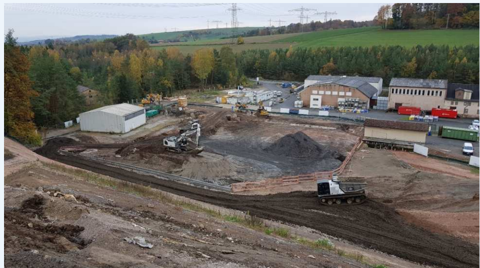
Blick von der Rückstandshalde über den Sanierungsbereich nach Abtrag der Materialien aus der ungesättigten Zone (Aufnahme vom 24.10.2024)
