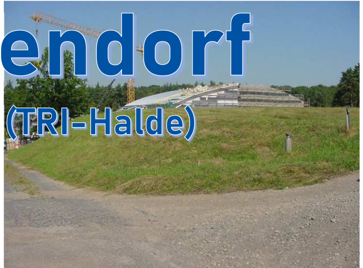
TRI-Halde mit Einhausung für Bodenabtrag (2003-2004)
