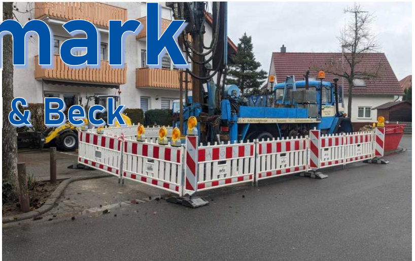
Brunnenbauarbeiten im Wohngebiet
