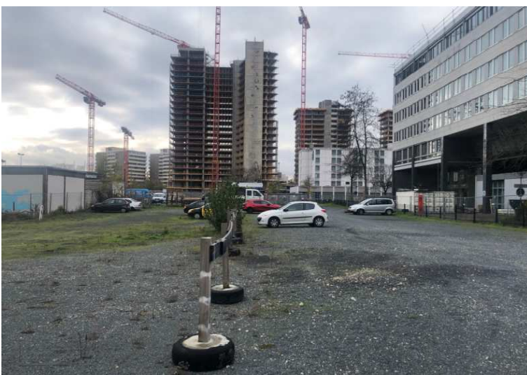
Neue Parkfläche auf dem ehemaligen Betriebsgelände
