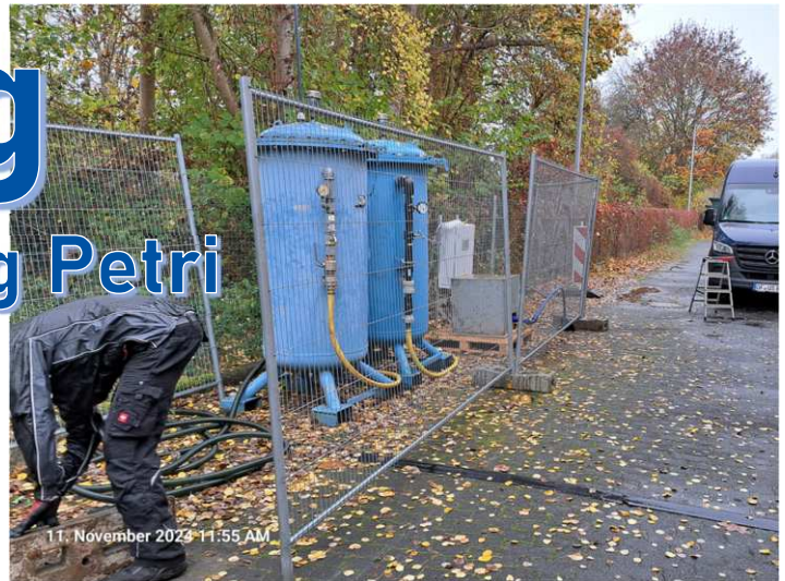
Aufbau Pumpversuch an GWM 25
