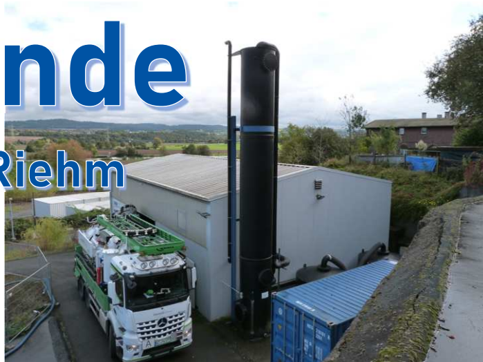
Abpumpen von Teerphase mittels Saugwagen
