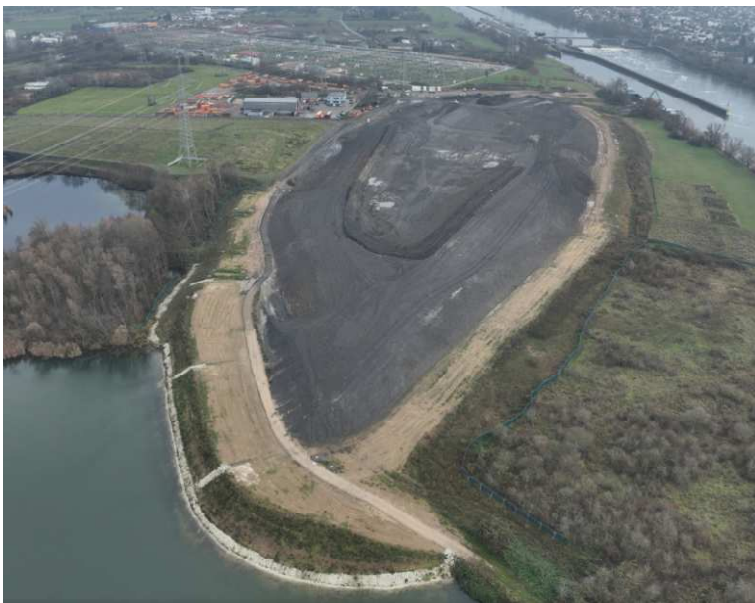
Zustand der Deponieoberfläche Ende 2024 (Blickrichtung nach Osten)
