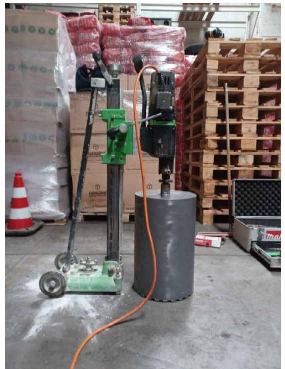
Kernbohrung an Hallenboden
