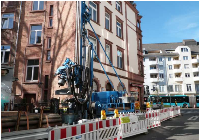
Errichtung der GWM 27 in der Kiesstraße
