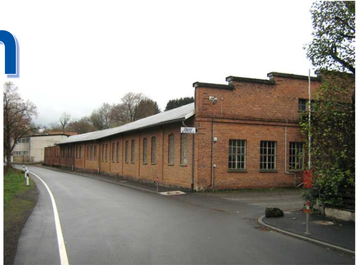
Blick auf den Standort ehem. Walkmühle, Laubach-Lauter
