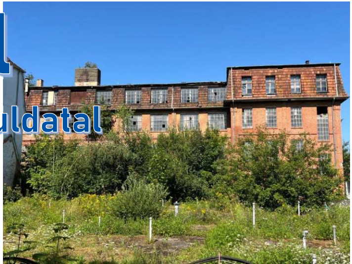
Hauptgebäude ehemalige Pelzveredelung
