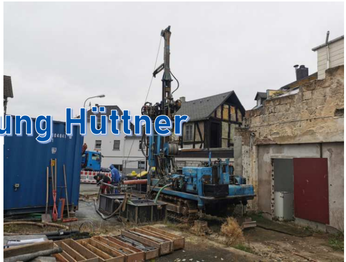
Bohrarbeiten zur Errichtung weiterer Devon-Messstellen auf dem Altstandort
