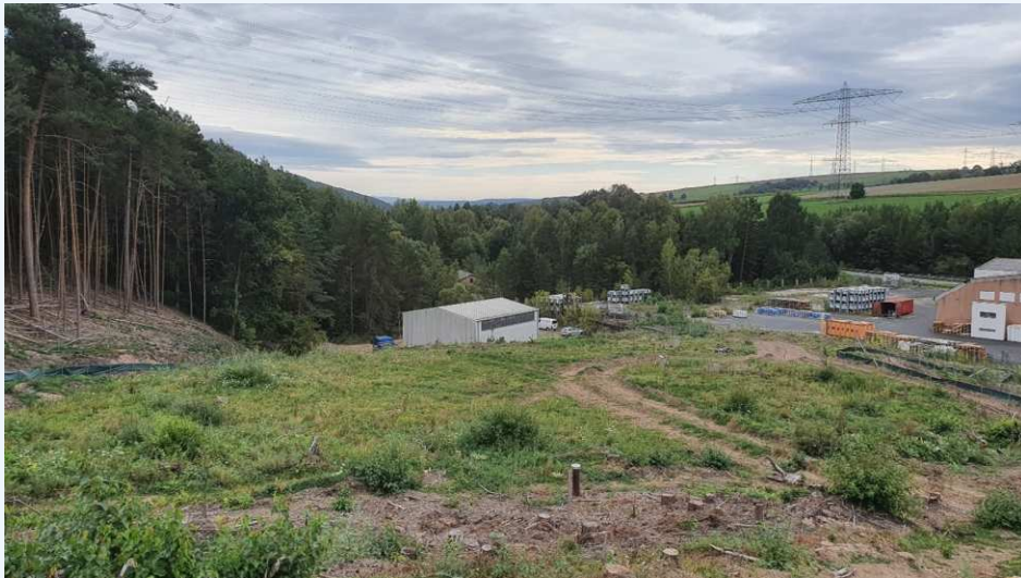
Blick von der Rückstandshalde über das Sanierungsgebiet vor Baubeginn (Aufnahme vom 21.09.2023)
