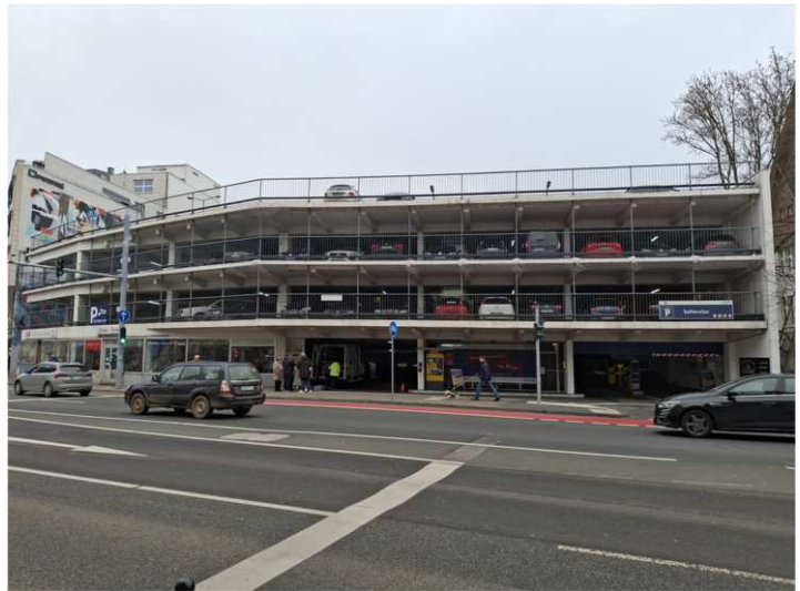
FINA-Parkhaus Südanlage Gießen
