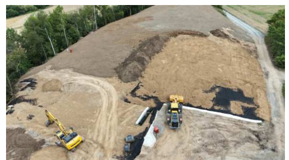
Bau des Abdichtungssystems, Blickrichtung Nordost
