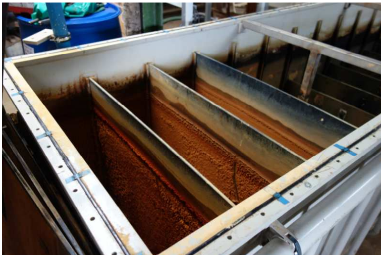
Stripstufe vor Beginn der jährlichen großen Inspektion/Revision
