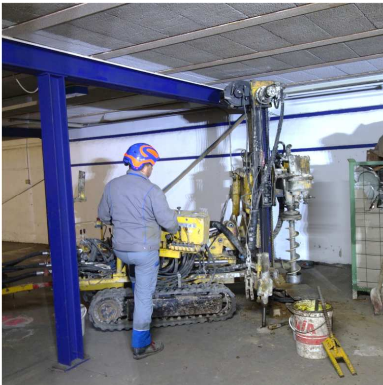
Bohrarbeiten zur Errichtung der neuen BL-Pegel
