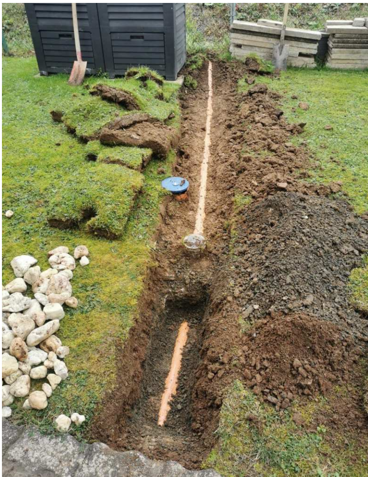
Rückbau der Leitung zwischen Privathaus (Raumluftabsaugung im UG) und Sanierungsanlage
