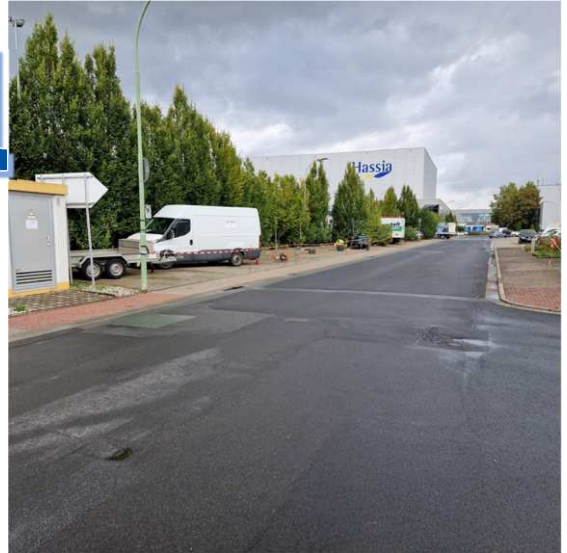
Direct-Push-Sondierungen am Projektstandort
