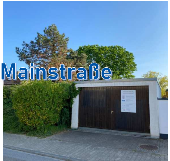
Grundwasserreinigungsanlage zur LHKW-Sanierung
