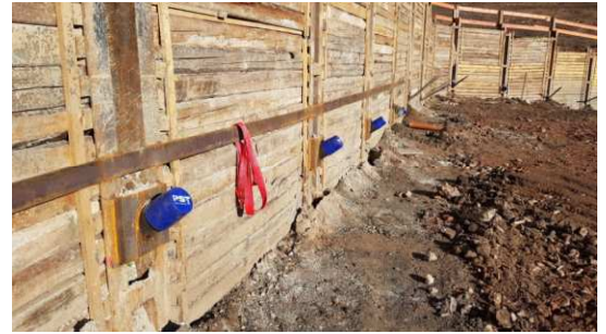
Trägerbohlwandverbau zur hangseitigen Sicherung der Baugrube
