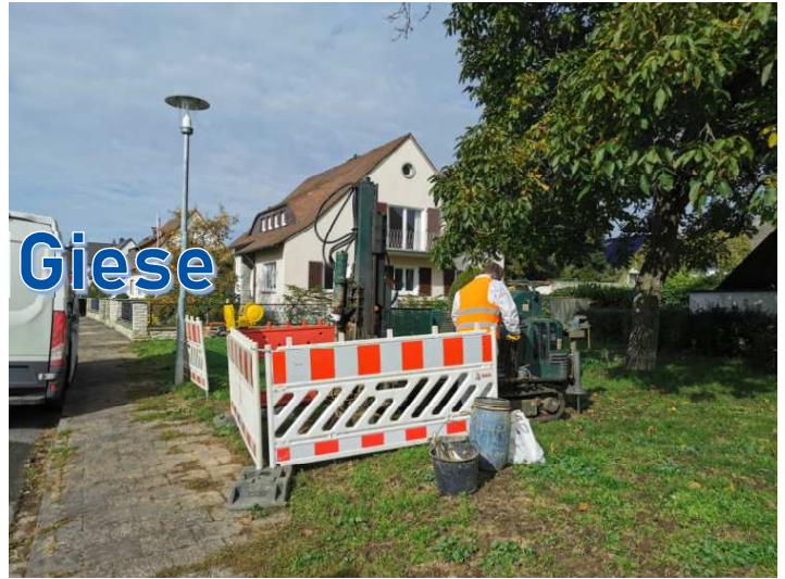
Direct-Push-Sondierungen zur Erkundung des Oberstroms
