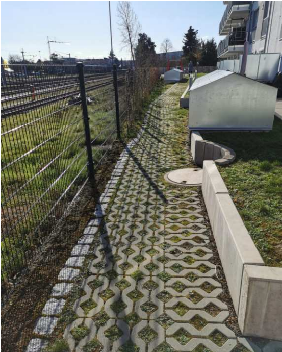
Sanierungsbrunnen an der Grundstücksgrenze nach Neubebauung
