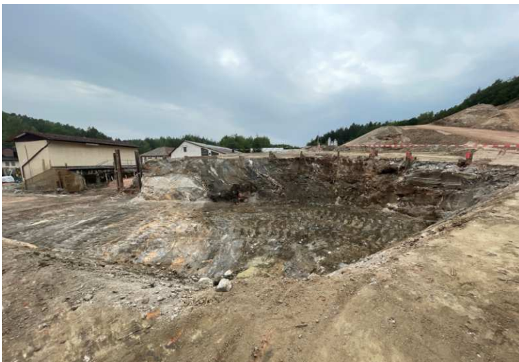
Richelsdorf: Abtrag der Rückstandshalde oberhalb des nassen Fußes
