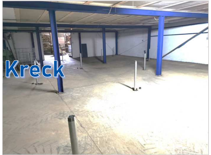
Neues Bodenluftpegelfeld im Untergeschoss des ehemaligen Produktionsgebäudes
