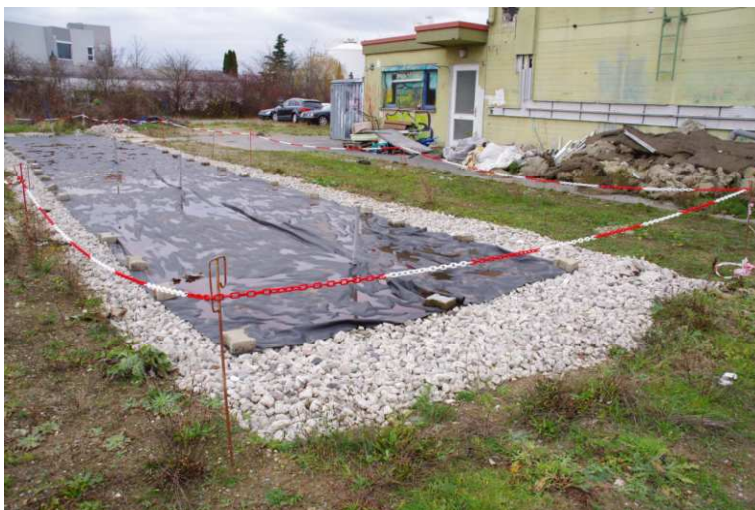
Erneuerung der Rigole
