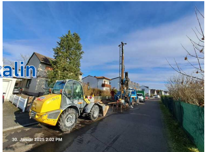
Bohrarbeiten im Klausenweg
