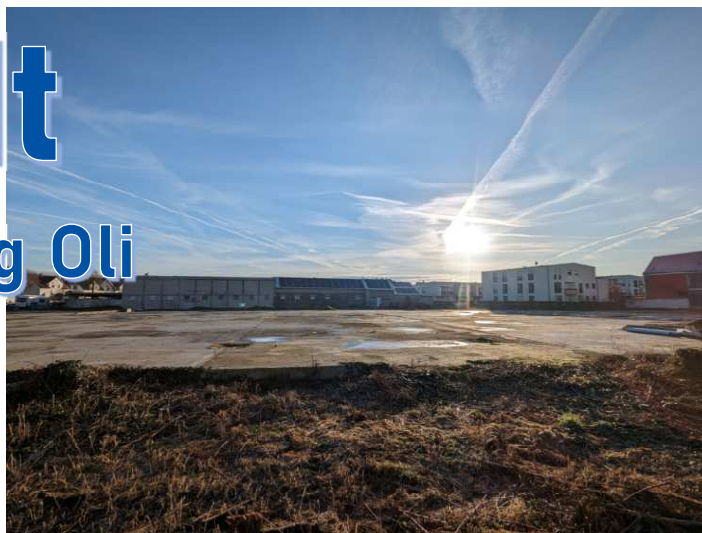
Gelände des ehem. OLI-Werk II, Februar 2024
