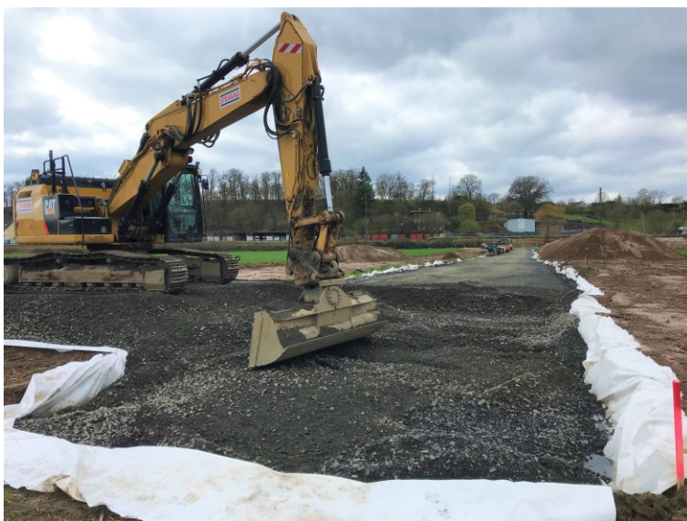
Herstellung der Baustraßen zum Ederufer
