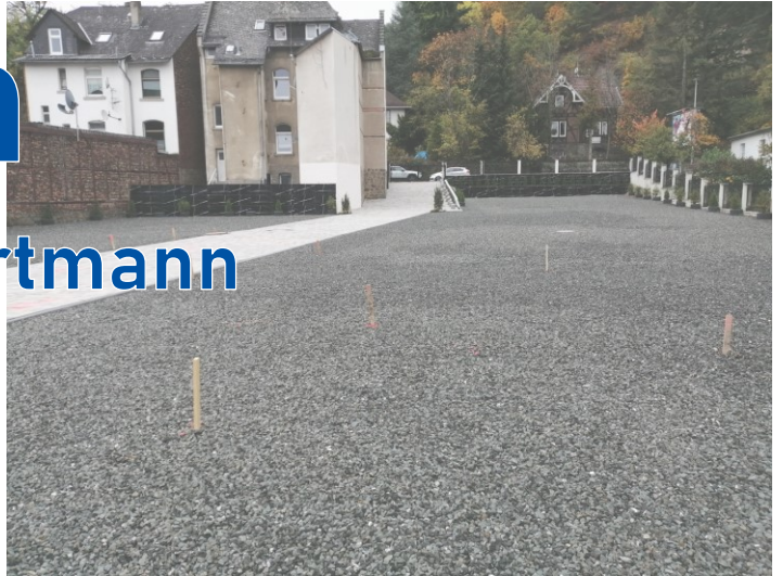
Abgesteckte Bohrpunkte der DP-Untersuchungen
