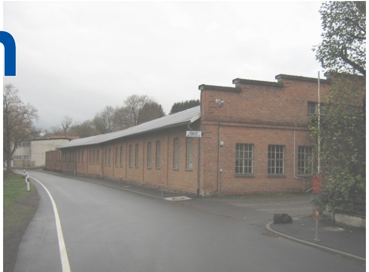
Blick auf den Standort ehem. Walkmühle, Laubach-Lauter
