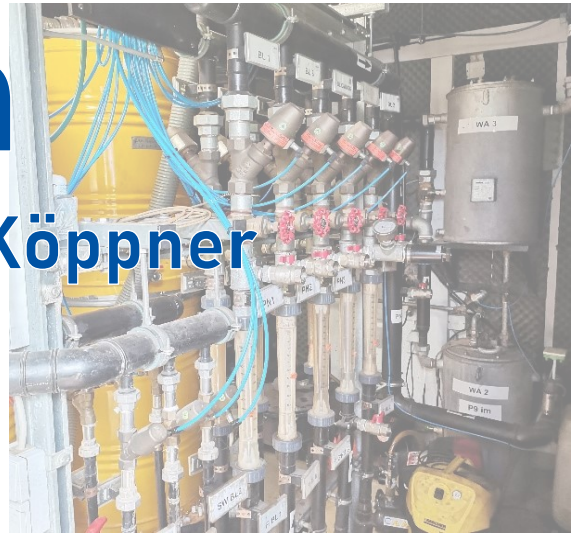
Bodenluftabsaugung
