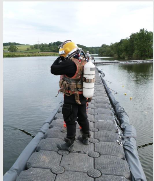
Arbeitstaucher bei der Installation der Pontonanlage
