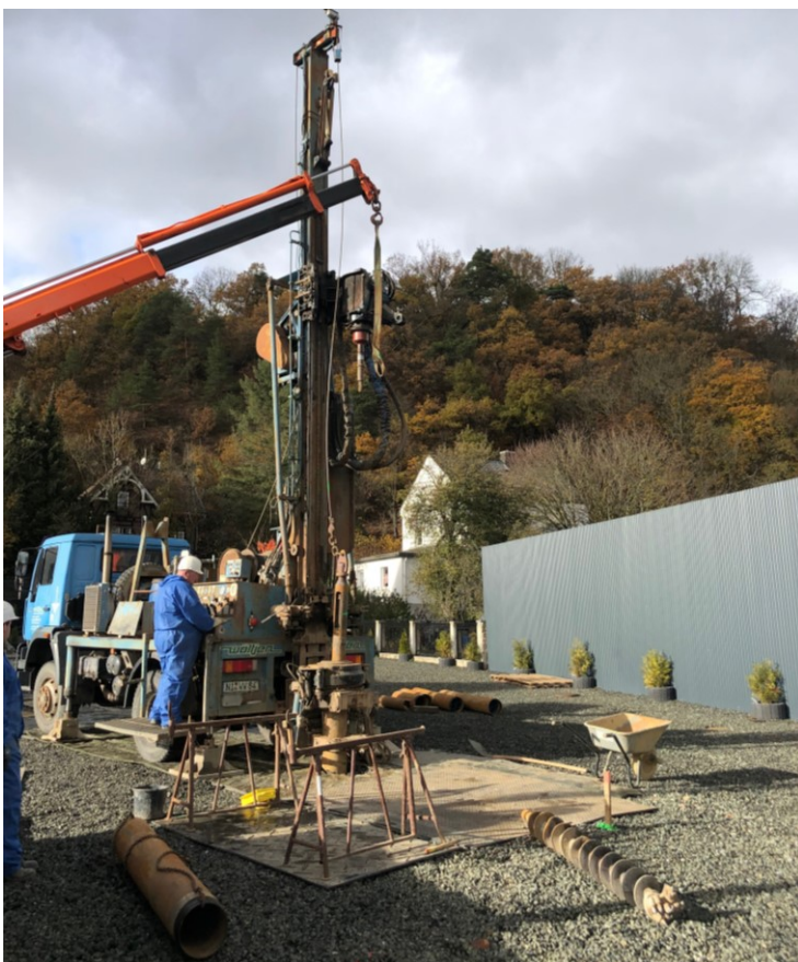
Niederbringung einer Liner-Bohrung
