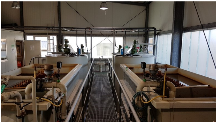
Grundwasserreinigungsanlage Innenansicht
