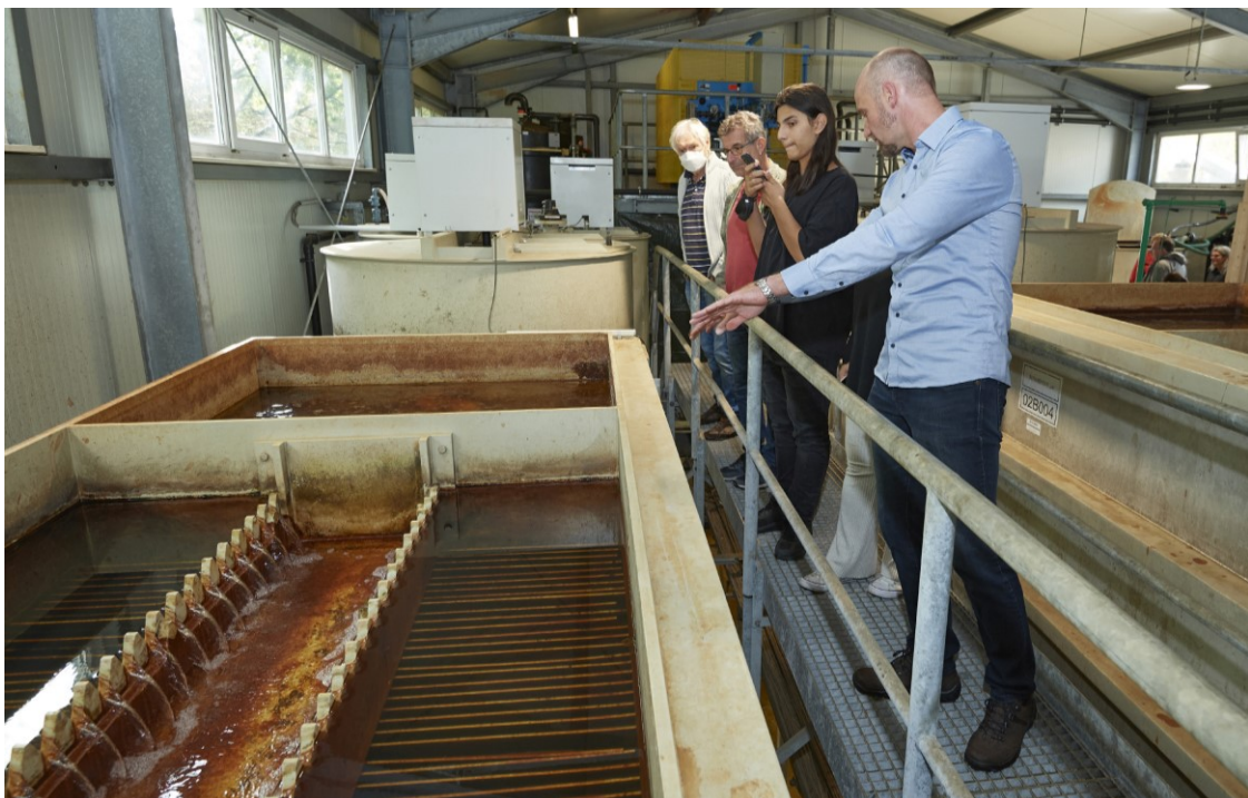
Anlagenführung beim Tag der offenen Tür in Lampertheim
