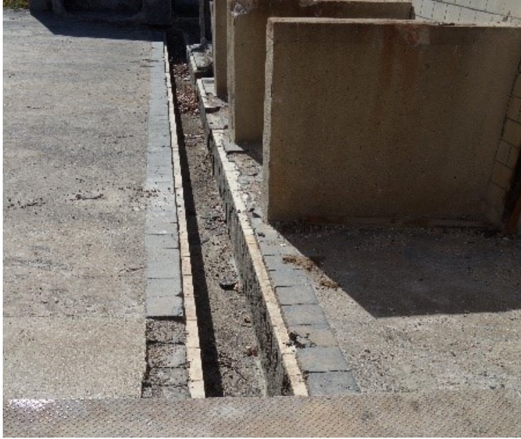
Ehemalige Abwasserrinne auf dem Produktionsgelände
