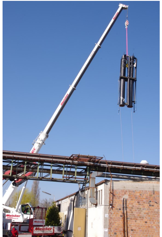
Abtransport Stripkolonne alter Grundwasser-sanierungsanlage
