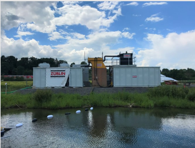
Reinigungsanlage für das verunreinigte Wasser aus dem Aushubbereich am Ederufer
