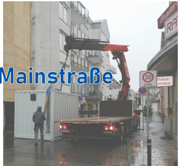
Aufstellung der mobilen WAA für den Pumpversuch an GWM 19
