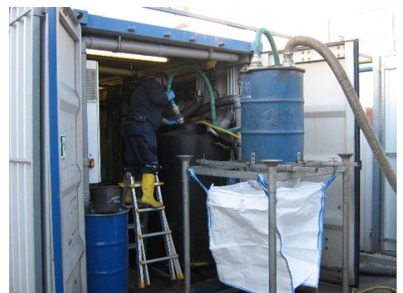
Wechsel des Luftaktivkohlefilters am Standort „Fahnenmitte“
