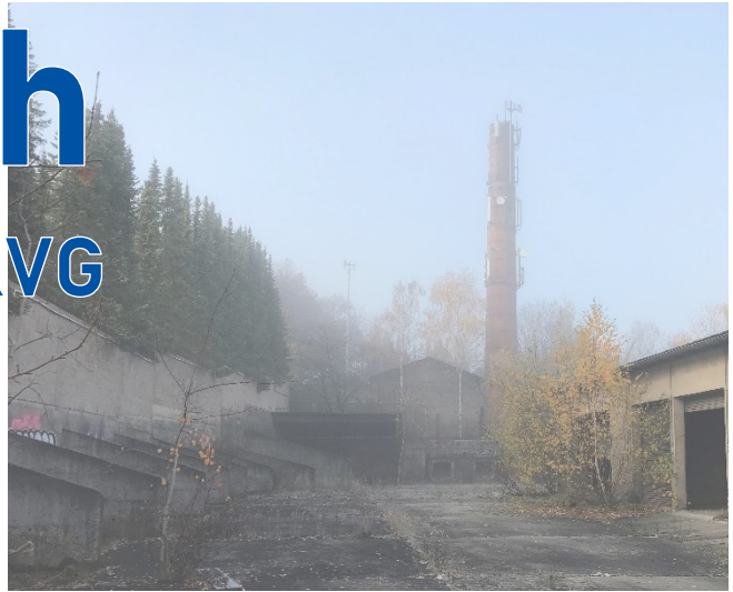
Betriebsgelände der ehemaligen Kabelverwertungsgesellschaft
