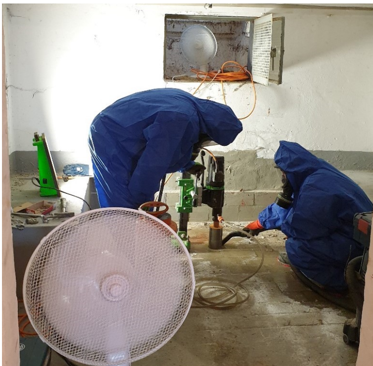
Bohrarbeiten in hoch kontaminierten Bereichen
