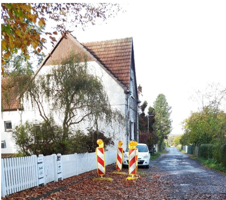
Absperrung der AB06 für den Absaugversuch in der Straße „Auf dem Hasenstock“
