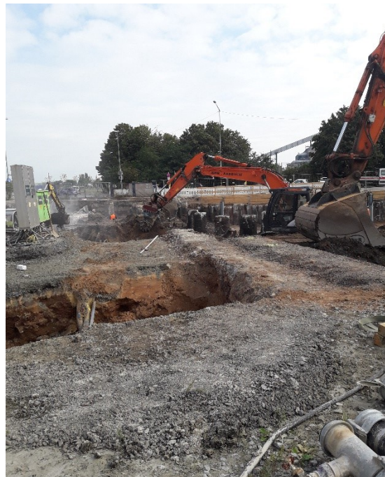
Abfräsungen zur Herstellung von Leitungskanälen
