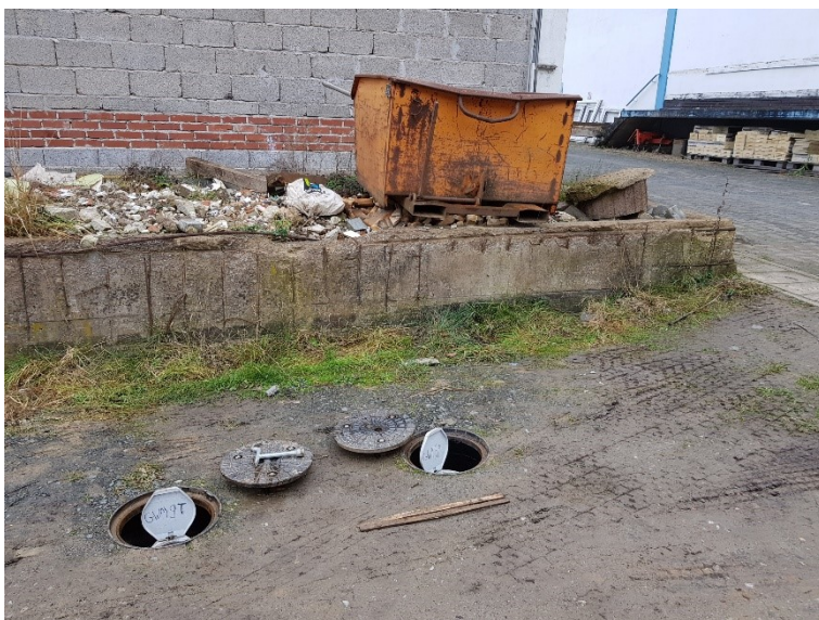
Messstellenpaar GWM 9 mit Ausbau im Poren- und Kluftgrundwasserleiter
