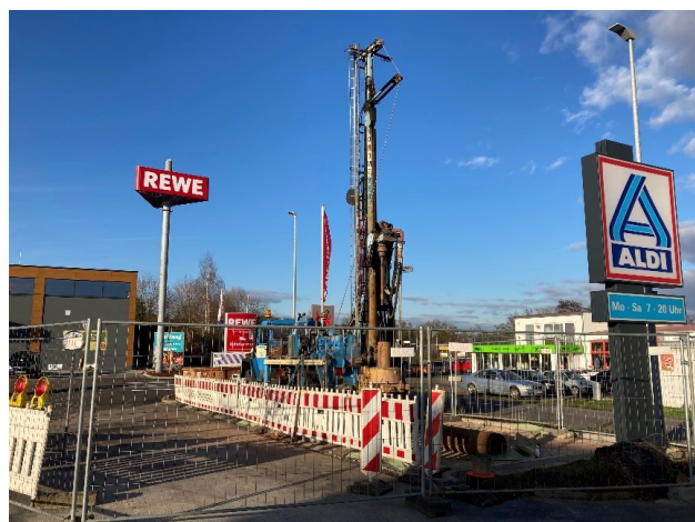
Bohrarbeiten zur Errichtung eines neuen Förder-/Sanierungsbrunnens
