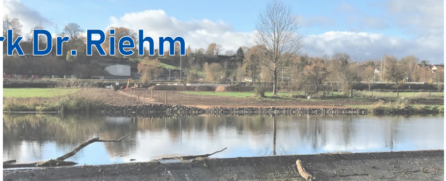
Ederufer und Abzugsgraben nach der Sanierung und Baustellenräumung
