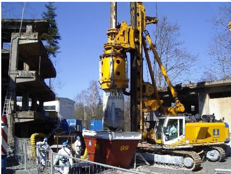
Bodensanierung der HIM-ASG in Hessisch Lichtenau-Hirschhagen
