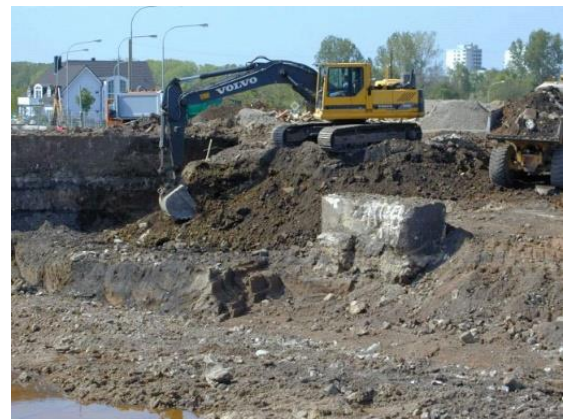
Bodensanierung der HIM-ASG in Mühlheim
