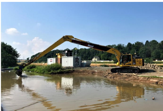
Wiederherstellung/Remodellierung des Ederufers
