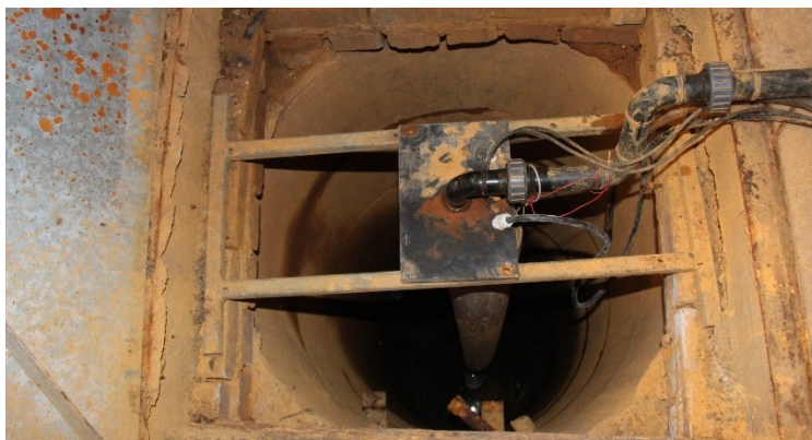
Sanierungsbrunnen (ehemaliger Betriebsbrunnen)
