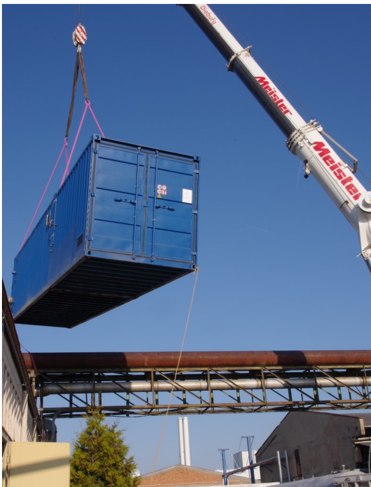
Abtransport Anlagenkomponenten alter Grundwassersanierungsanlage
