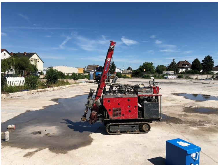
Kettenbohrgerät während den Sondierungen
