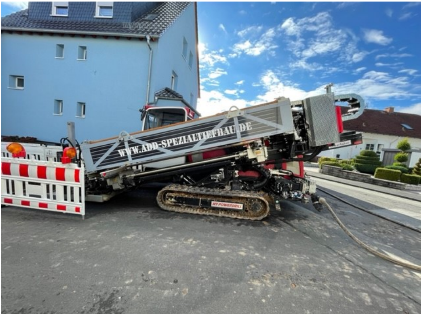
Horizontalspülbohrung zur Verlegung der Leitungen im Straßenbereich
