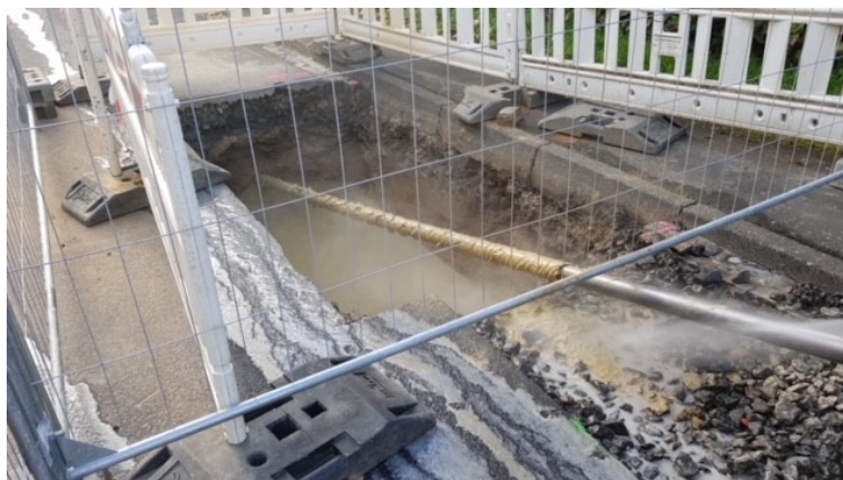
Horizontalspülbohrung zur Verlegung der Leitungen im Straßenbereich
