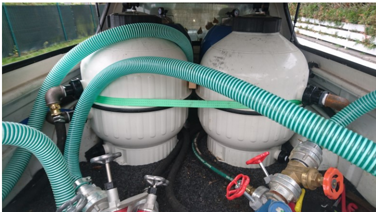
Grundwasserprobenahme, Abreinigung des Förderwassers über mobile Filter
