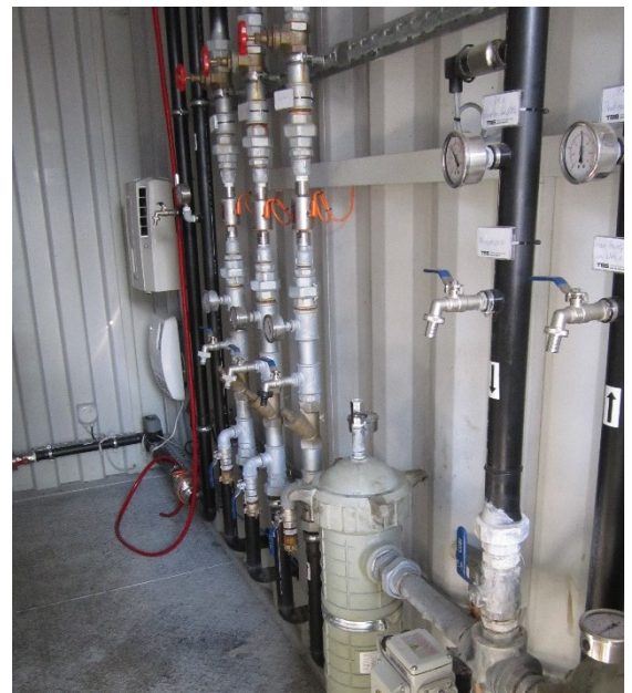
Armaturen Grundwasser-Reinigungsanlage
