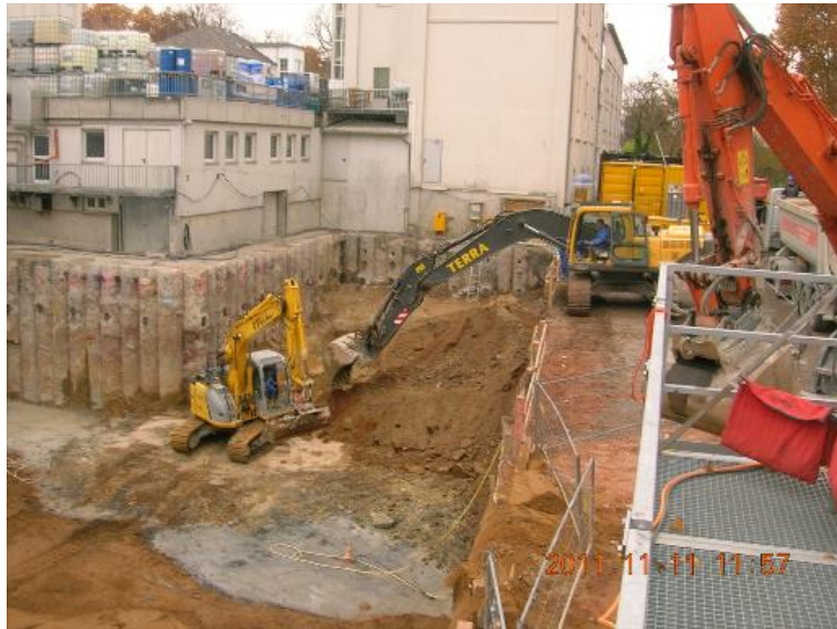
Bodensanierung der HIM-ASG in Wiesbaden
