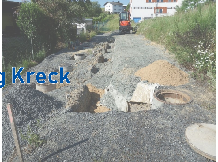
Anschluss von Bodenluft-Absaugbrunnen
