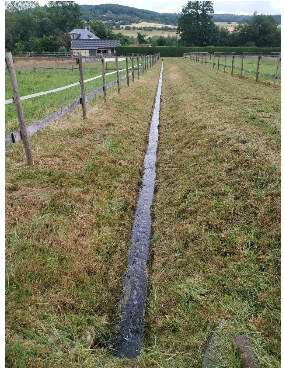
Ableitung des Reinwassers
