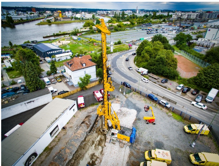
MIP-Bohrgerät zur Verlängerung bestehender Leitwände
