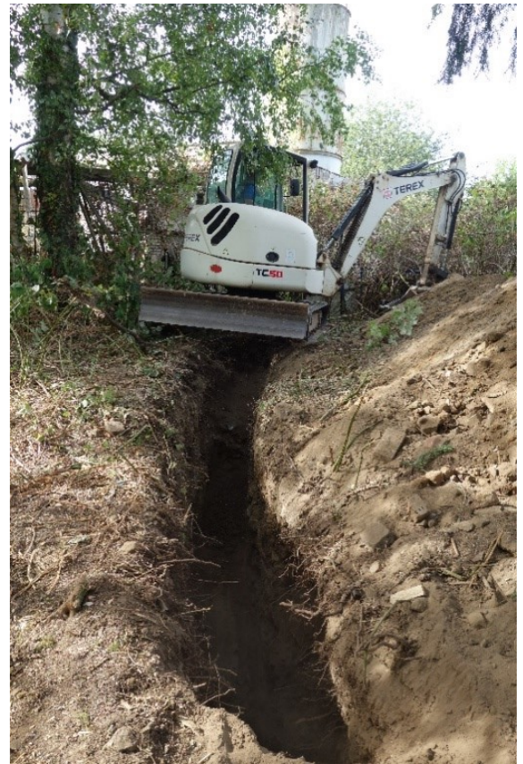
Such-Schurf zum Auffinden einer ehemaligen Abwasserleitung
