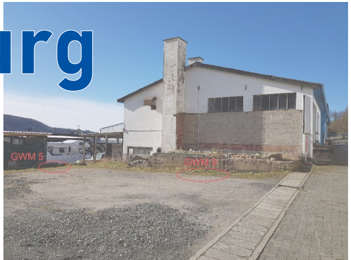
Südliche Grundstücksgrenze mit Messstellen GWM 5 (belastet) und GWM 9
