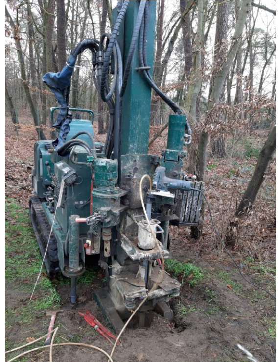
Bohrgerät zur Ausführung der DP-Sondierungen
