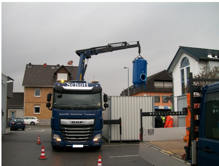
Wechsel des Wasseraktivkohlefilters am Standort „Fahnenmitte“
