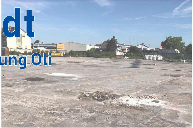
Gelände Werk II nach Gebäuderückbau
