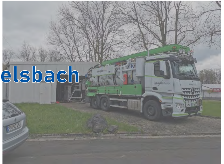
Schlammabsaugung in der Wasseraufbereitungsanlage
