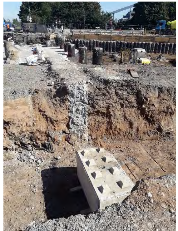
Abgefräster Funnelbereich
