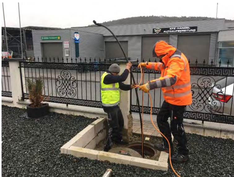
Pumpenwechsel am Sanierungsbrunnen B2
