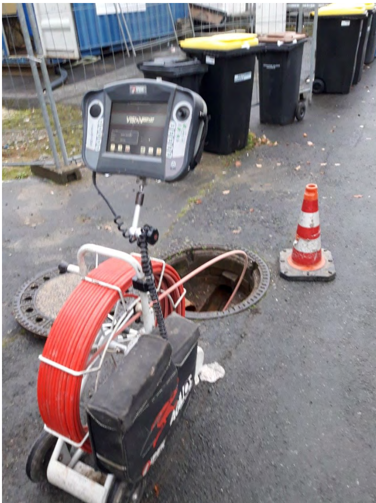
Kanalinspektion Rückspülwassereinleitung
