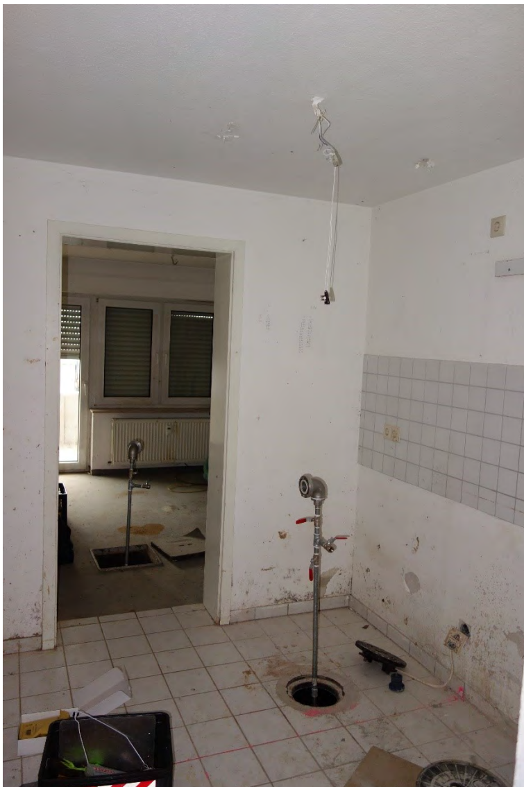
Für Absaugversuche umgerüstete Grundwassermessstellen
