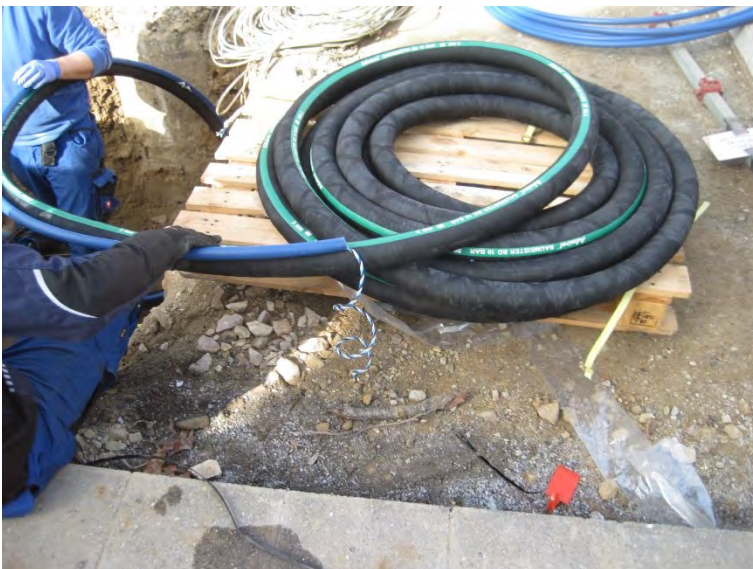
Einziehen der neuen Förderleitung in Leerrohr für Entnahmebrunnen GWM 9
