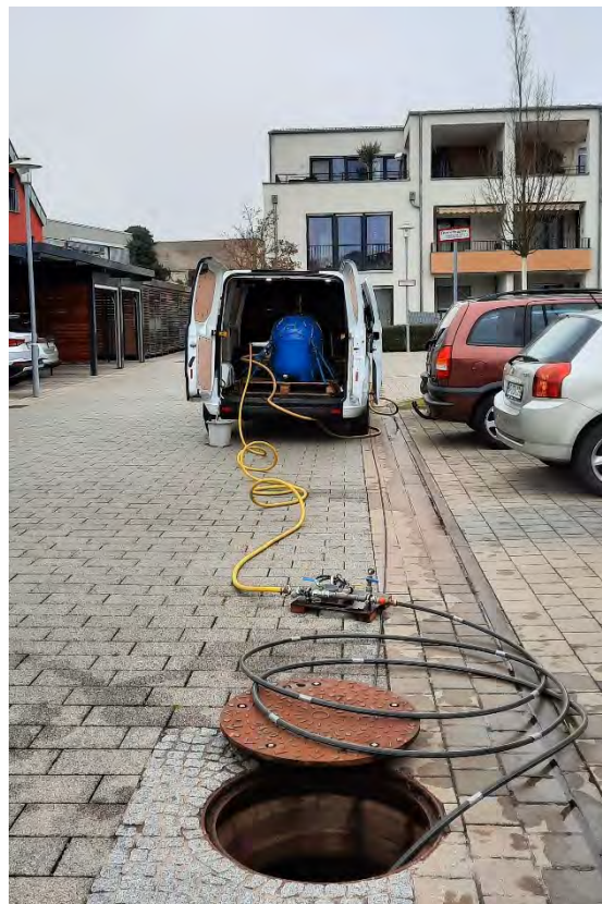
Probenahme von mit PFC kontaminiertem Grundwasser mit Abreinigung über Aktivkohlefilter
