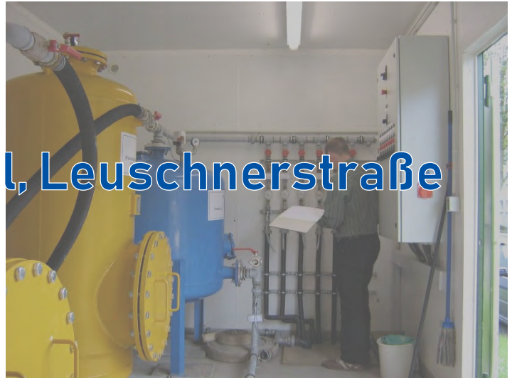
Monatliche Kontrolle der Grundwasserreinigungsanlage
