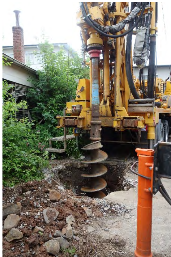
Rückbau des ehemaligen Werksbrunnens
