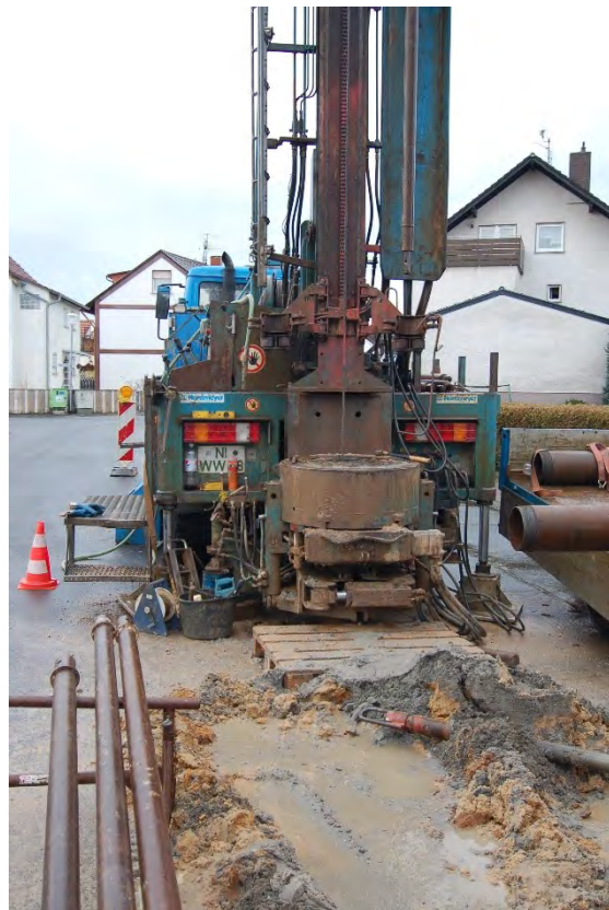
Grundwassermessstellenbau in der Ortslage (2011)
