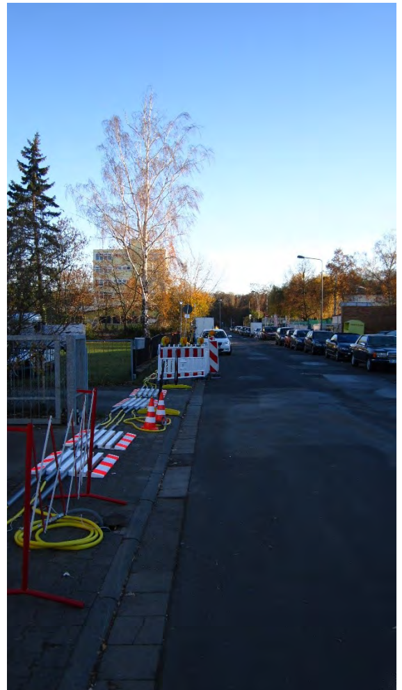
Injektion von Pflanzenölemulsion in die Bio-Barriere
