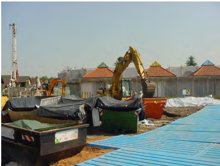
Bodensanierungen der HIM-ASG in Lampertheim
