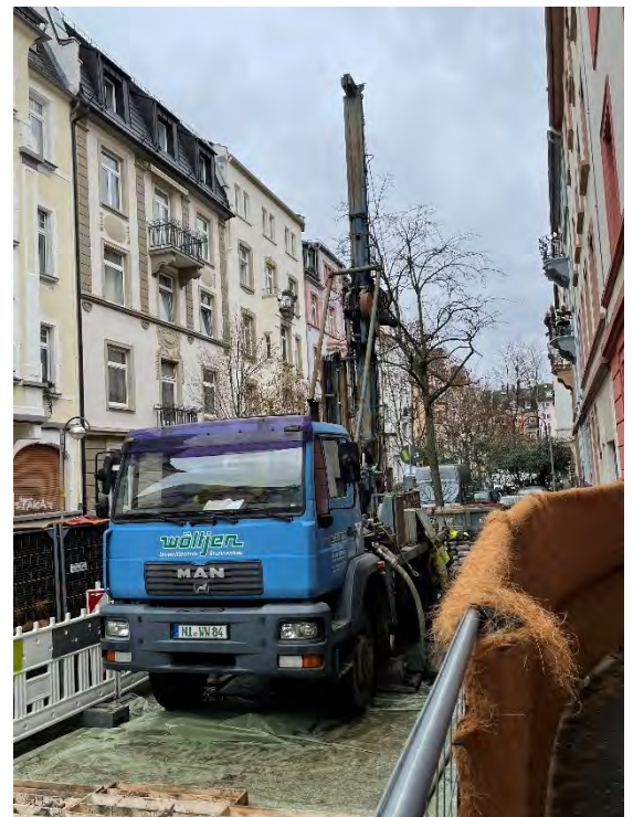
Errichtung einer Grundwassermessstelle in der Fahne
