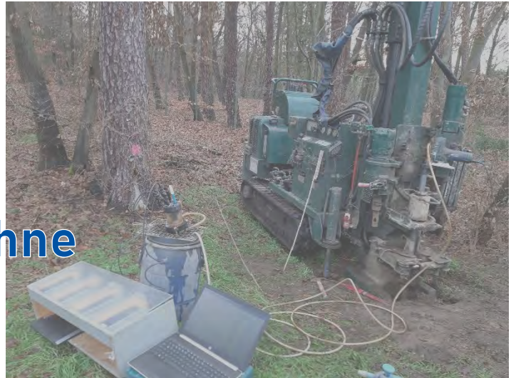
Durchführung DP-Sondierung und Wasserprobenahme
