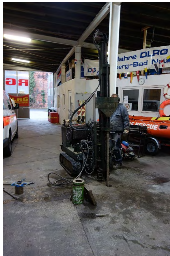
Sondierarbeiten (2021) unter beengten Platzverhältnissen
