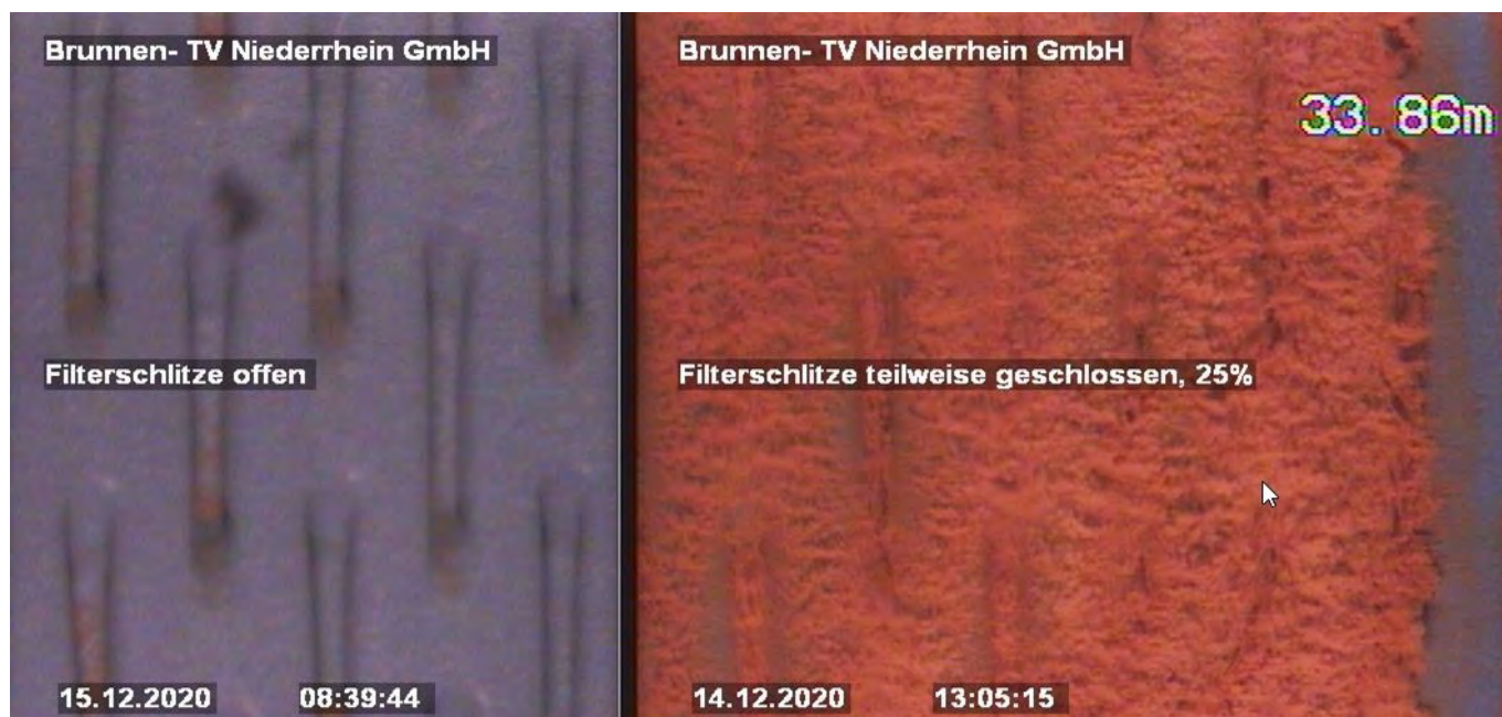
Brunnen ASB8 vor (rechts) und nach (links) Reinigung
