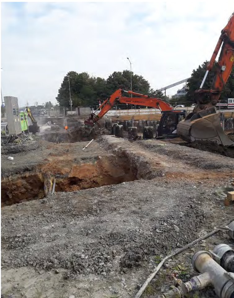
Bauarbeiten zum Abfräsen des östlichen Funnels
