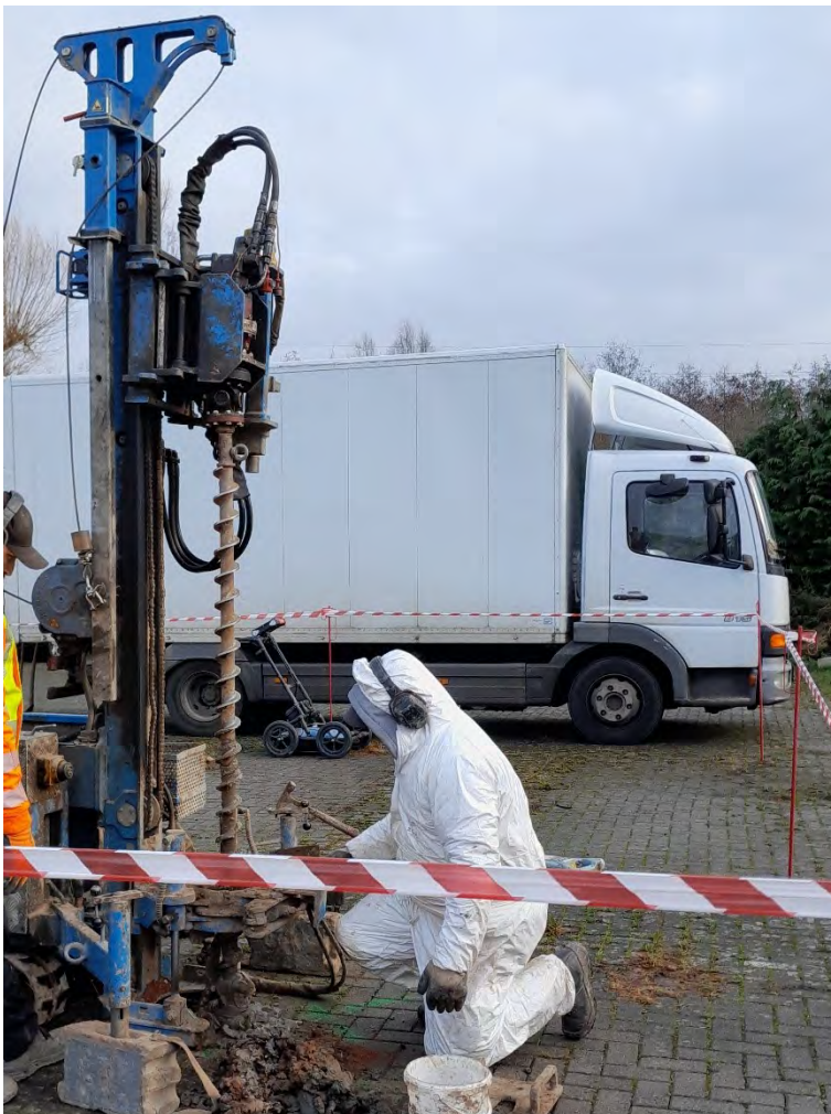
Messstellenbau - Entnahme der Bohrkern
