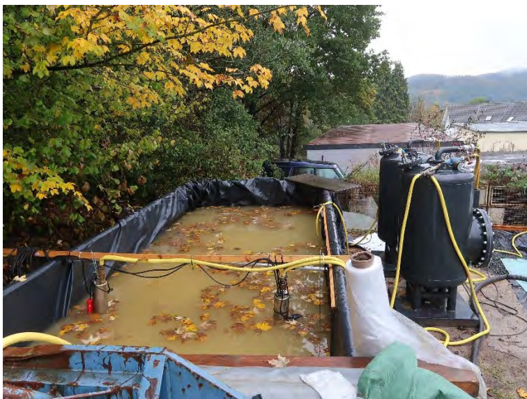
Absetzbecken und WAK-Filteranlage zur Wasserhaltung während der Bodensanierung
