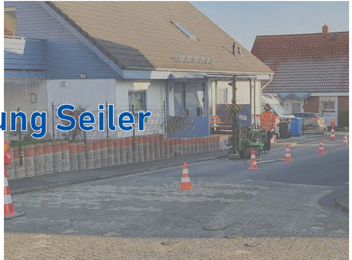
Rammkernsondierungen zur Erkundung der Trasse für die Rohrleitungen
