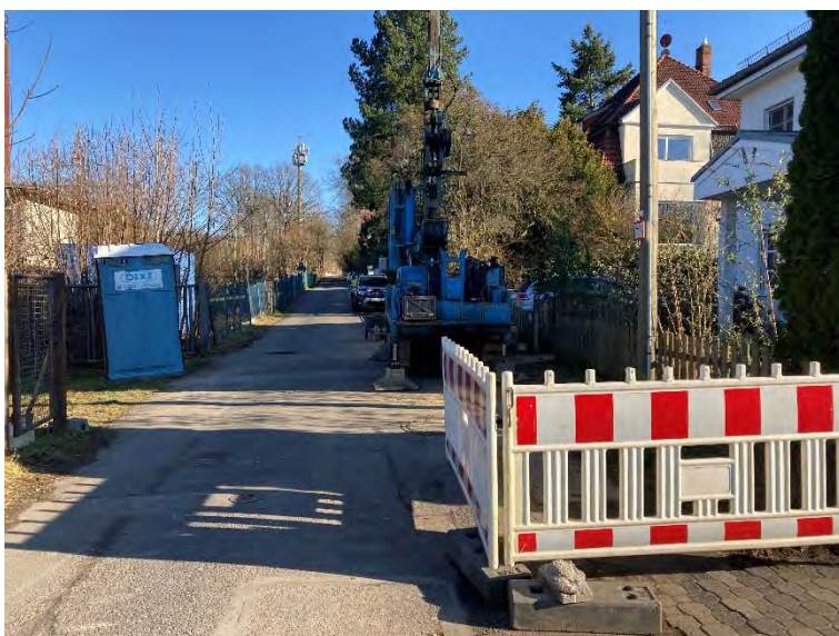
Bohrarbeiten zum Bau von Injektionslanzen in der Straße „Auf dem Hasenstock“
