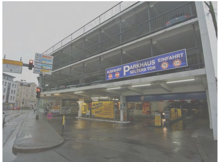
Zufahrt FINA-Parkhaus, Südanlage 26, 35390 Gießen
