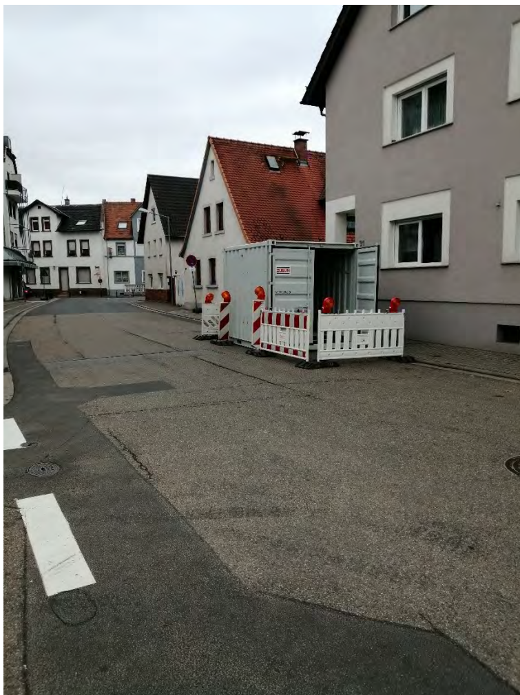
Pumpversuch an der GWM 8/06
