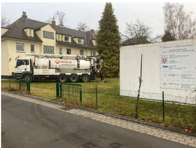
Kamerabefahrung und Regeneration der Horizontalbrunnen durch Spülung
