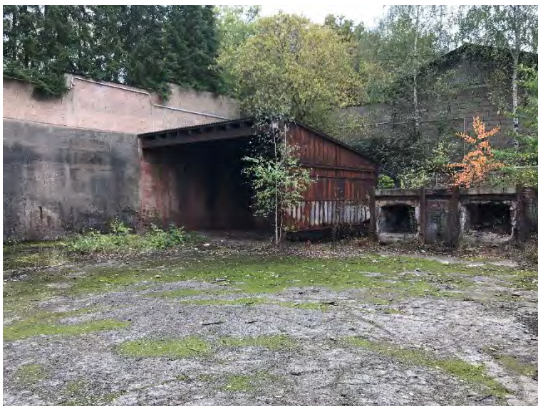
Betriebsgelände der ehemaligen Kabelverwertungsgesellschaft
