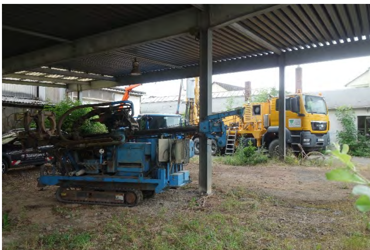
Messstellen-Rückbau auf dem ehemaligen Werksgelände
