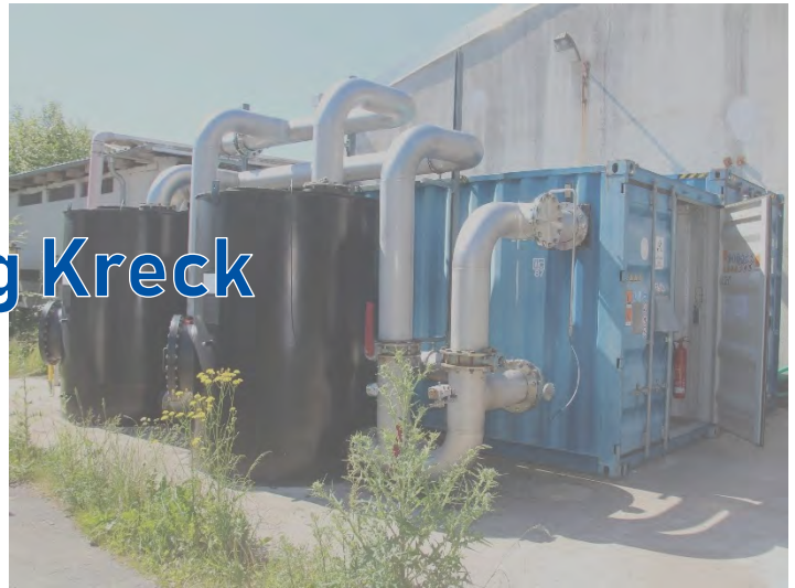
Bodenluft-Absaug- und Reinigungsanlage im Werksbereich
