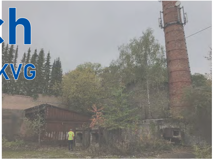
Betriebsgelände der ehemaligen Kabelverwertungsgesellschaft
