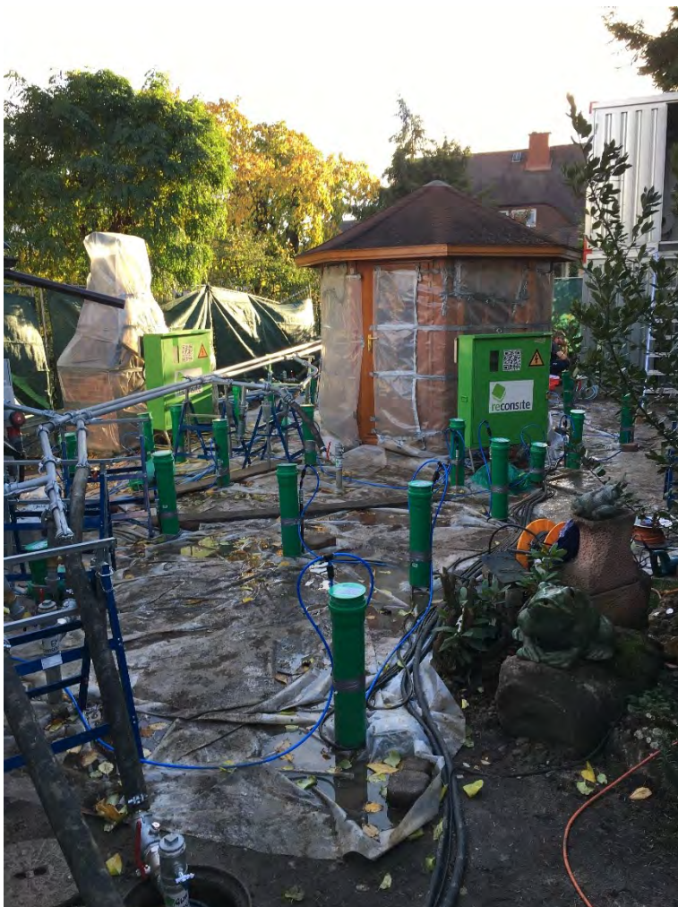
Einrichtungen zur thermischen Schadensherdsanierung
