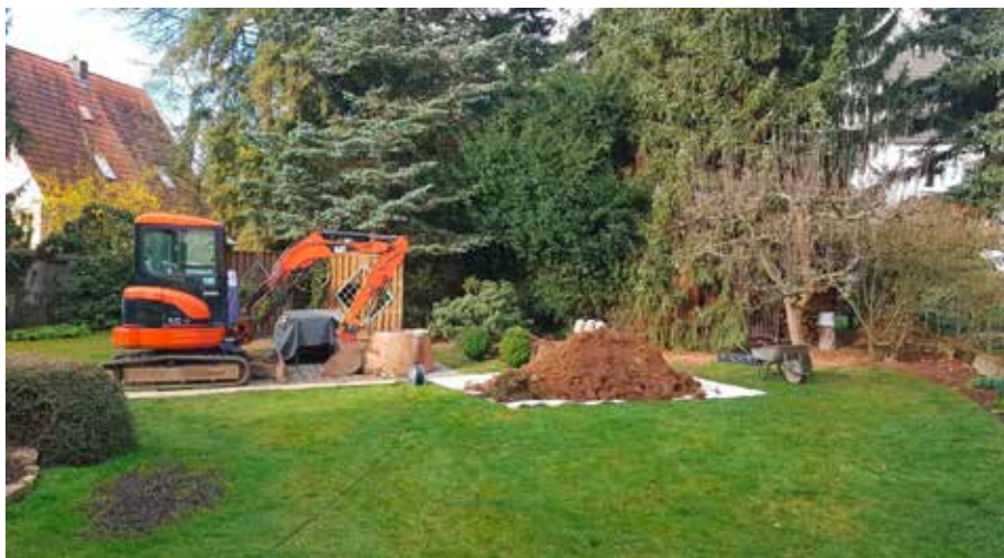
Rückbau der Messstelle GWM 51
