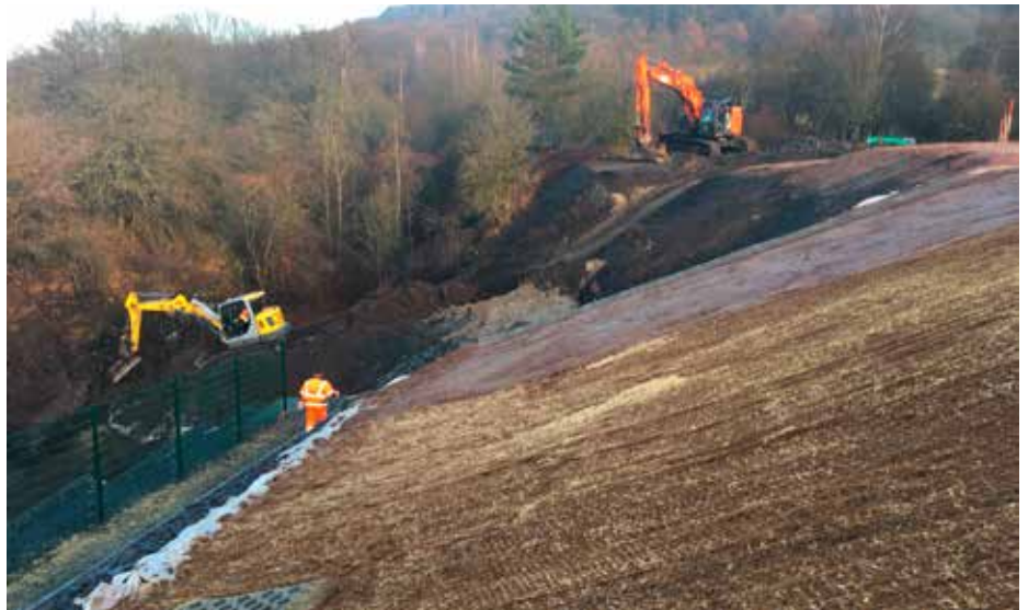
Rückbau der bauzeitlichen Rampe und Bodenandeckung, Stand 11/2019
