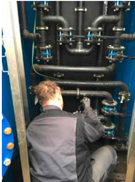
Montage Filterkreuz
