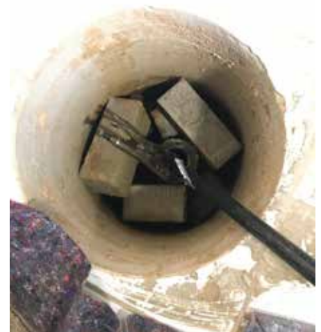
Injektion an IP 1
