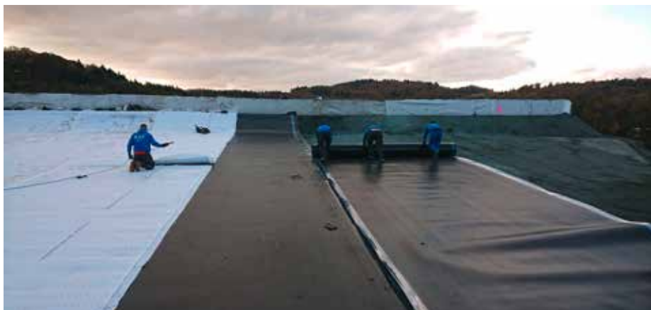
Laufende Abdichtungsarbeiten an der Halde, Stand 09/2019
