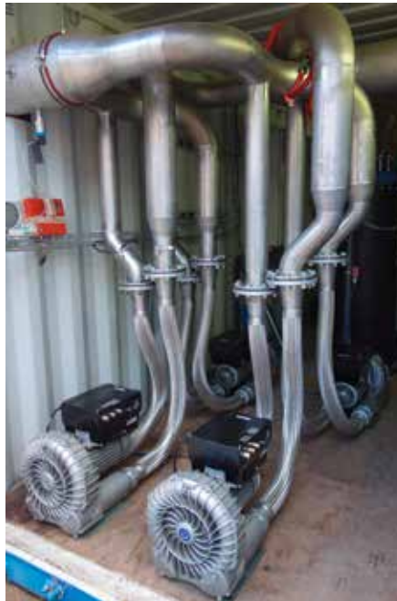
neue Absauganlage im zentralen Werksbereich
