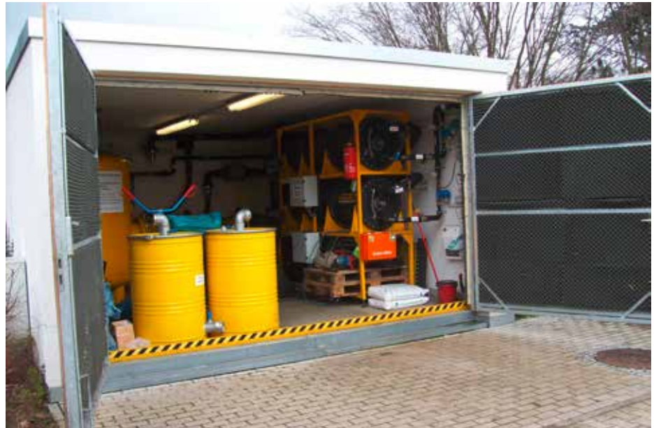
Grundwassersanierungsanlage
