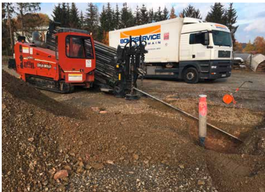
Anschluss eines neuen Sanierungsbrunnens an die WAA
