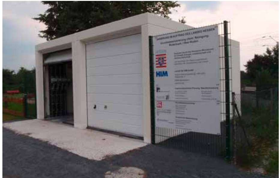
Grundwasserreinigungsanlage für den Sicherheitsbetrieb
