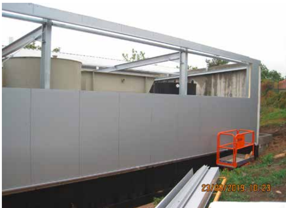
Bau der neuen Halle auf dem WAA-Gelände
