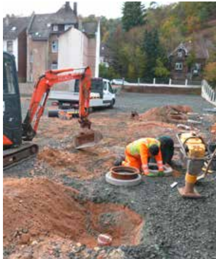
Sicherung der Drainagerohre mit Schachtringen
