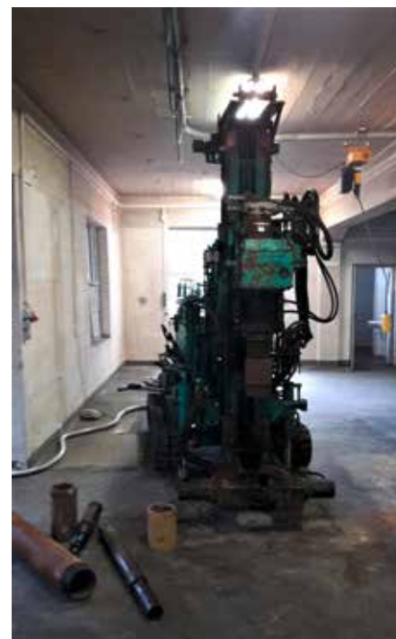
Erkundungsbohrungen im Altgebäude 253
