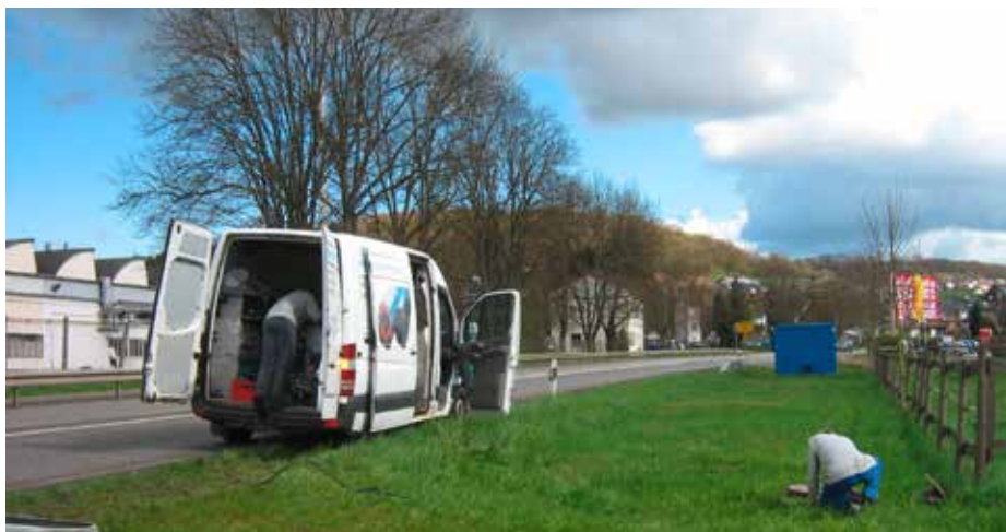
Reinigung Ablaufleitung Wasseraufbereitungsanlage
