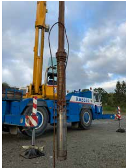
Pumpentausch mittels mobilem Kranfahrzeug
