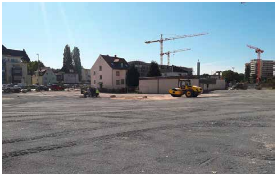
Blick auf das sanierte Vespermann-Gelände
