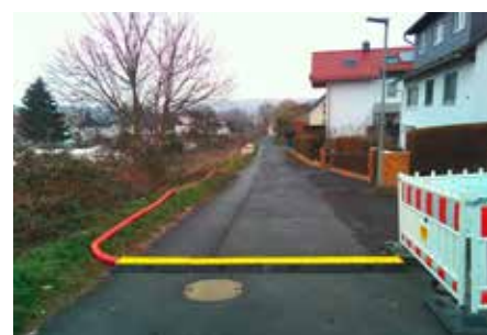
Leitungstrasse Pumpversuch an GWM9
