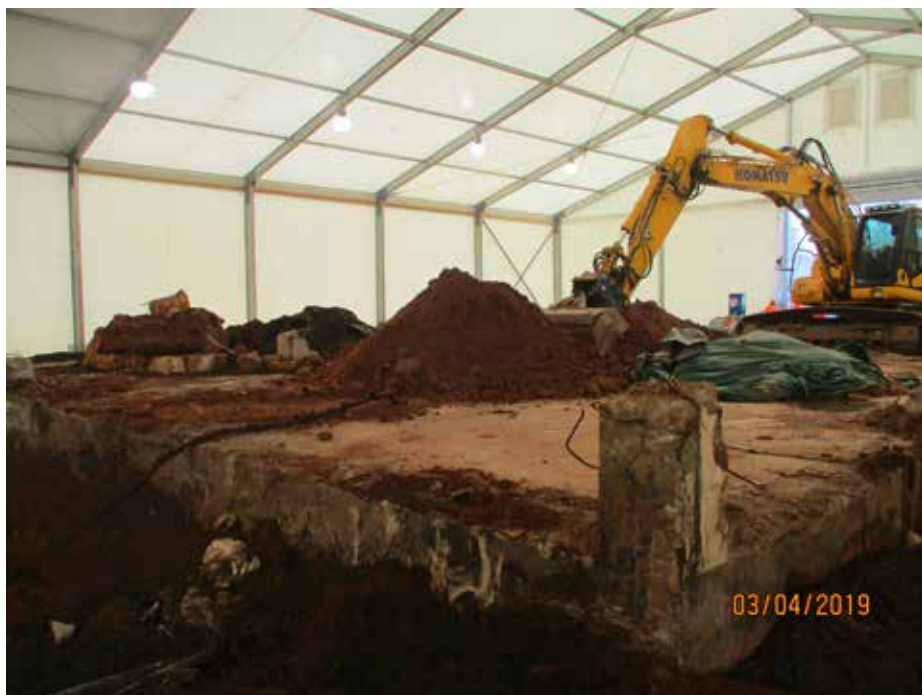
Einhausung Kellerfreilegung Altgebäude 256
