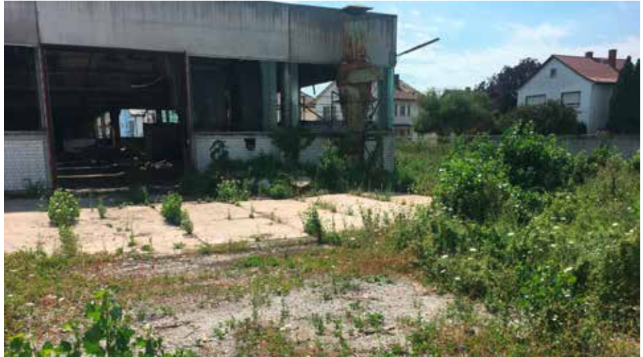
Gelände Werk II
