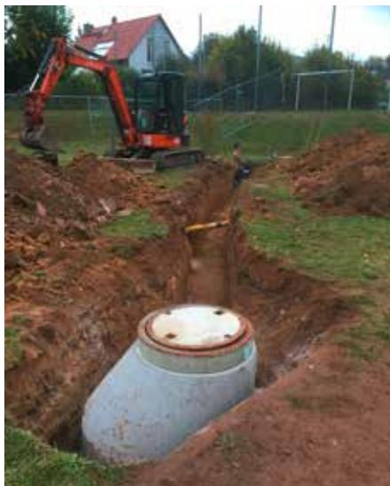
**Anschluss von GWM 77 als Brunnen an die Grundwasserreinigungsanlage**
