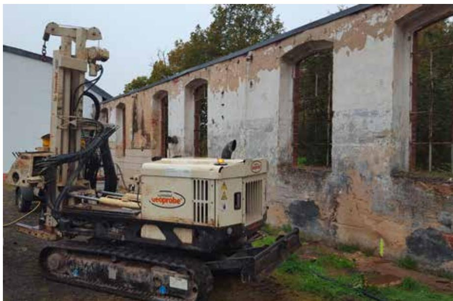
Durchführung von Injektionsbohrungen für Tracerversuch
