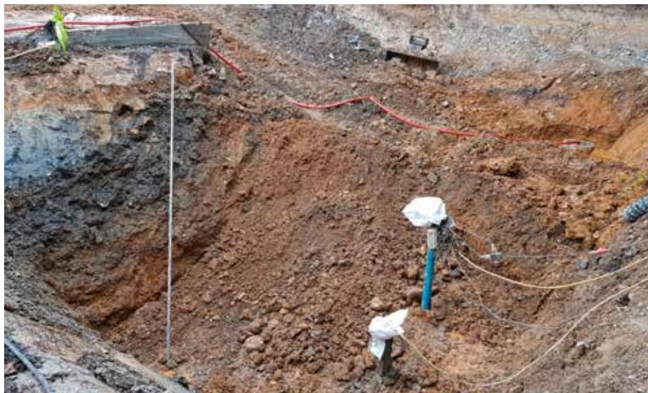
**Bodenaustausch Tanklager mit Grundwasserabsenkung über drei Brunnen**
