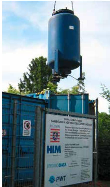
**Austausch eines Wasseraktivkohlefilters**
