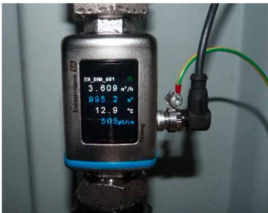
**MID an der Förderleitung des SB3 (Förderrate, Fördermenge, Temperatur, elektr. Leitfähigkeit)**
