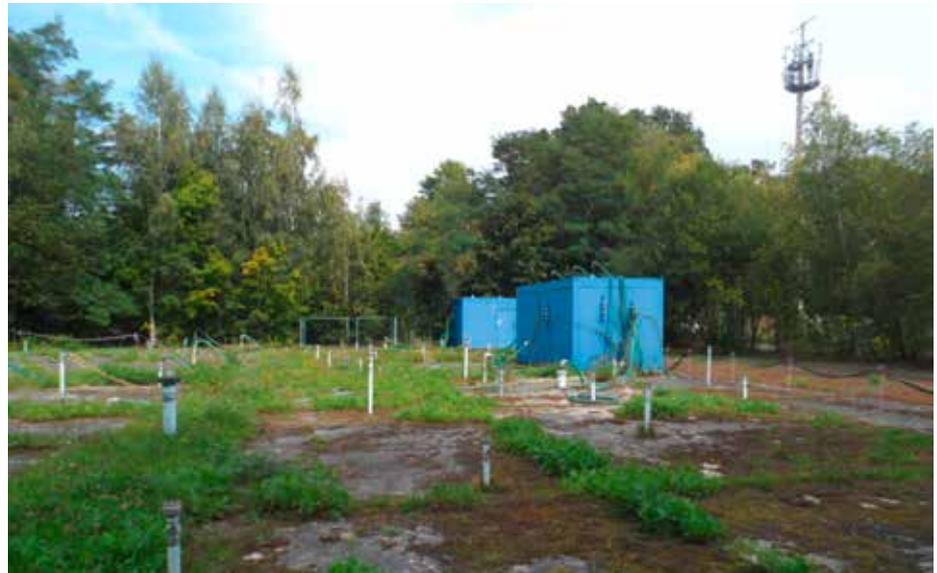
**Ehemaliges Betriebsgelände mit Bodenluftabsaug- und Air-Sparging-Anlage**
