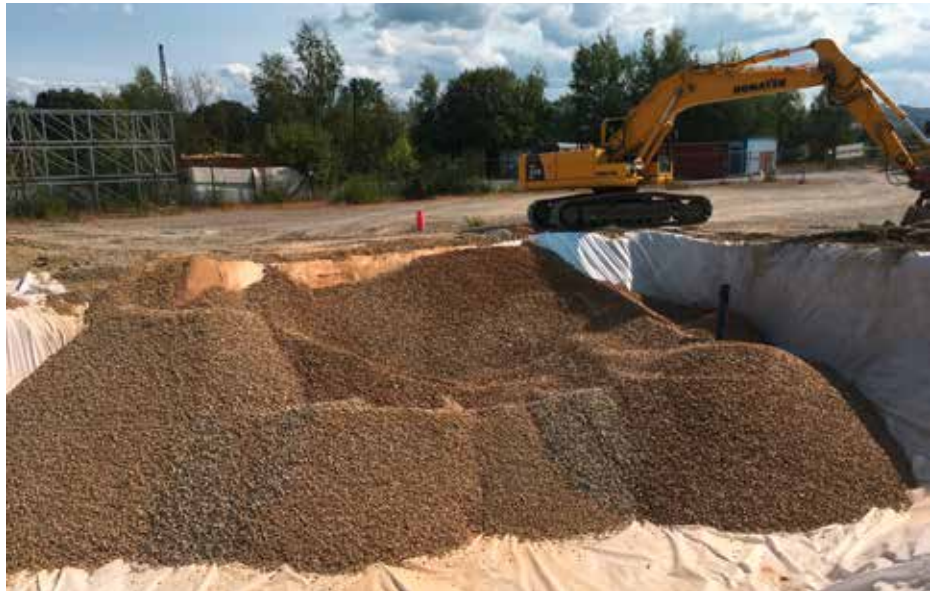
Neubau der Versickerungsrigole im August 2018
