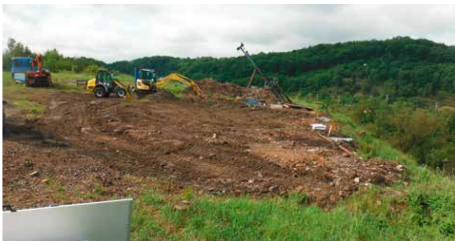
Ergänzende Haldenerkundung, Schrägbohrung, Mai 2018
