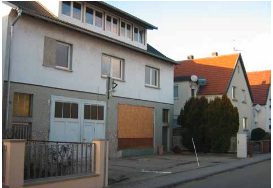
Gebäude der ehem. Chemischen Reinigung Müller in der Pfadgasse
