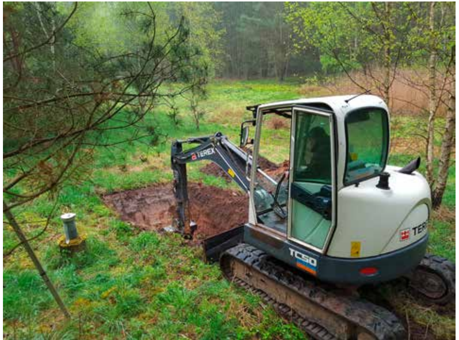
Baggerschurf im Bereich des Biotops
