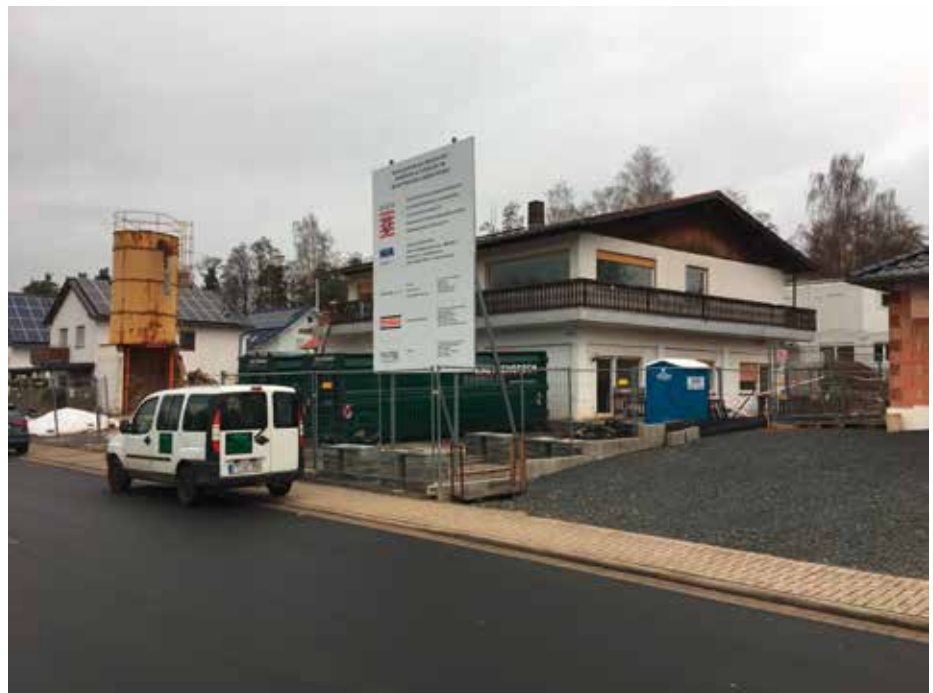
Altgebäude 256 vor Rückbau
