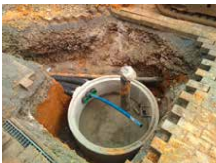
Graben-/Leitungsbau und Einrichtung Schachtbauwerk GWM28
