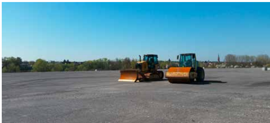
Zustand des Sanierungsbereichs nach Fertigstellung der Arbeitsebene
