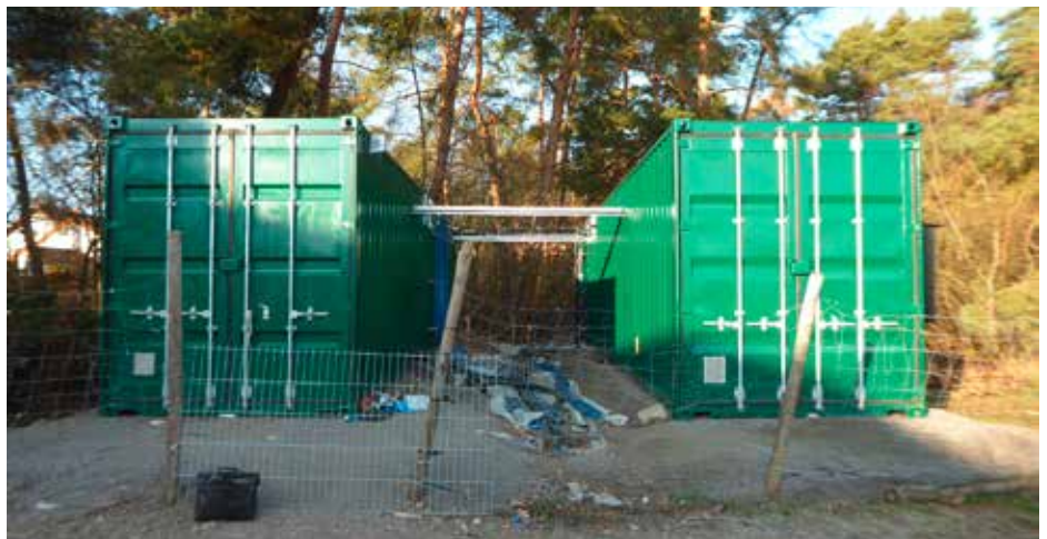
Ansetz- und Dosieranlage für Arsenmobilisierung
