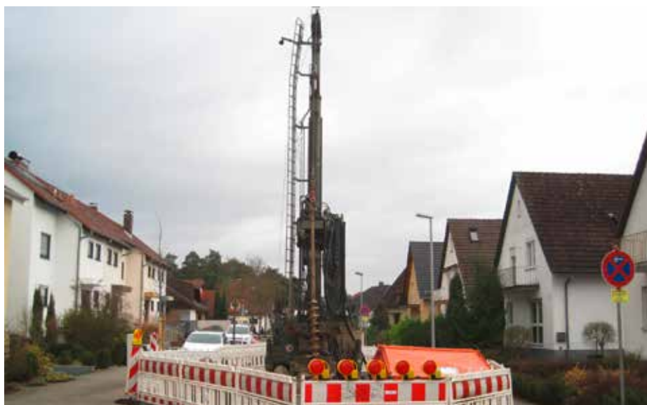
Brunnenbau im Schadenszentrum
