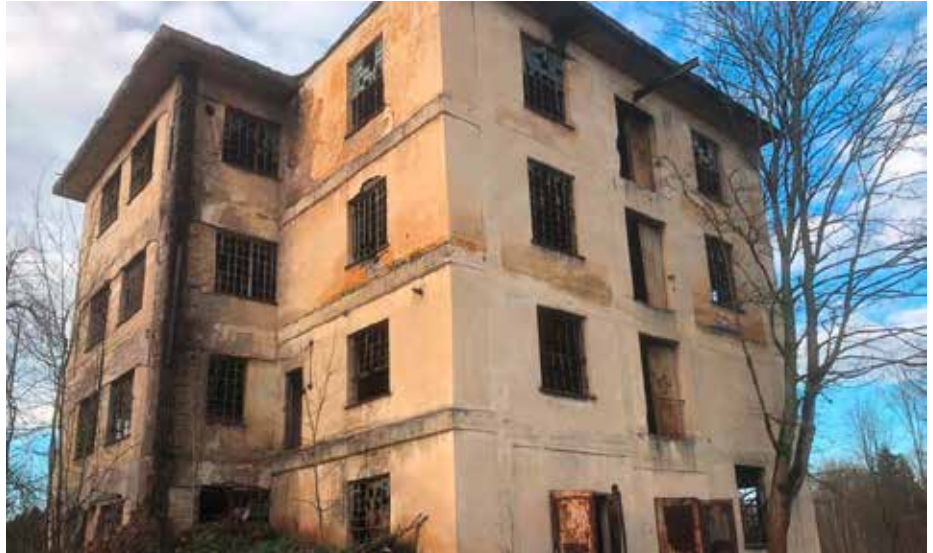
Ehemalige Denitrierung Hirschhagen, Daimlerstraße. Das Gebäude wird aktuell nicht genutzt.
