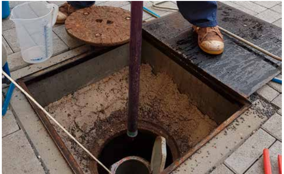
Reichweitenermittlung - Versorgung mit Natriumpermanganat
