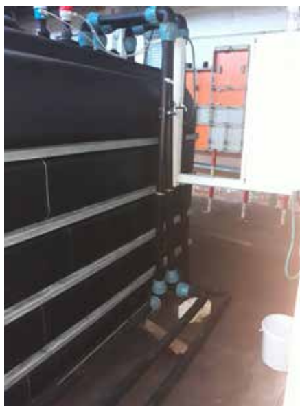
Vorlagebecken nördliches Schichtwasserbauwerk
