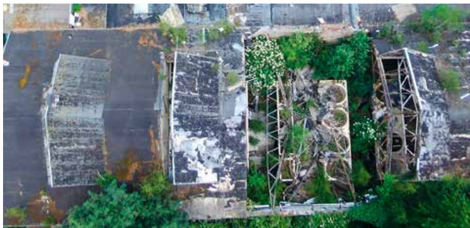
Luftbildaufnahme ehemalige Wasserwerkstatt und Färberei
