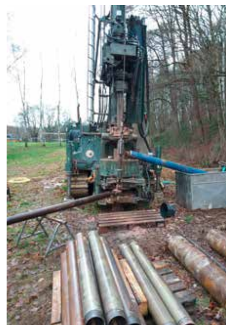
Messstellenbau im Ortsbereich von Richelsdorf
