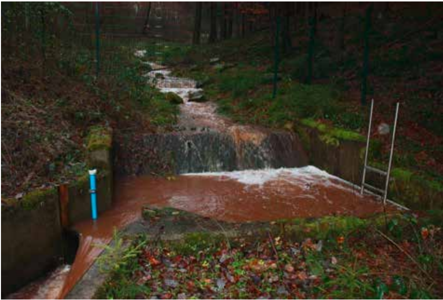
Hochwasser Rohrbach am Messwehr A2
