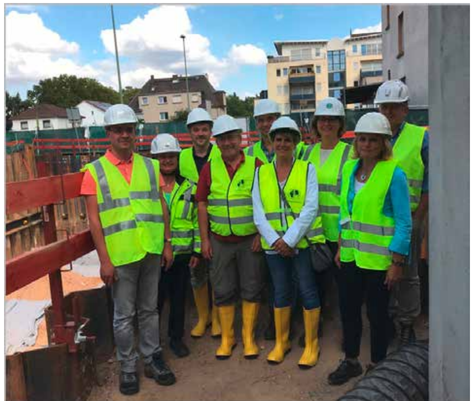
Vertreter des Umweltministeriums und des Regierungspräsidiums besuchten die Baustelle „Vespermann“ in Offenbach, um sich vor Ort ein Bild von den laufenden Sanierungsmaßnahmen zu machen
