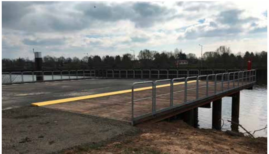
Teilfertiggestellter Schiffsanleger mit seitlicher Plattform
