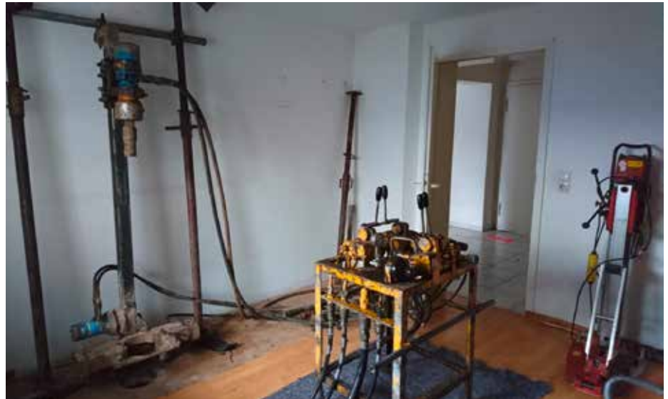
aufgebaute tragbare Handlafette für Bohrarbeiten im Gebäude
