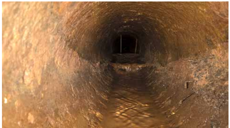
Kamerabefahrung eines bisher unbekanntes Kanals im Bereich der ehemaligen Fördereinrichtung BR 100
