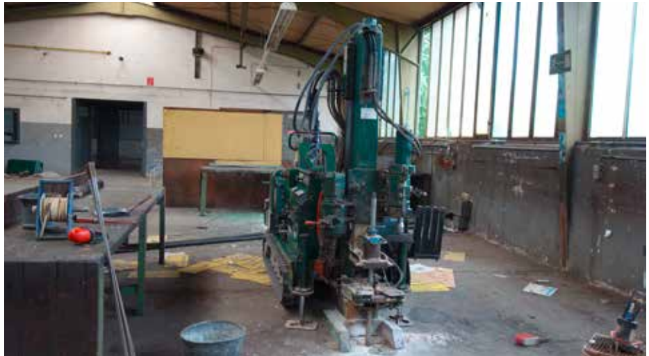
Direct-Push-Sondierungen in den ehemaligen Werkshallen
