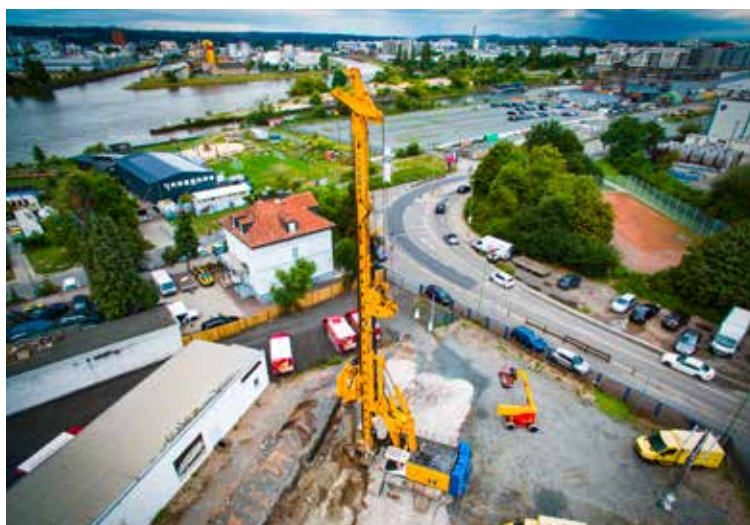
Bohrmaßnahmen im Bereich der östlichen Funnelstraße
