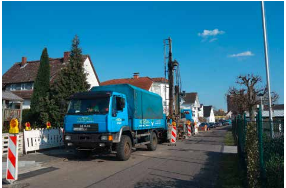
Brunnenbau im Wohngebiet
