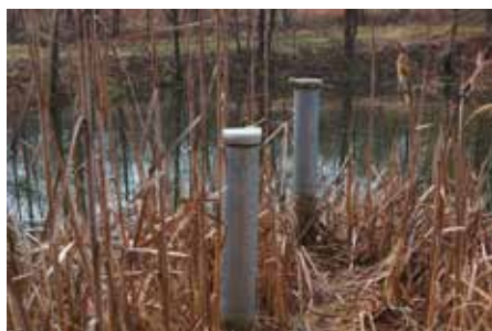
Grundwassermessstellen in dem im Abstrom des Altstandortes gelegenen Biotop
