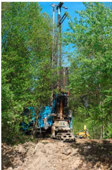
Brunnenbau auf dem Werksgelände
