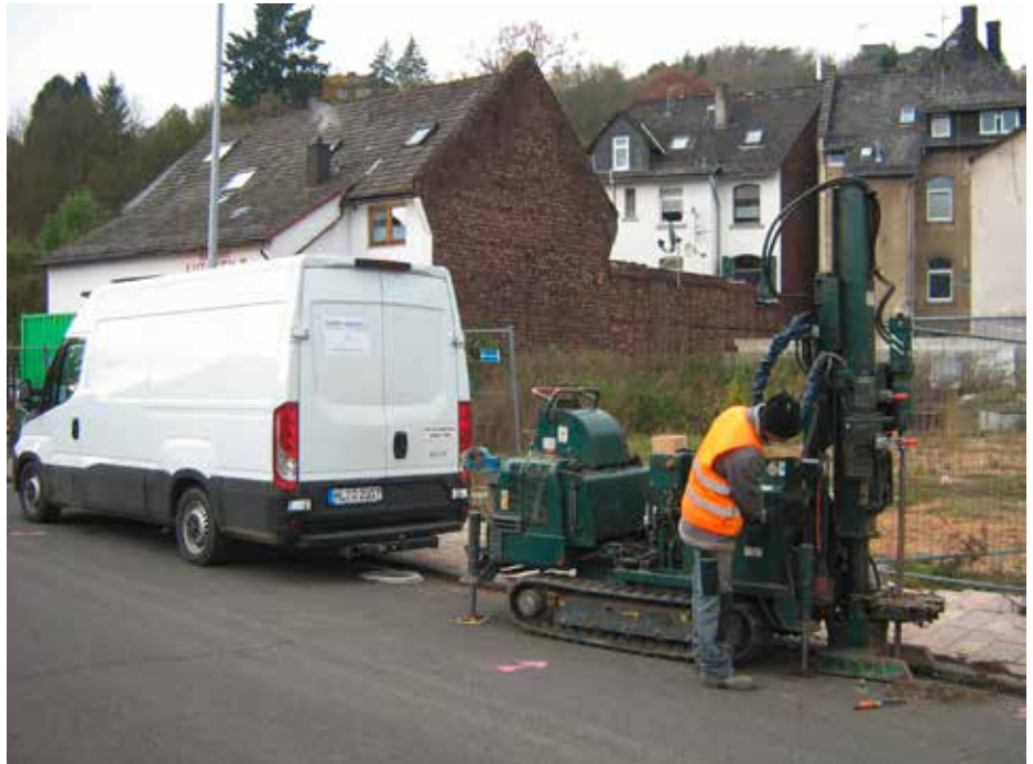
Abteufen der Direct-Push-Sondierung
