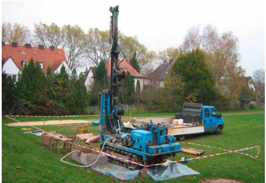
Errichtung Grundwassermessstelle an der Grenze Tertiär/Oberer Buntsandstein
