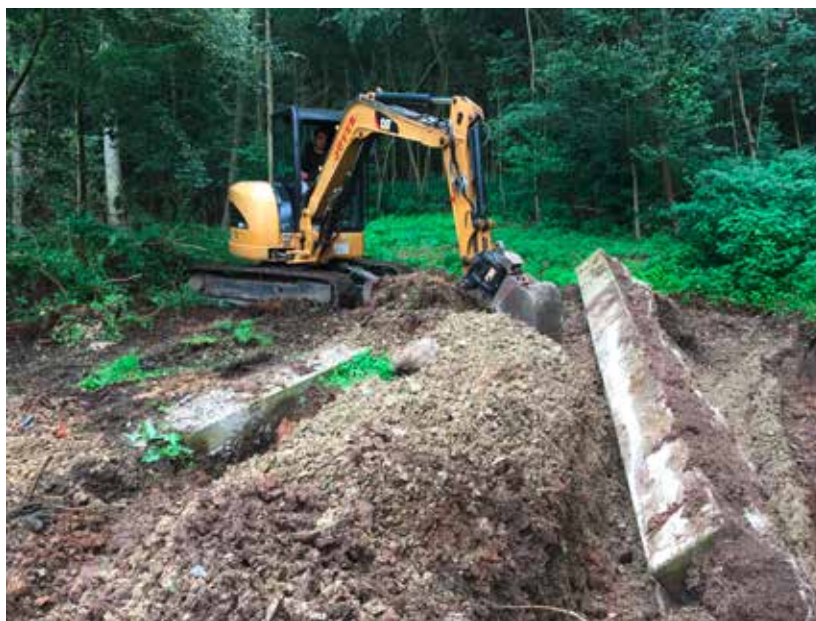
Rückbau von Streifenfundamenten in Sanierungszone III
