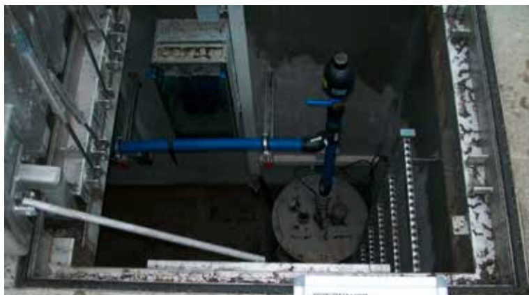
Blick in den Absenkbrunnen
