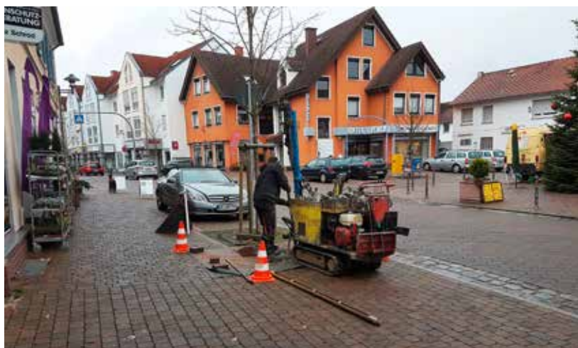
Direct-Push-Grundwassersondierungen im Oberstrom
