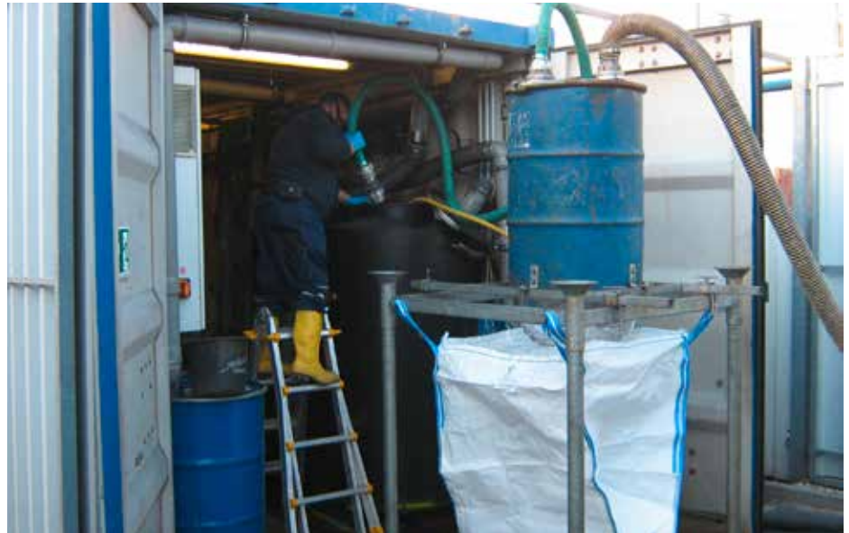
Wechsel Luft-Aktivkohle
