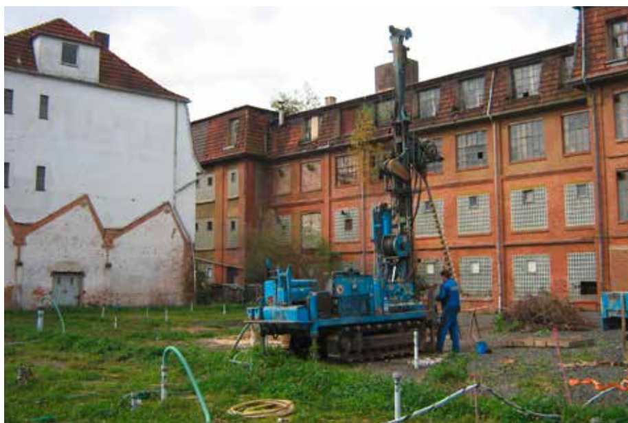
Errichtung neuer Injektionslanzen im Bereich des ehem. Betriebsgeländes
