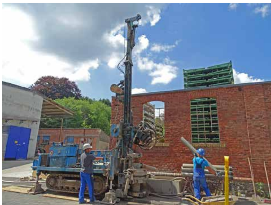
Bohranlage zur Errichtung der neuen Grundwassermessstellen
