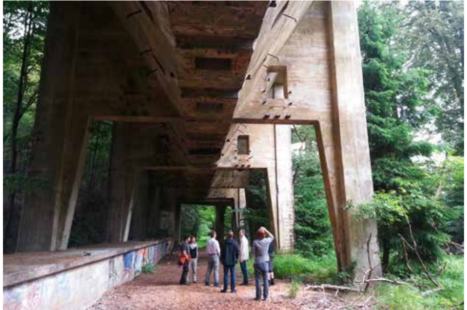
ehemaliger Kohle-Hochbunker Hirschhagen an der L3400, zu Betriebszeiten per Seilbahn an die Kohlegruben am Hirschberg angeschlossen
