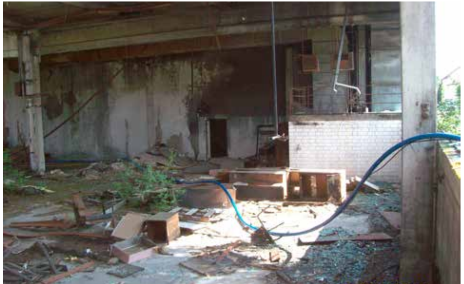
fliegende Leitungen durch das Werk II für den Pumpversuch an Messstelle BB 3
