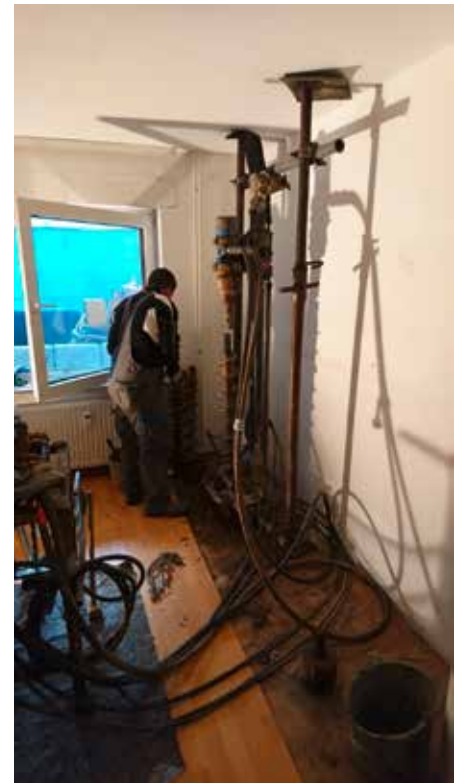
Bohrarbeiten im ehem. Wohnraum
