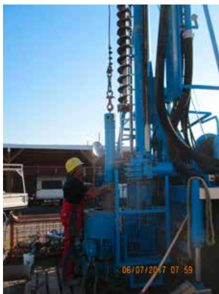
Bohrarbeiten zum Messstellenbau
