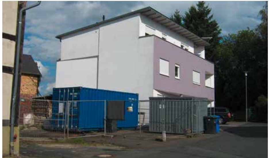
Standort der Sanierungsanlage
