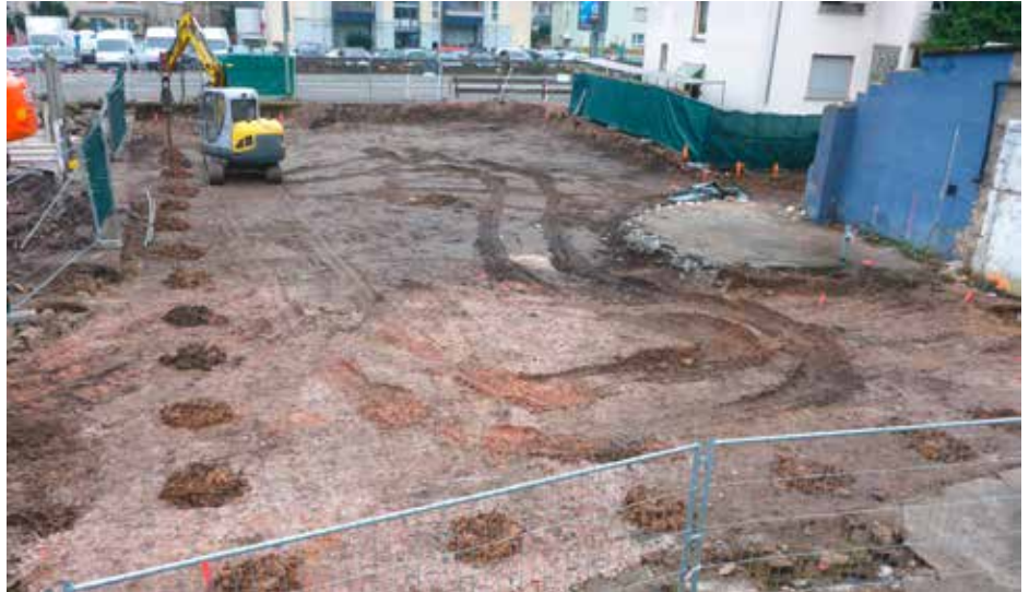
Kampfmittelfreimessung entlang der Spundwandachse, Dezember 2017
