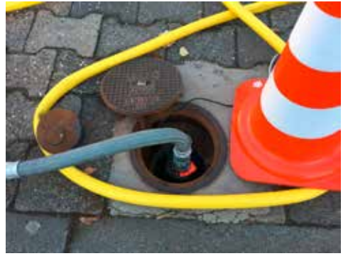
Eingabe der Pflanzenöl – Nährstoff – Emulsion in einen Brunnen der Bio-Barriere
