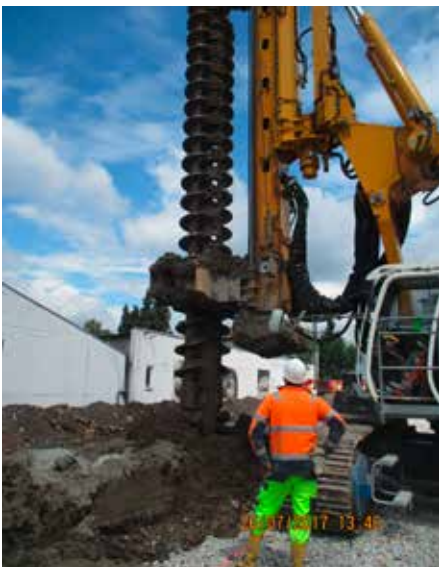
Einsatz des Mixed-in-Place-Bohrgerätes
