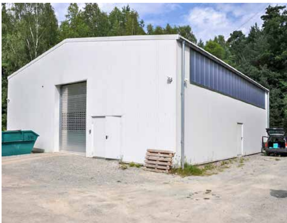
Wasseraufbereitungsanlage am Haldenfuß
