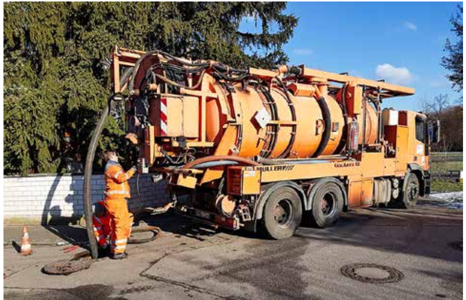
Leitungsspülung der Förderleitung Sanierungsbrunnen SBR 1neu
