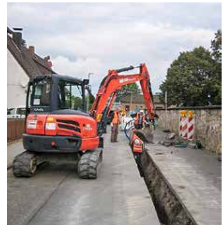
Leitungsverlegung für den neuen Sanierungsbrunnen (SBR 9neu) in der Sebastianusstraße
