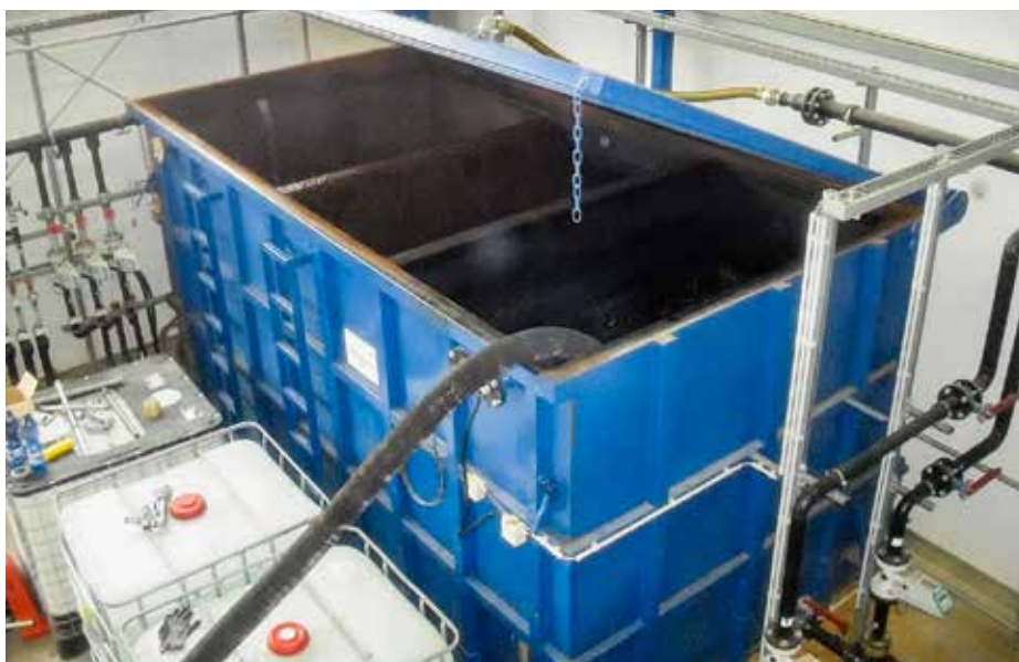
Reinigung Vorlagebehälter in der Sanierungsanlage
