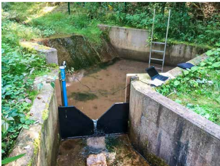
Abflussmesstelle A2, Rohrbach Kontinuierliche Messung der Wasserstandes über Logger (links) und manuelle Abfluss-Kontrollmessungen über Messwehr (Mitte)
