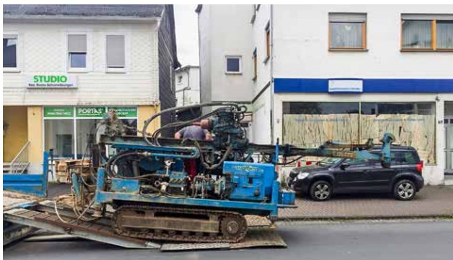
Einrichtung des Bohrgerätes – Überbohren der Sanierungsbrunnen
