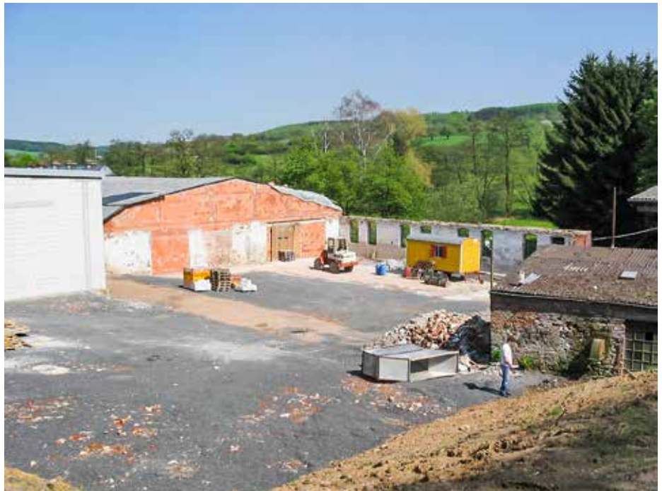
ehem. Walkerei (Schadensherd) nach Rückbau des Gebäudes
