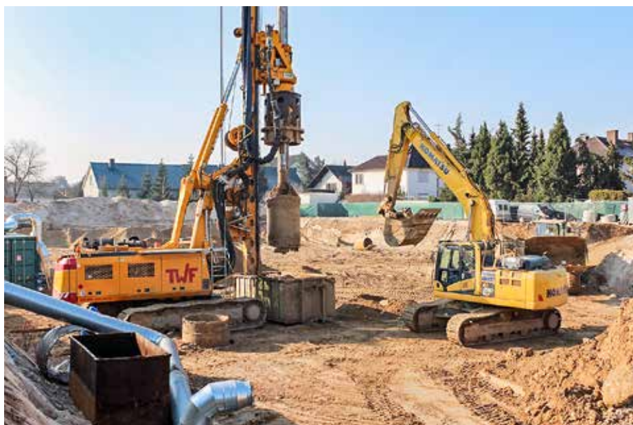
Bohrgerät und Baustelle
