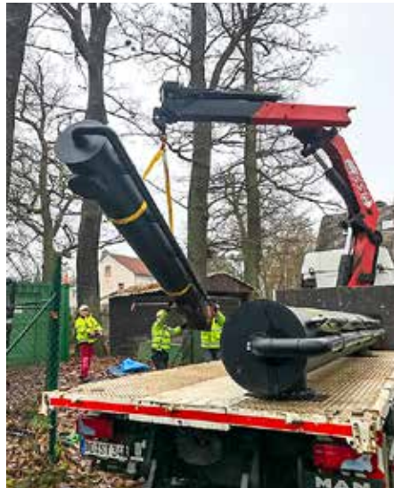
Rückbau der Sanierungsanlage
