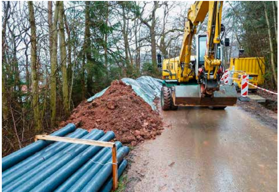
Leitungsarbeiten in kontaminiertem Gebiet, Lokalschaden Eschenstruth
