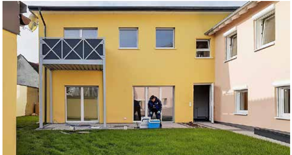
Grundstück nach erfolgter Teilsanierung
