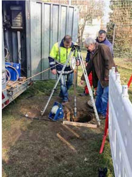
Kamerabefahrung am Sammelschacht der Flächendrainage
