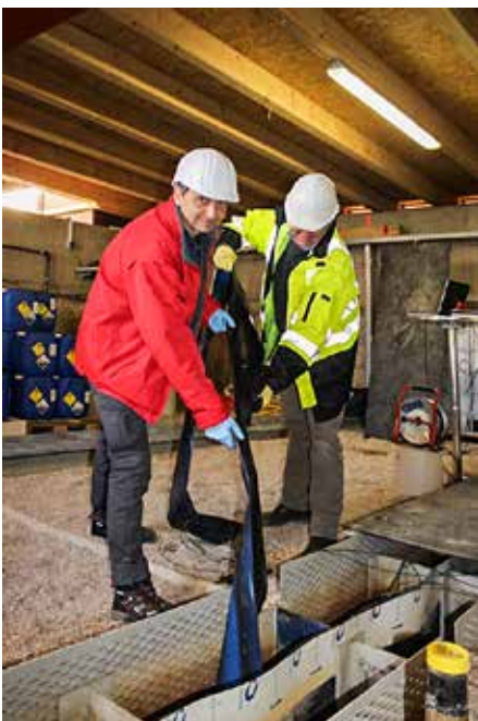
Verbinden der beiden Reaktorstraßen
