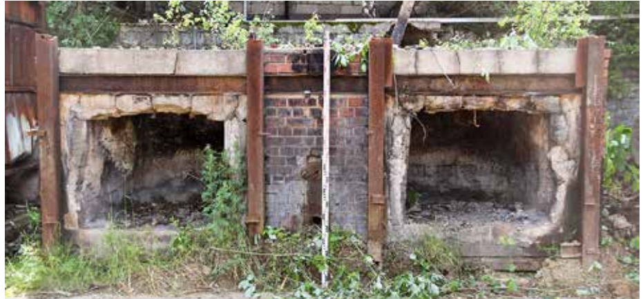
ehemalige Öfen zur Kabel-Verschmelzung auf dem Altstandort
