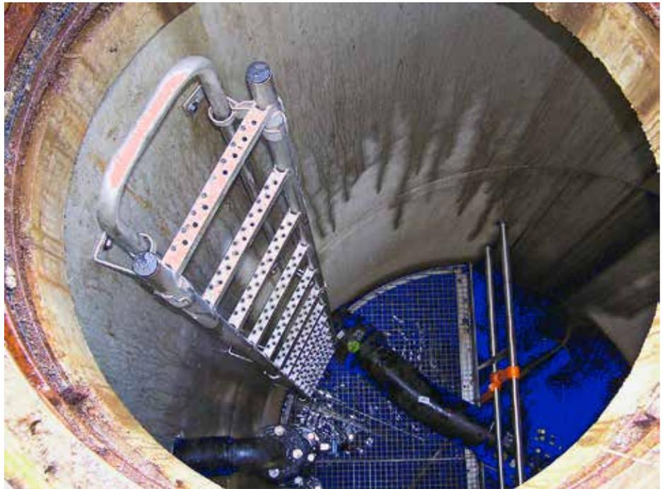
**Schacht 109 zur Fassung von Wässern aus dem ehem. Standortkanalsystem; Schacht stillgelegt gemäß 1-kg-Kriterium**
