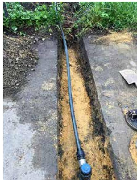
**Anschluss von Bodenluftpegeln an die Bodenluftsanierungsanlage**
