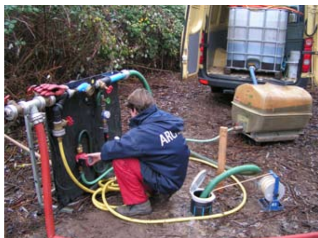
Injektion von Melasse
