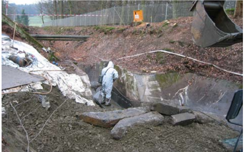
Sanierung Münchbach und Tri-Graben
