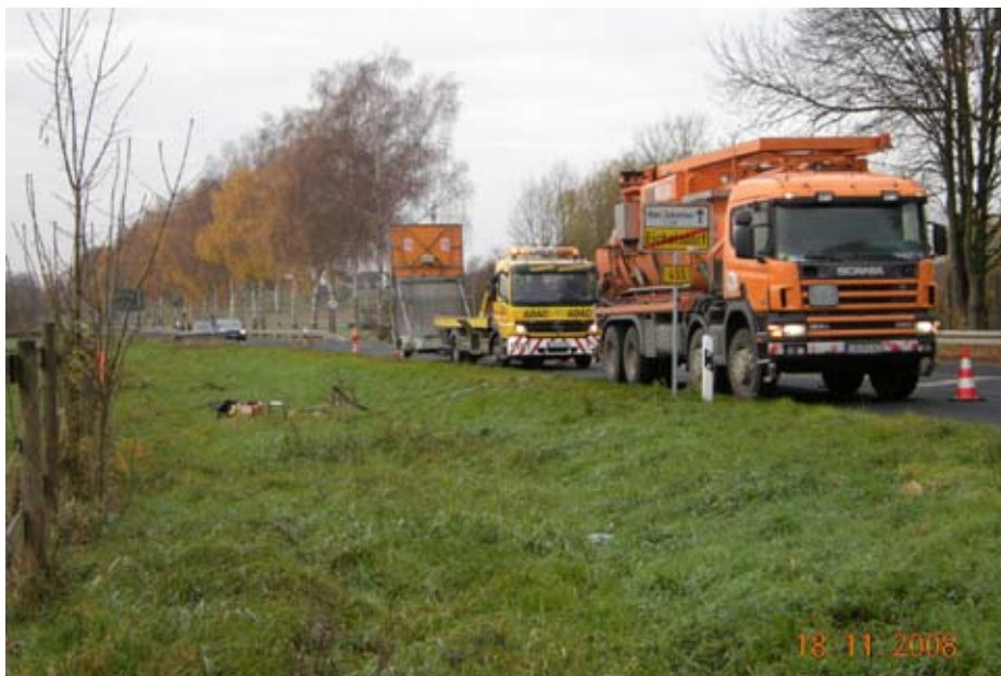
Absaugung von Teeröl aus dem Grundwasser
