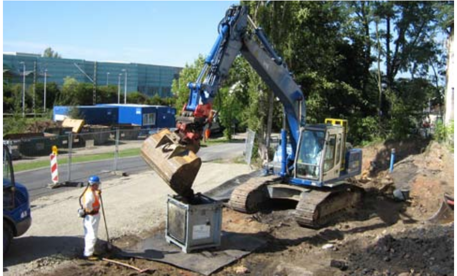
Blick auf das Baufeld während der Sanierungsmaßnahme
