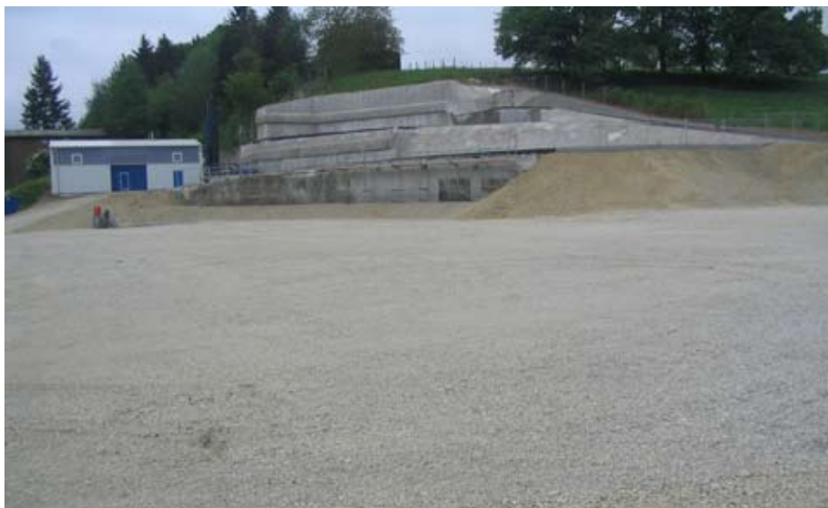
Betriebsgelände nach Abschluss der Bodensanierung Hintergrund: gesicherte Stützmauern und Grundwassersanierungsanlage
