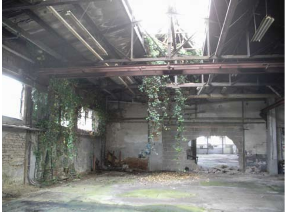
ehem. Werkhalle FAGRO GmbH
