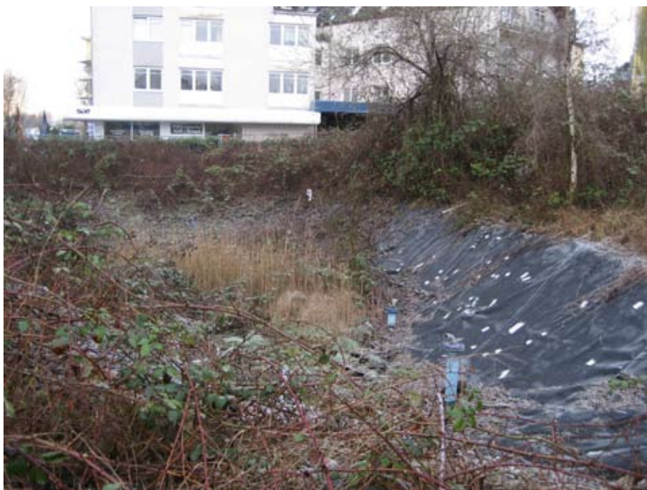
Baugrube mit angrenzender Wohnbebauung
