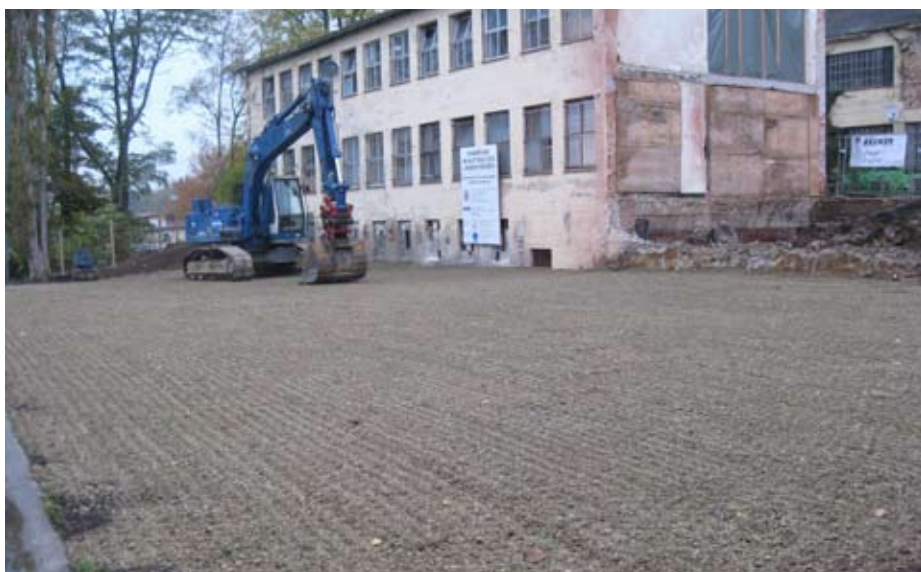
Blick auf das Baufeld nach Abschluss der Sanierungsmaßnahme
