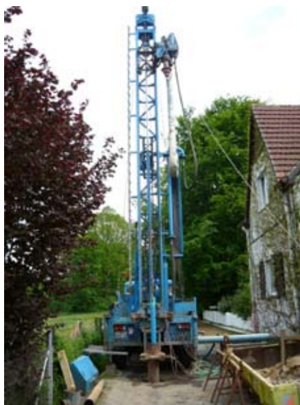
Errichtung einer Grundwassermessstelle im Kluffgrundwasserleiter
