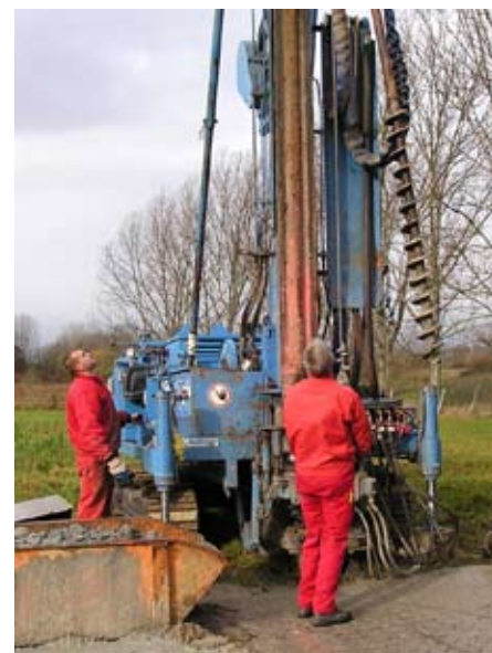
Beprobung einer Grundwassermessstelle innerhalb der Deponie
