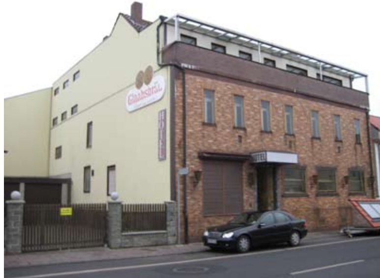
Blick von Südwesten auf das ehemalige Hotelgebäude
