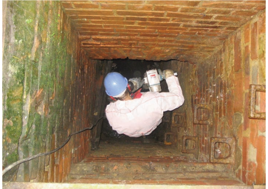
Sondierung im Einstiegsschacht des Grobabscheidebeckens
