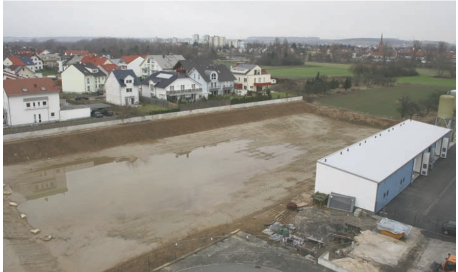
sanierte und teiltrückverfüllte Fläche der Bundesliegenschaft
