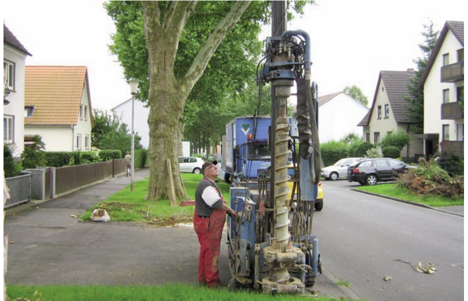
Errichtung von Bodenluftmessstellen in der Schadstofffahne
