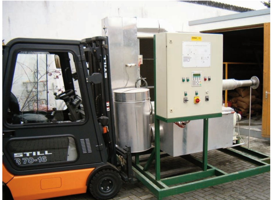
Demontage katalytische Oxidationsanlage
