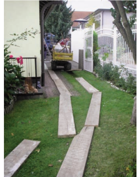
Vorbereitung der Bohrarbeiten im Bereich der Wohnbebauung (sehr stark eingeschränkte Platzverhältnisse)
