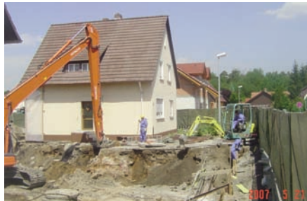
Aushubarbeiten im Bereich Lindenweg, 7. Sanierungsbaustelle, 2. Abschnitt
