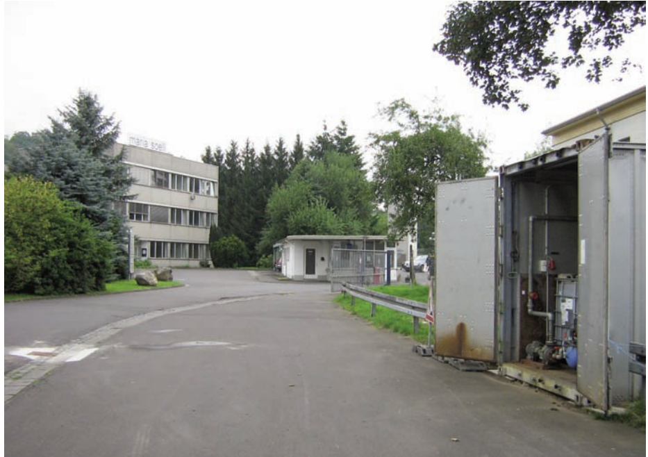
Betriebsgelände mit Blick auf das Pförtnerhaus (GW-Sanierungsanlage rechts im Bild)
