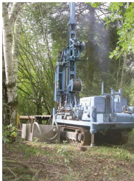
Brunnenbauarbeiten im Grüngürtel um die ehemalige Fa. Mertens
