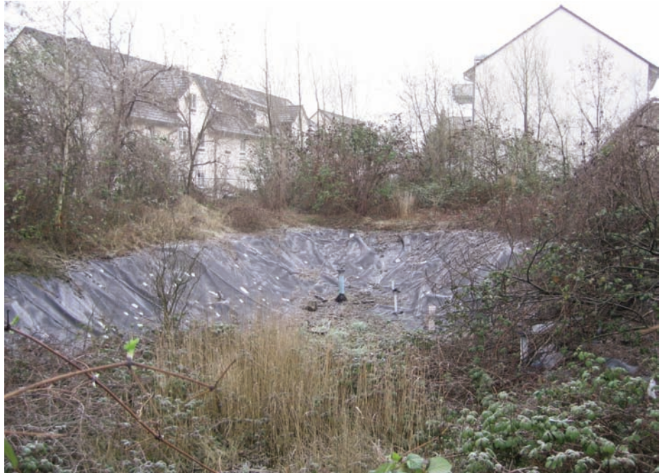
Baugrube mit angrenzender Wohnbebauung
