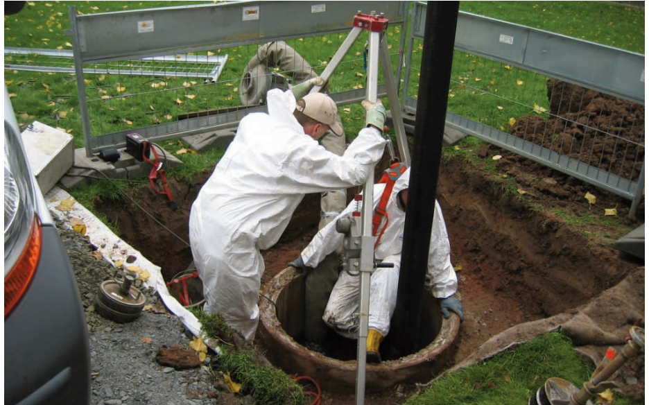
Kanalstilllegung
