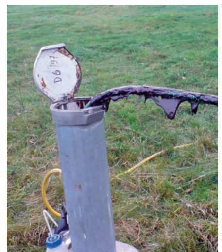
Messstellenbeprobung innerhalb der Deponie
