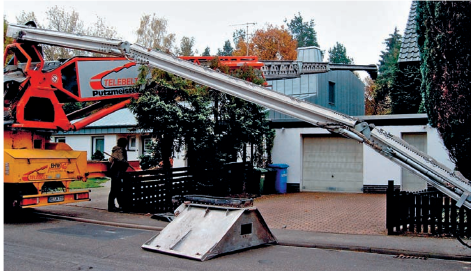
Einsatz Teleskopförderband bei der Rückverfüllung einer Baugrube
