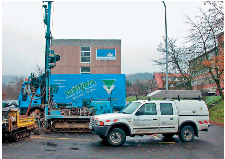
Brunnenbauarbeiten auf einem der ehemaligen Fa. Linn + Lange angrenzenden Werksgelände
