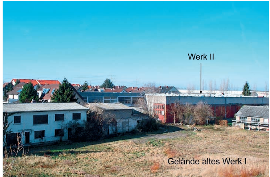
Blick über das sanierte Gelände des Werks I auf Werk II
