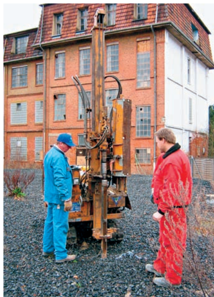
Errichtung von Bodenluftpegeln im Schadenszentrum
