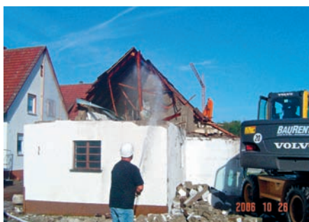
Rückbau eines Nebengebäudes, 2. Sanierungsabschnitt
