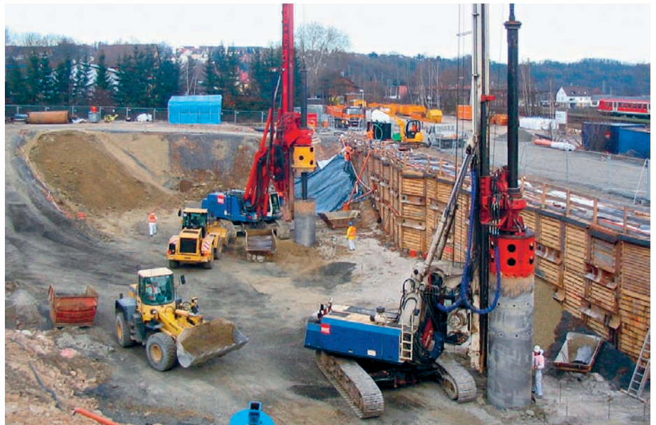
Nach dem Voraushub bis in ca. 5,5 m Tiefe wurden Großbohrungen durchgeführt
