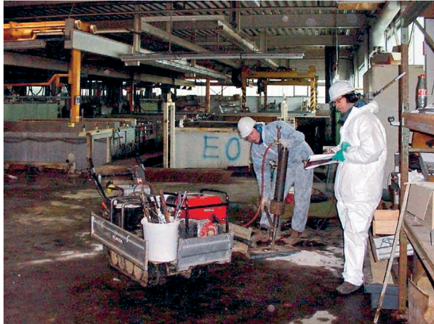
Erkundungsarbeiten in der ehemaligen Betriebshalle
