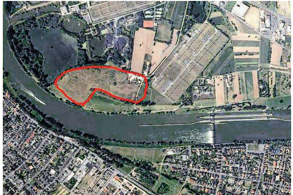
Luftbild Altdeponie mit Deponierand
