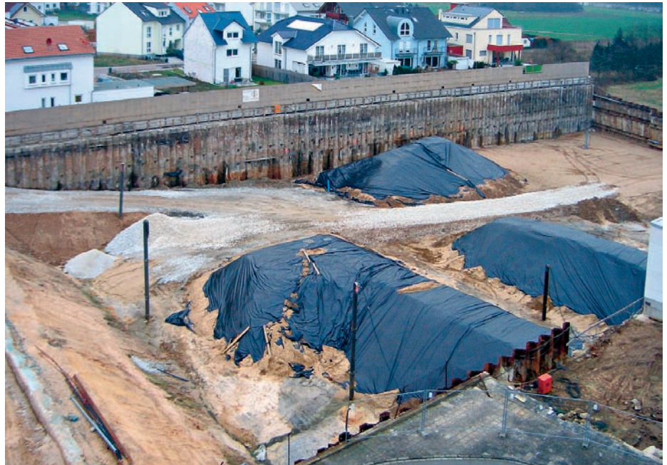
Überblick Sanierungsbereich mit Sanierungsgrube der Bundesliegenschaft im Vordergrund
