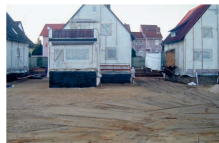
Herstellen des Planums für die Sickerwassersperrschicht
