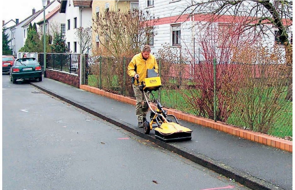
Überprüfung der Ansatzpunkte auf Kampfmittel mittels Geo-Radar
