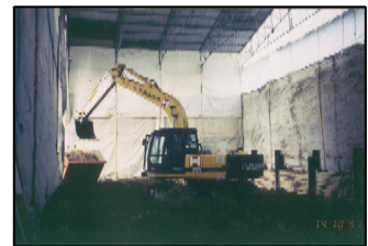
Bodenaushub im Zelt
