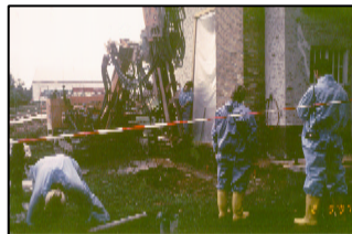
Betoninjektion zur Gebäudesicherung
