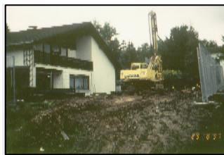
Setzen von Trägern der Trägerbohlwand
